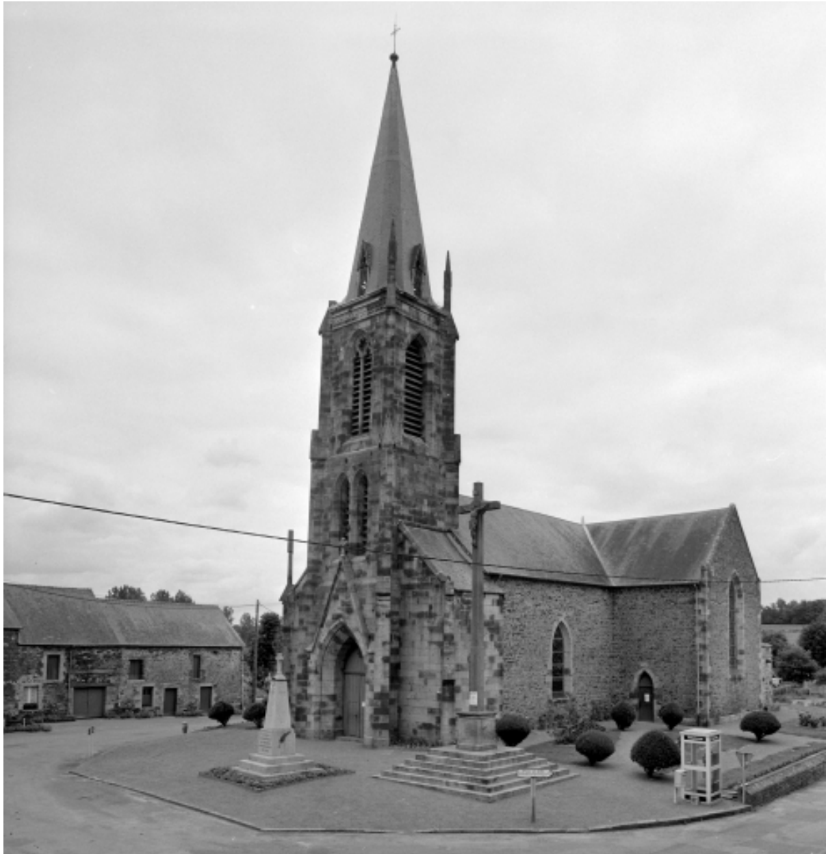
Elévation Sud-Ouest : vue générale
