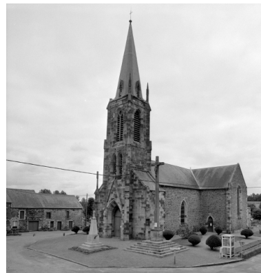
Elévation Sud-Ouest : vue générale Phot. Guy Artur, Phot. Norbert Lambart IVR53_19943501269X
