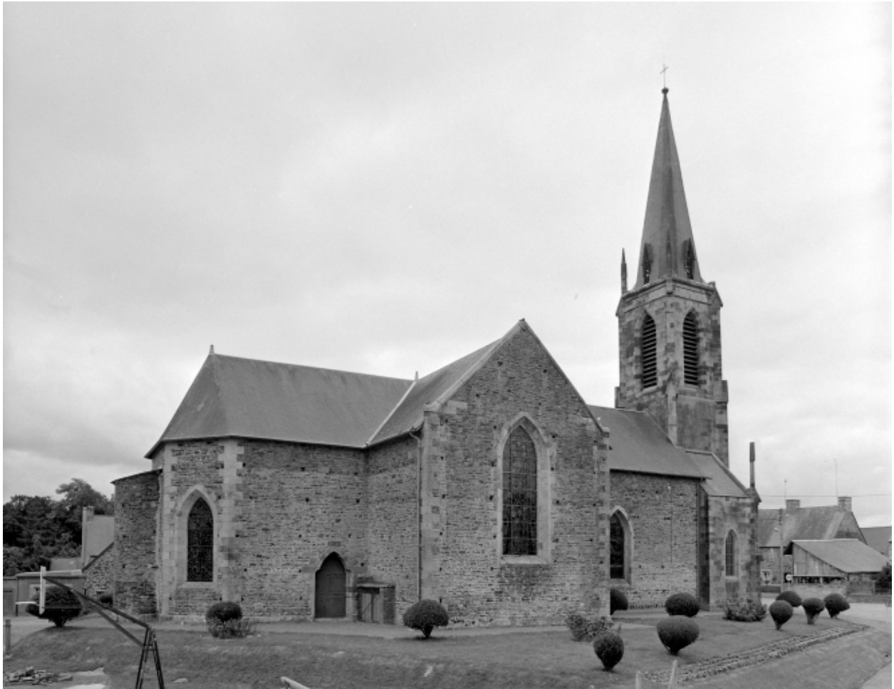
Elévation Nord : vue générale
