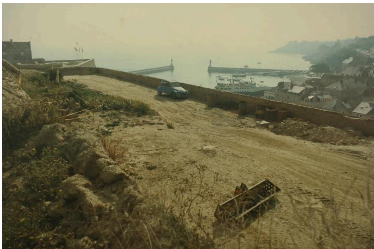
Le Palais, citadelle, vue du bastion 2 pendant la restauration.
