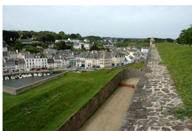
Vue de la citadelle de Belle-île : face du bastion du Dauphin. En arrière-plan : le bourg de Le Palais Phot. Guillaume Lécueillier IVR53_20065605329NUCA
