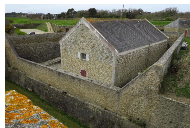
Le Palais, citadelle, éléments du 19e siècle, magasin à poudre de l'Avancée. Phot. Lionel Duigou IVR53_20175606690NUCA
