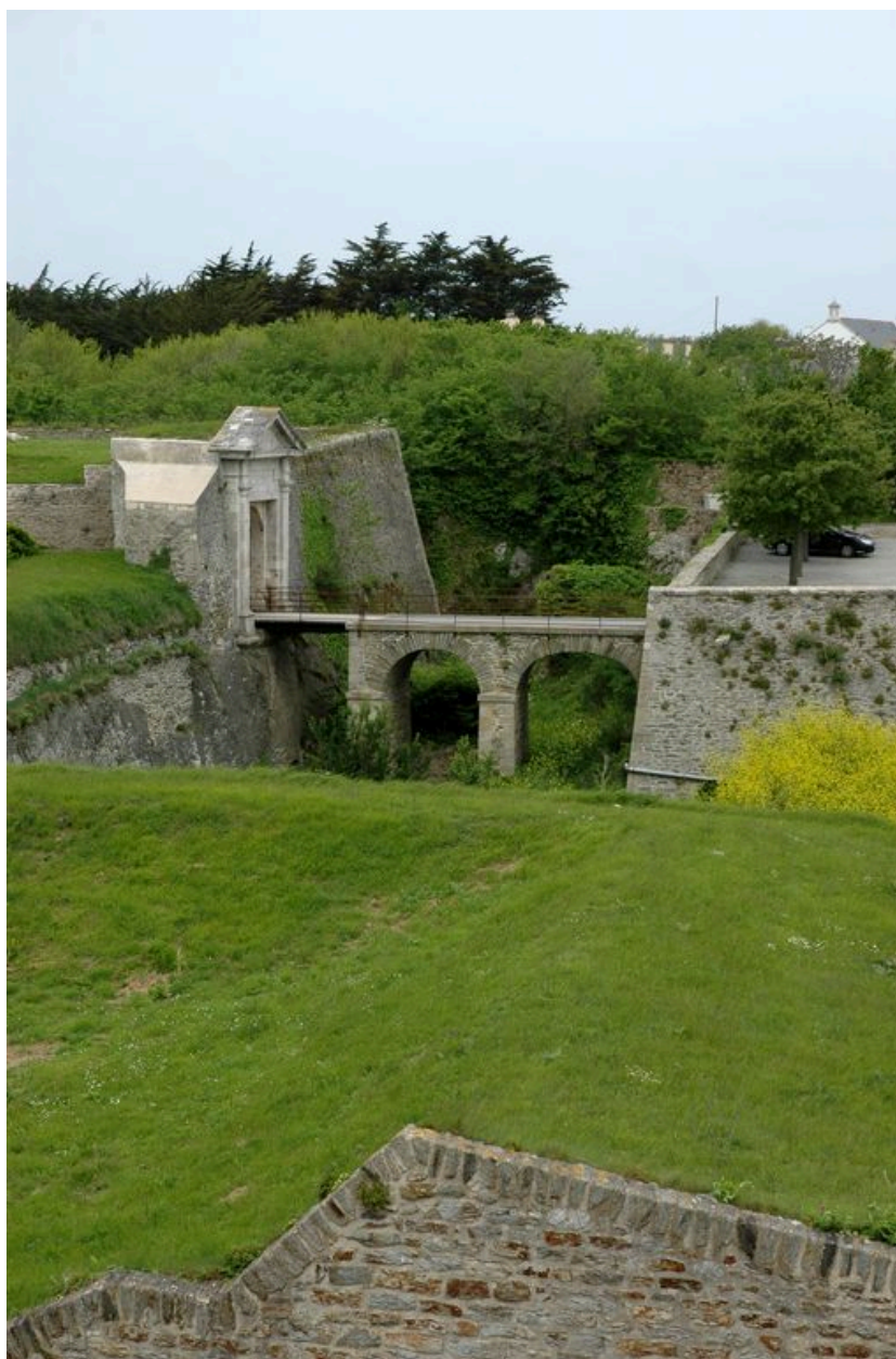
Vue de la citadelle de Belle-île : la porte de l'Avancée dite porte de Secours
