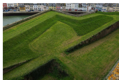
Le Palais, citadelle, éléments du 19e siècle, fronts sud. Phot. Lionel Duigou IVR53_20175606703NUCA
