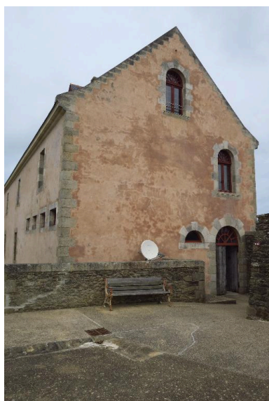
Le Palais, citadelle, éléments du 19e siècle, pignon sud du Grand Quartier. Phot. Lionel Duigou IVR53_20175606712NUCA
