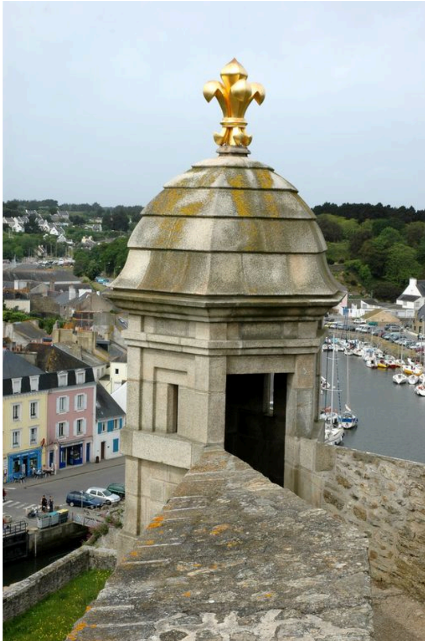
Vue de la citadelle de Belle-île : échauguette du bastion du Dauphin
