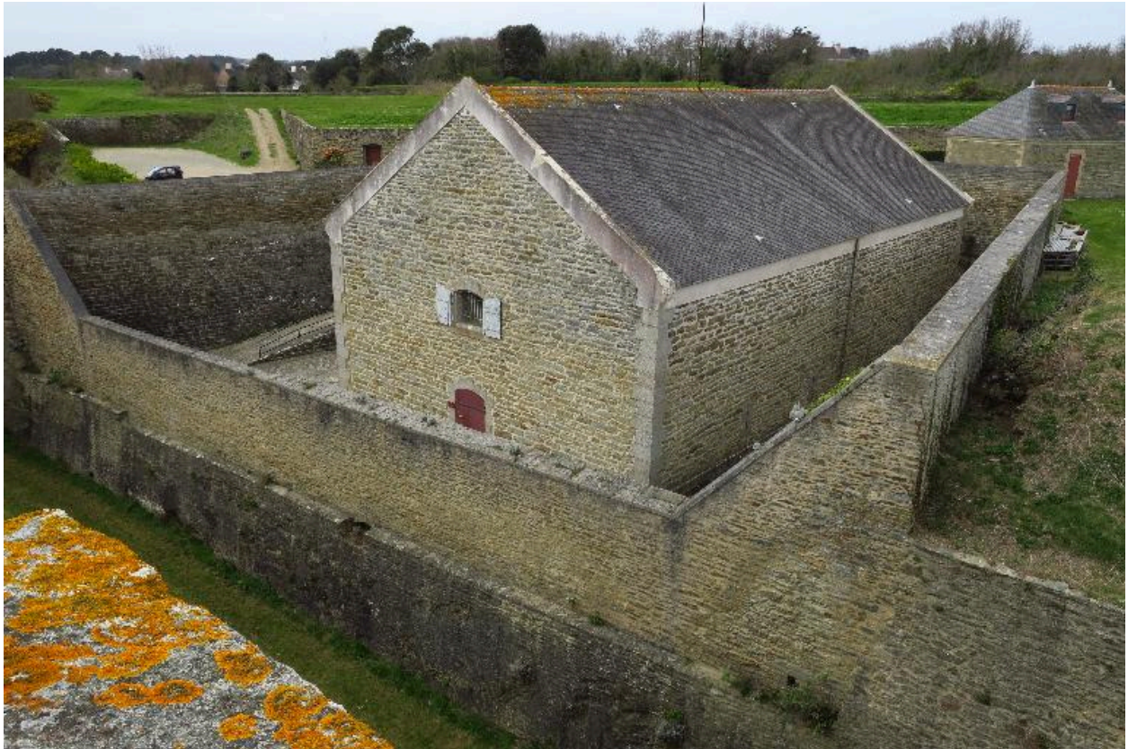
Le Palais, citadelle, éléments du 19e siècle, magasin à poudre de l'Avancée.
