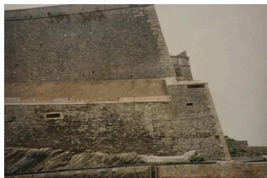
Le Palais, citadelle, vue de la fausse-braie 5 en cours de restauration en 1992. IVR53_20175607044NUCA
