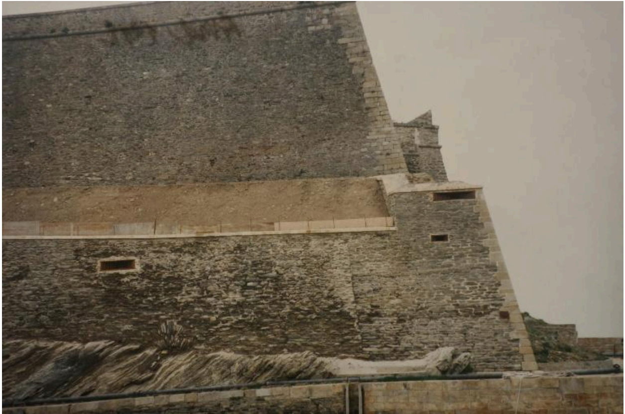
Le Palais, citadelle, vue de la fausse-braie 5 en cours de restauration en 1992.
