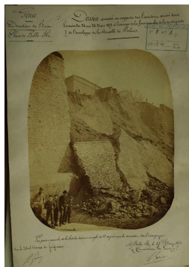
1 VH 297. Place de Belle-Ile-en-Mer, dessin annexé au rapport sur l'accident arrivé dans la nuit du 24 au 25 mars 1873 à l'escarpe de la face gauche de la contregarde 7 de l'enveloppe de la citadelle de Palais, 27 mars 1873.
