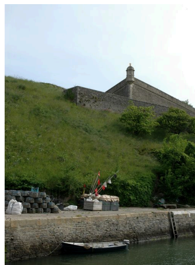
Vue de la citadelle de Belle-île : échauguette du bastion du Dauphin Phot. Guillaume Lécueillier IVR53_20065605321NUCA
