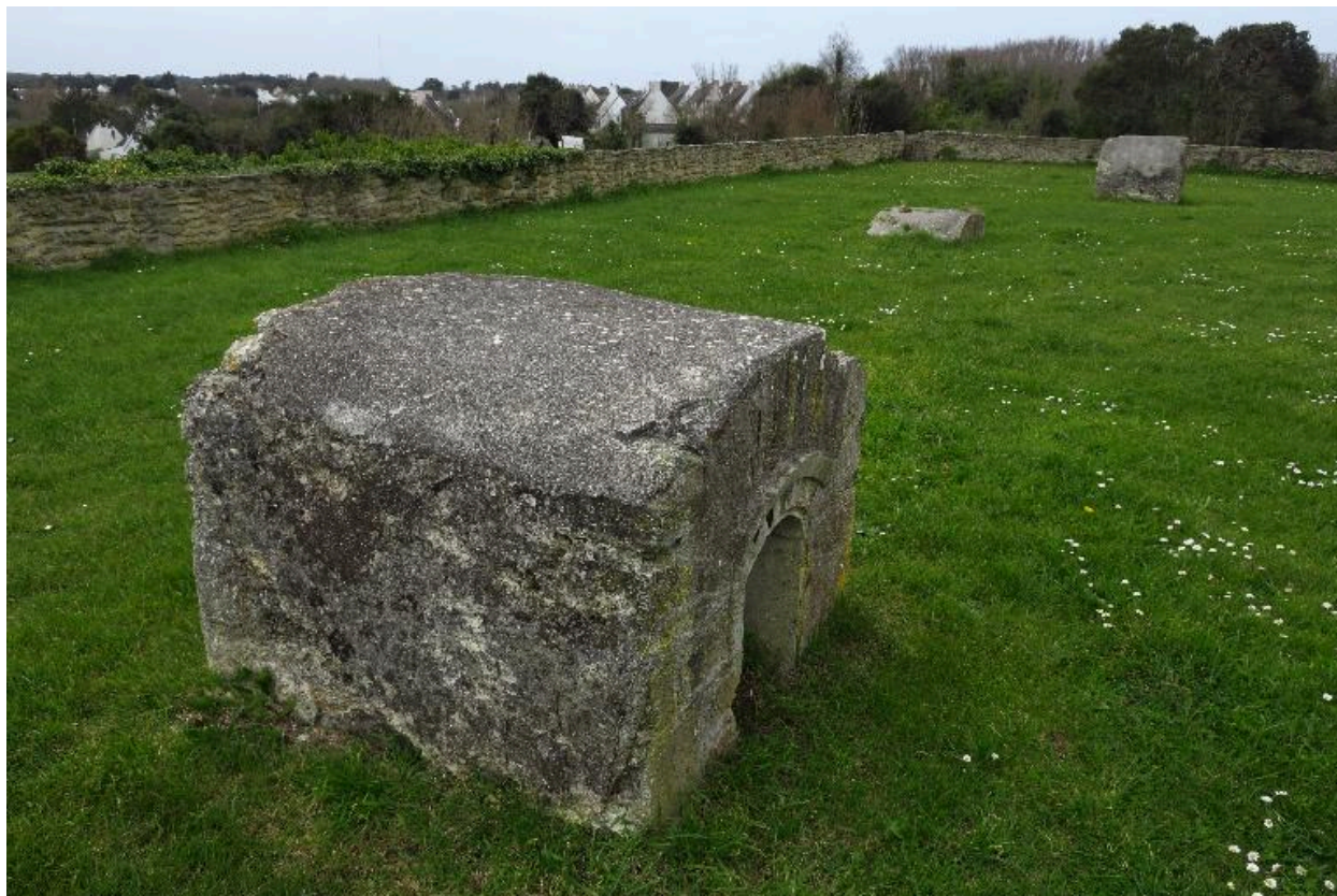
Le Palais, citadelle, éléments du 19e siècle, niches à munitions restées en place après destruction des parapets terrassés du bastion 3.
