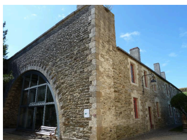
Le Palais, citadelle, éléments du 19e siècle, traverse en maçonnerie sur arc appuyée sur le pignon du pavillon d'officiers. Phot. Patrick Jadé IVR53_20175606729NUCA
