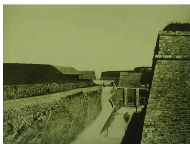
Le Palais, citadelle, vue des fronts nord avant la restauration. IVR53_20175607039NUCA
