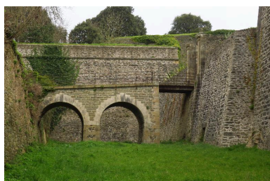
Le Palais, citadelle, éléments du 19e siècle, pont dormant de la porte du bourg. Phot. Lionel Duigou IVR53_20175606707NUCA
