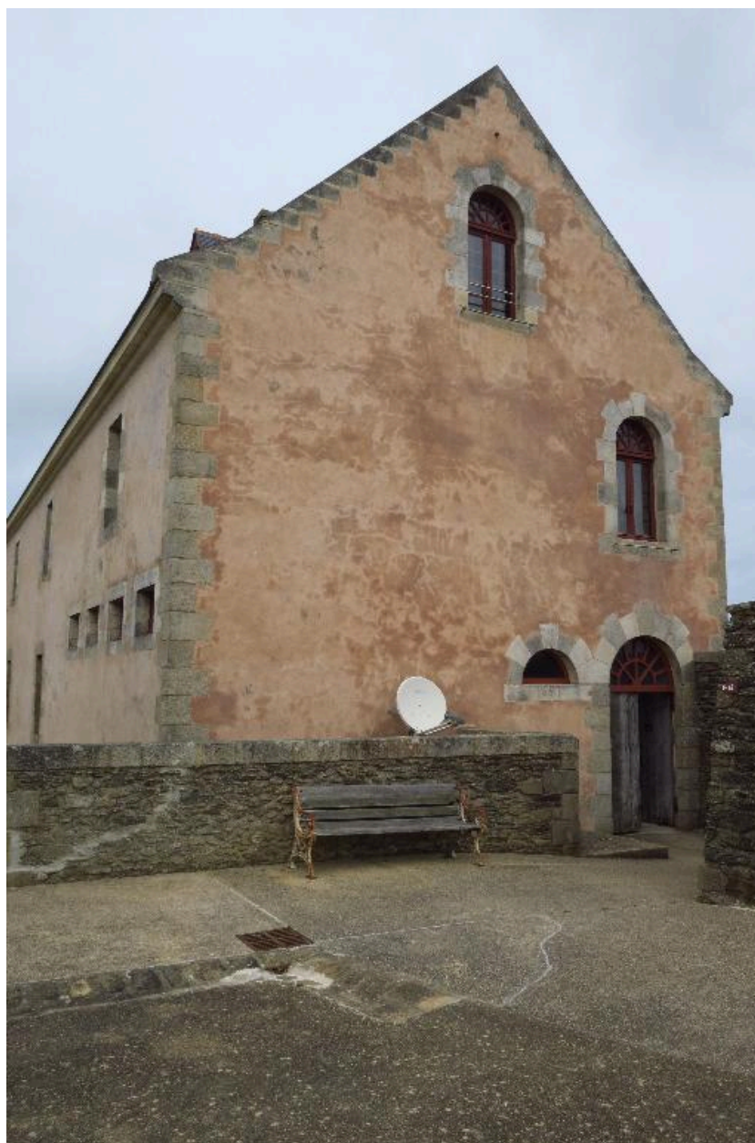
Le Palais, citadelle, éléments du 19e siècle, pignon sud du Grand Quartier.
