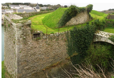
Le Palais, citadelle, éléments du 19e siècle, fronts sud, coupure et créneau de pied. Phot. Lionel Duigou IVR53_20175606701NUCA
