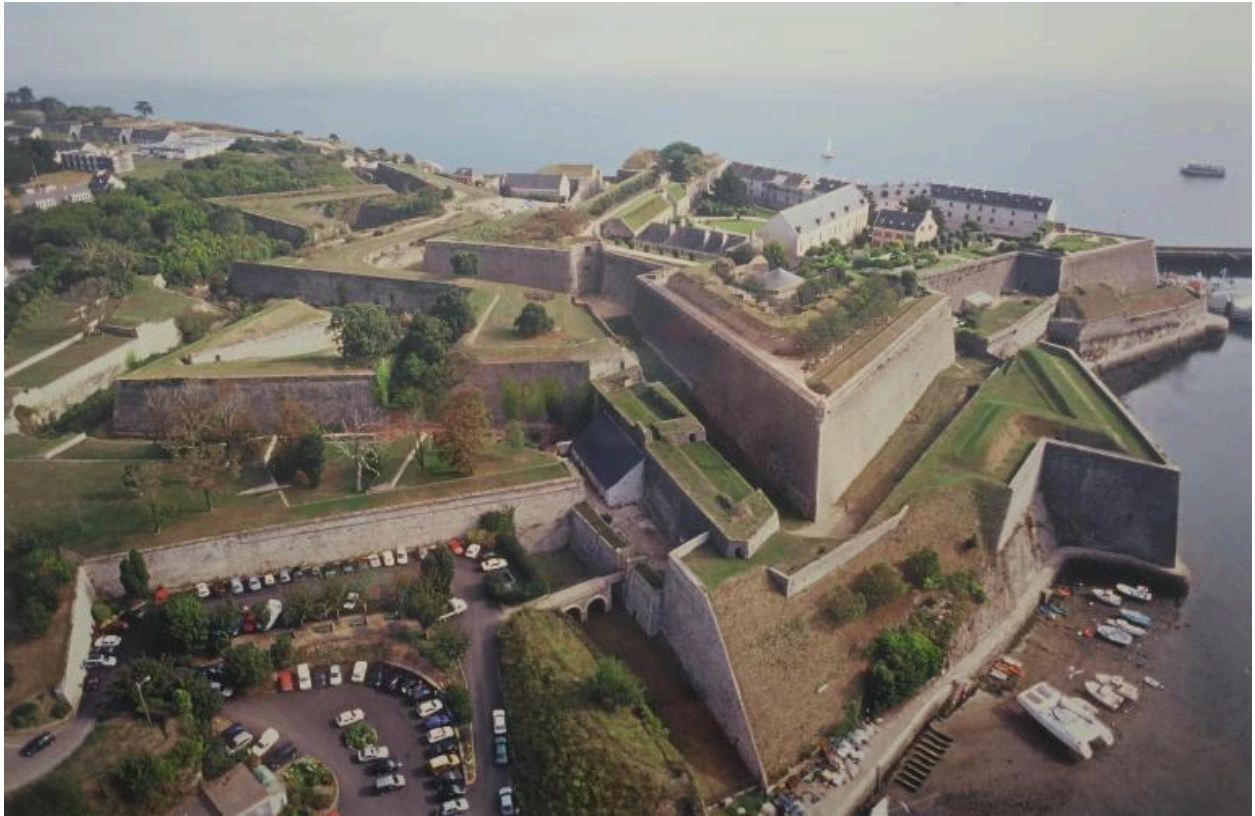
Le Palais, citadelle, vue aérienne des fronts sud-ouest après la restauration.
