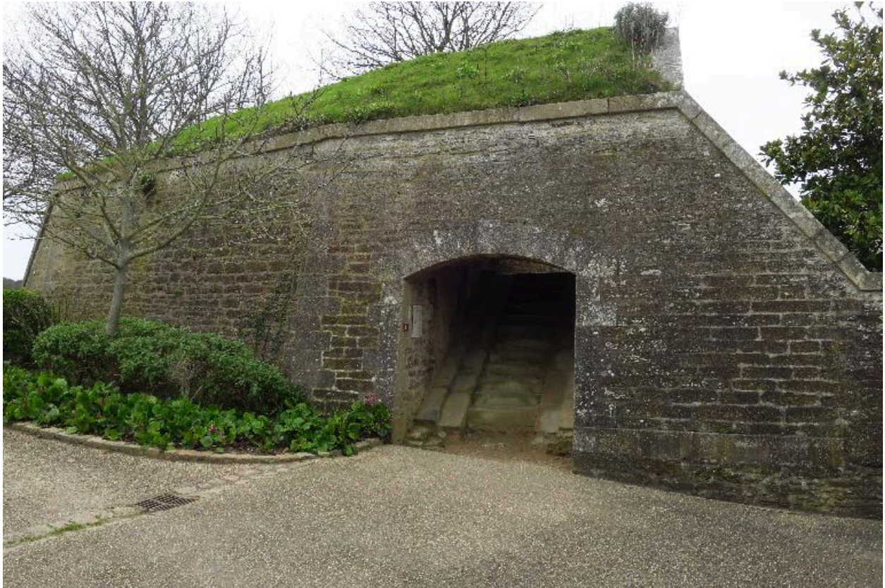
Le Palais, citadelle, éléments du 19e siècle, cavalier du bastion 2.
