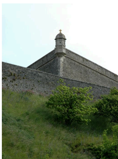
Vue de la citadelle de Belle-île : échauguette du bastion du Dauphin
