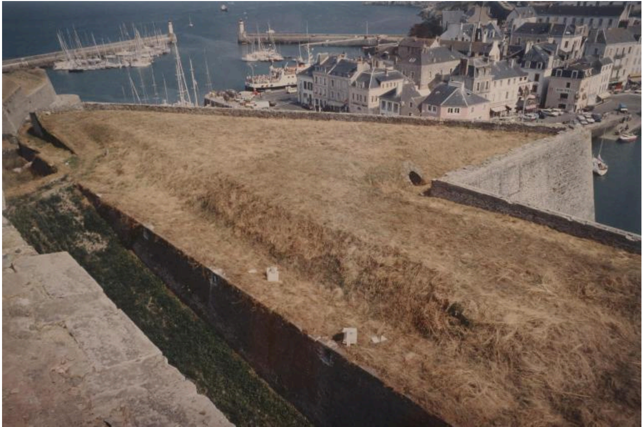
Le Palais, citadelle, vue de la contregarde 7 avant la restauration.
