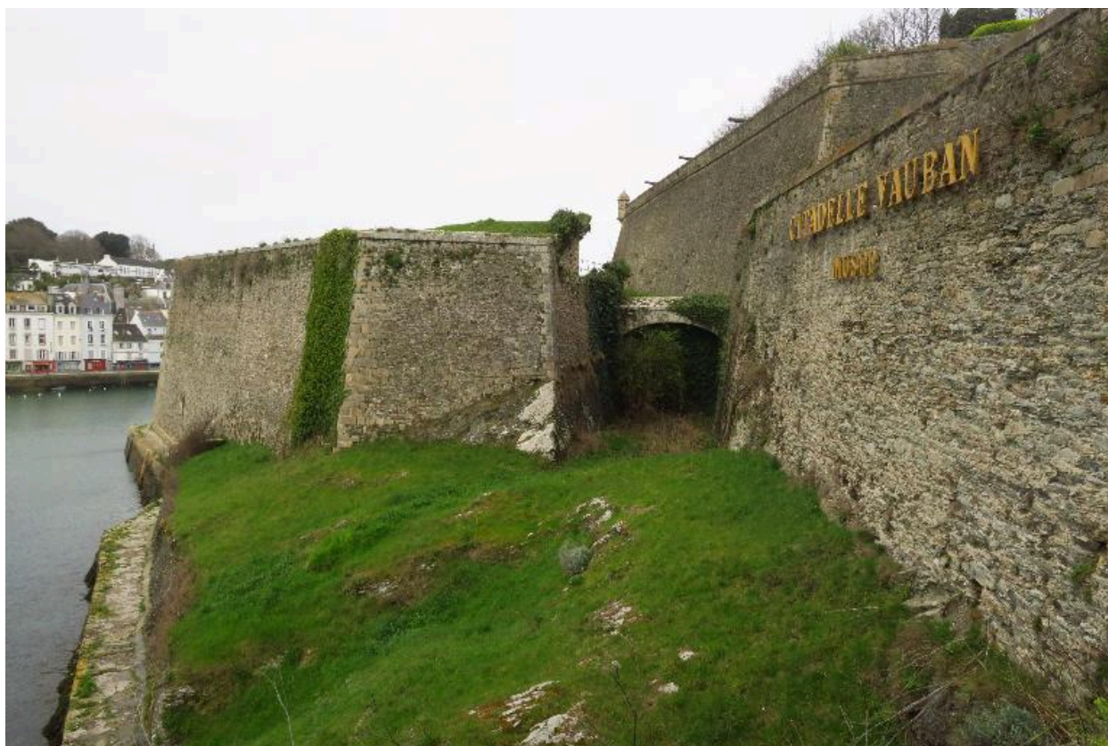
Le Palais, citadelle, éléments du 19e siècle, fronts sud, coupure et créneau de pied.
