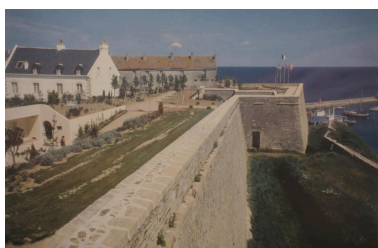
Le Palais, citadelle, vue de la courtine 1-2 et du bastion 1 après la restauration. IVR53_20175607042NUCA
