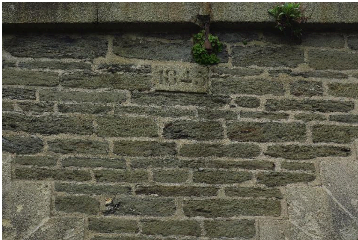
Le Palais, citadelle, éléments du 19e siècle, détail du pont dormant de la porte du bourg.
