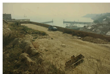
Le Palais, citadelle, vue du bastion 2 pendant la restauration. IVR53_20175607040NUCA
