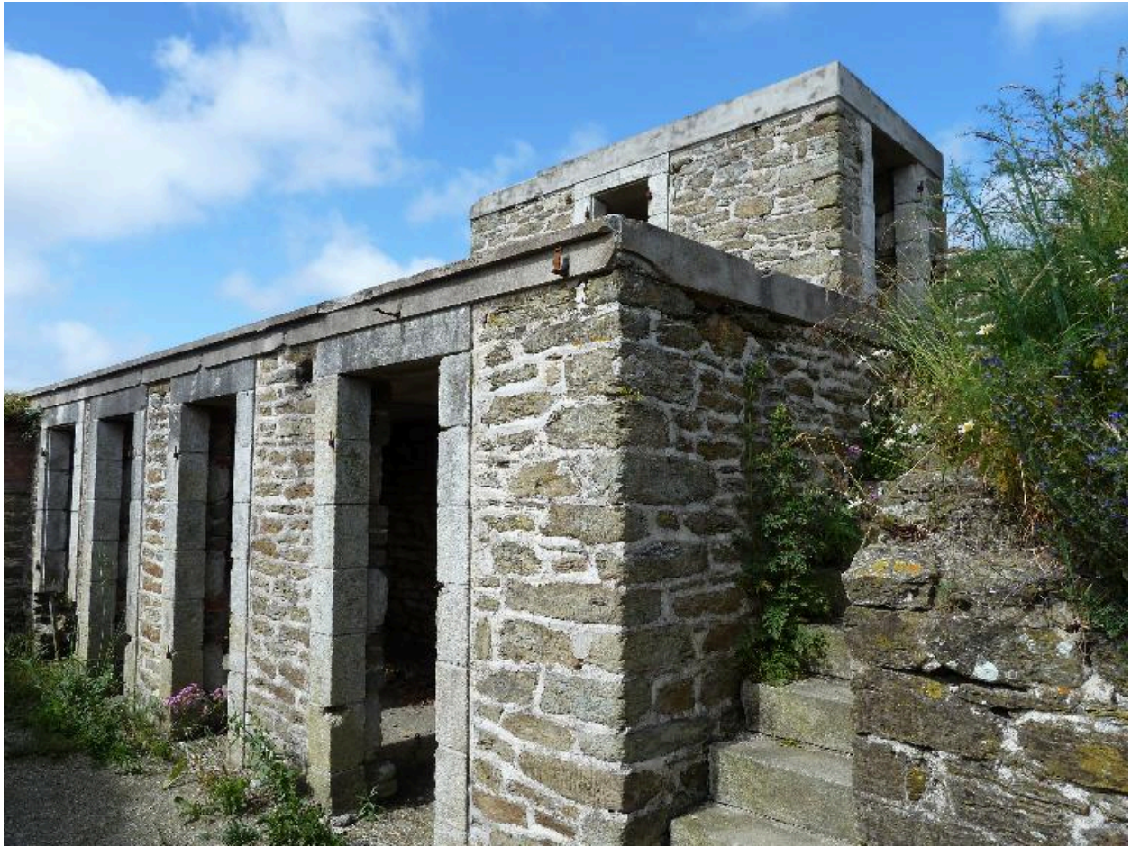
Le Palais, citadelle, éléments du 19e siècle, poste de commandement de batteries de côte sur le bastion 4.
