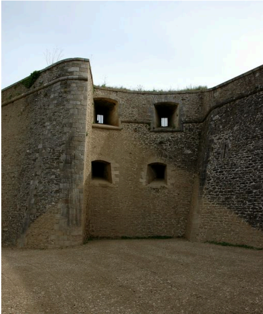
Vue de la citadelle de Belle-île : orillon et flanc percé d'embrasures de flanquement du bastion Saint-Louis
