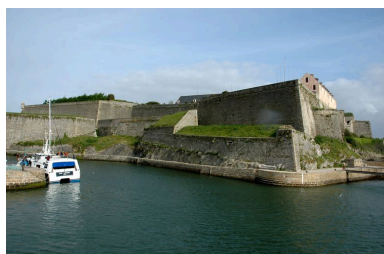
Vue de la citadelle de Belle- île : le bastion du Gouverneur Phot. Guillaume Lécueillier IVR53_20065605318NUCA
