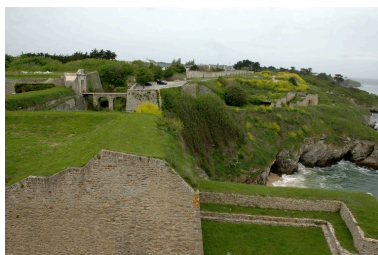
Vue de la citadelle de Belle-île : l'Avancée et le redan de la Mer Phot. Guillaume Lécueillier IVR53_20065605337NUCA
