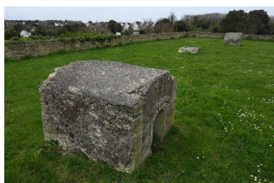
Le Palais, citadelle, éléments du 19e siècle, niches à munitions restées en place après destruction des parapets terrassés du bastion 3. Phot. Lionel Duigou IVR53_20175606711NUCA
