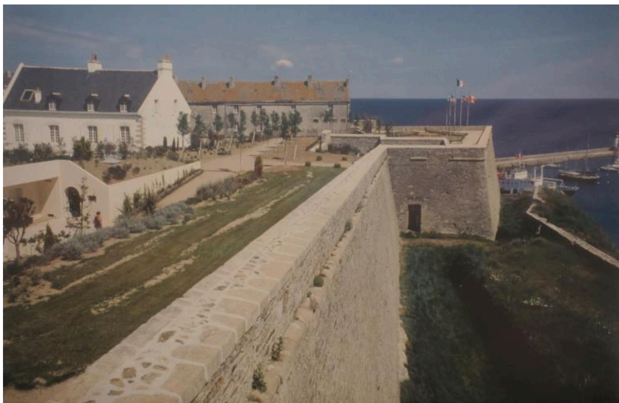
Le Palais, citadelle, vue de la courtine 1-2 et du bastion 1 après la restauration.
