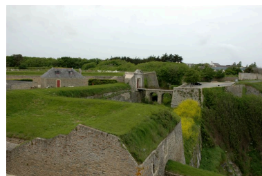
Vue de la citadelle de Belle-île : l'Avancée, son corps de garde et la porte Phot. Guillaume Lécueillier IVR53_20065605338NUCA
