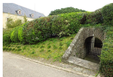
Le Palais, citadelle, éléments du 19e siècle, passage couvert dans les masses terrassées disparues du front 1-2. Phot. Lionel Duigou IVR53_20175606710NUCA
