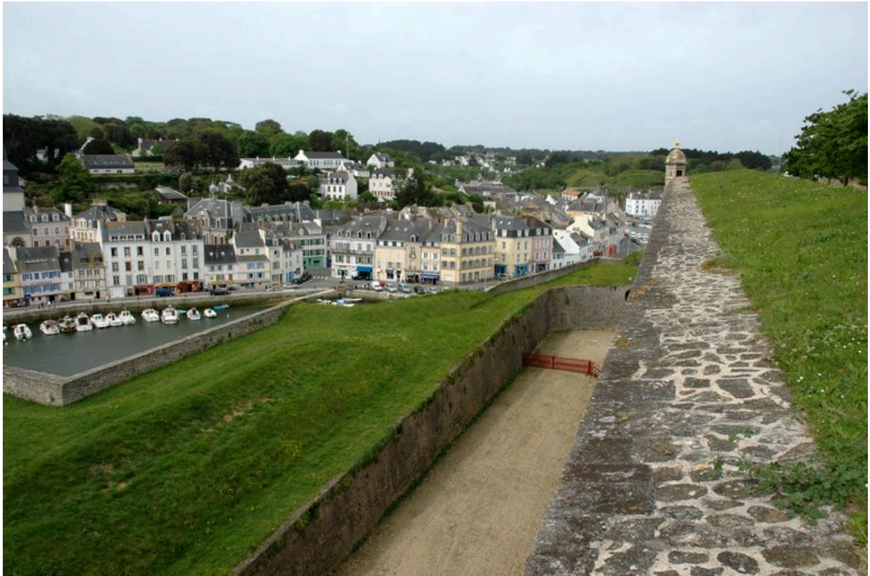
Vue de la citadelle de Belle-île : face du bastion du Dauphin. En arrière-plan : le bourg de Le Palais
