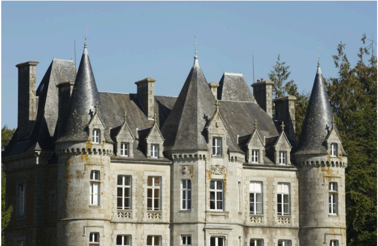
Vue sud-ouest, détail des toitures
