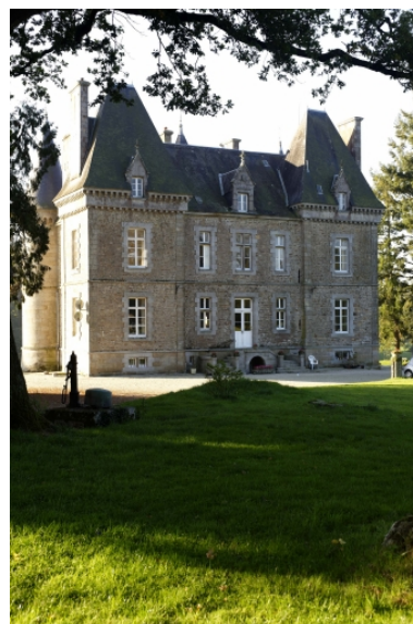
Vue nord-est Phot. Norbert Lambart IVR53_20103506089NUCA
