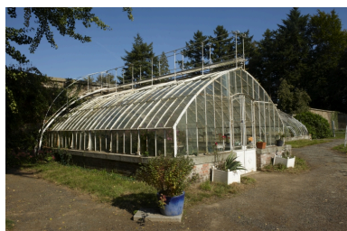
Serre située au nord-est des communs Phot. Norbert Lambart IVR53_20103506041NUCA
