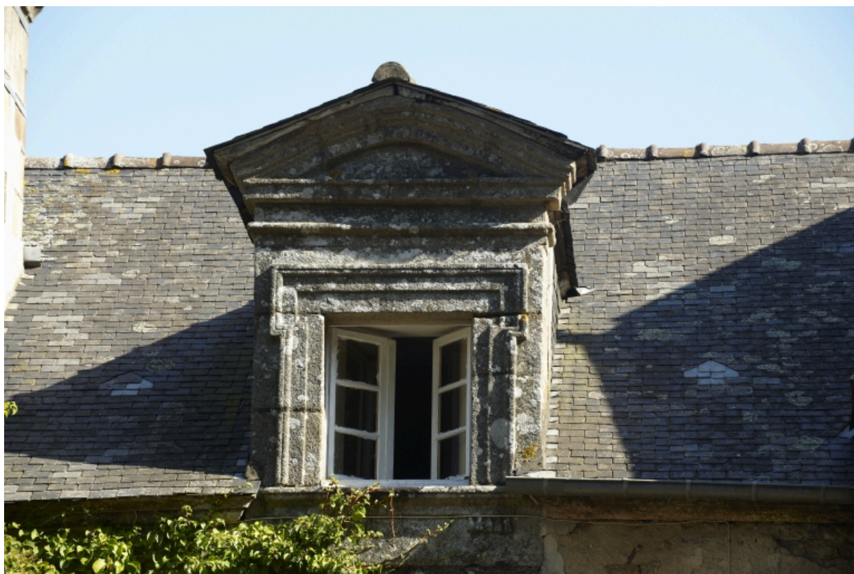
Détail de l'une des lucarnes des communs
