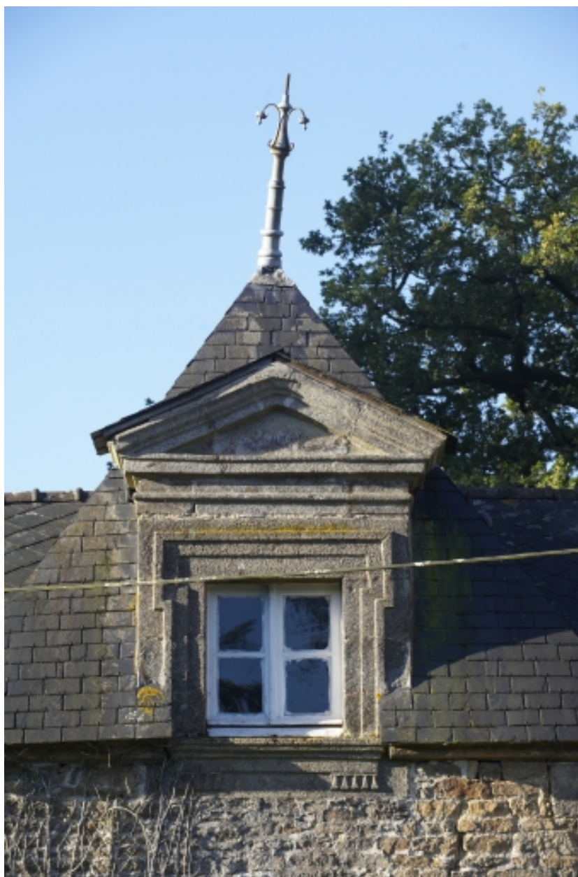
Détail de l'une des lucarnes situées sur les communs
