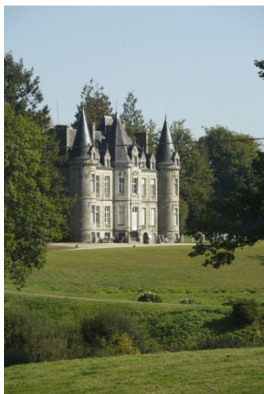
Vue sud-ouest Phot. Norbert Lambart IVR53_20103506034NUCA
