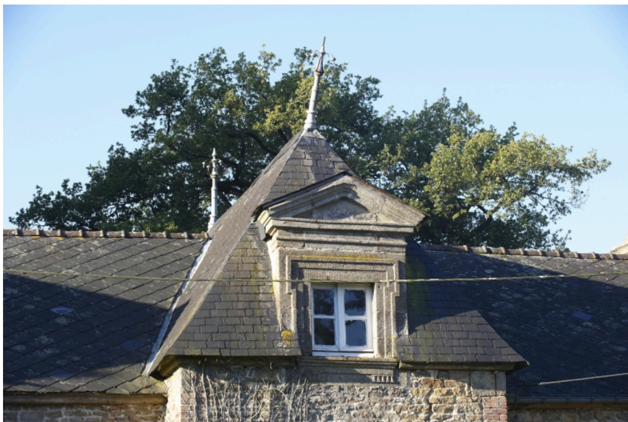
Détail de l'une des lucarnes des communs
