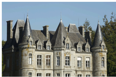
Vue sud-ouest, détail des toitures Phot. Norbert Lambart IVR53_20103506066NUCA
