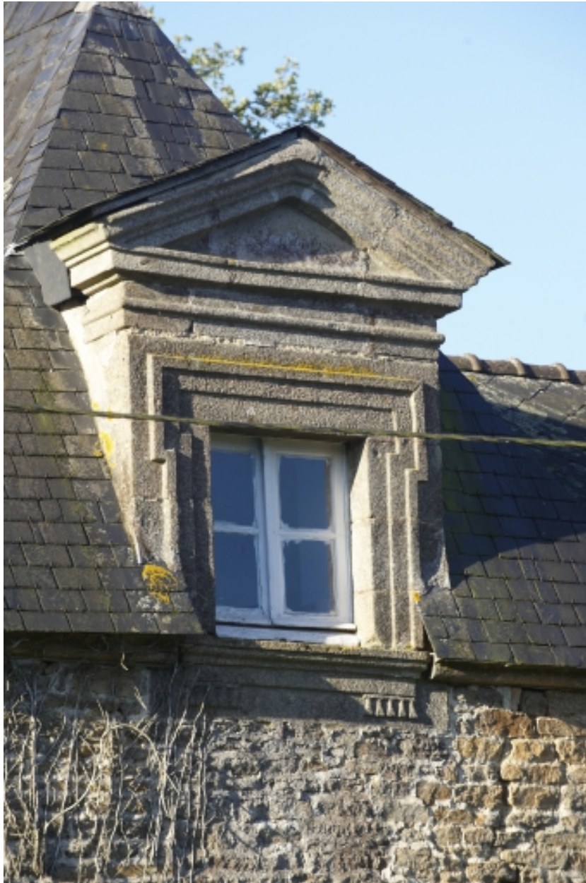
Détail de l'une des lucarnes des communs
