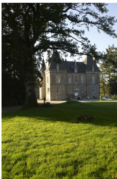
Vue nord-est Phot. Norbert Lambart IVR53_20103506091NUCA
