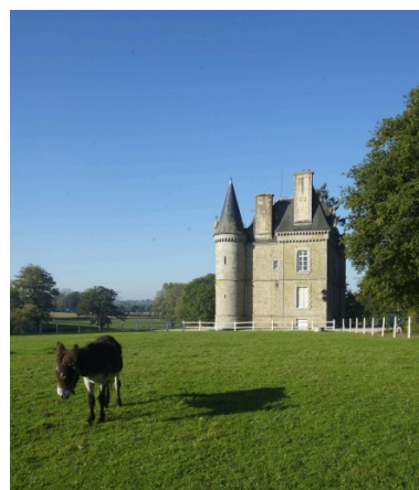
Vue est Phot. Norbert Lambart IVR53_20103506100NUCA
