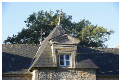
Détail de l'une des lucarnes des communs Phot. Norbert Lambart IVR53_20103506093NUCA
