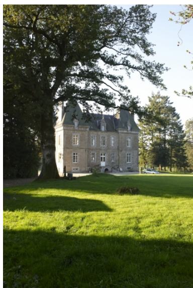
Vue nord-est Phot. Norbert Lambart IVR53_20103506090NUCA
