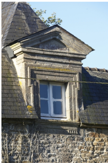
Détail de l'une des lucarnes des communs Phot. Norbert Lambart IVR53_20103506096NUCA
