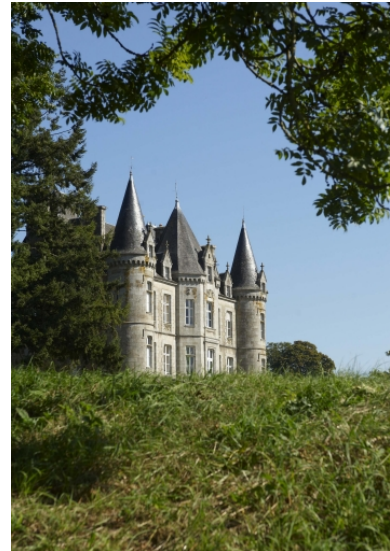
Vue sud-ouest Phot. Norbert Lambart IVR53_20103506062NUCA
