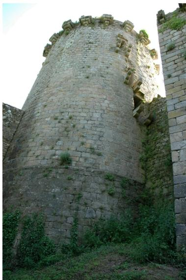
Vue de la tour d'Acigné en contre-plongée. Les consoles des trois latrines en encorbellement de la tour subsistent ; au sommet de la tour se voient des mâchicoulis de type breton
