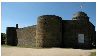
Vue de la barbacane alternant pan de courtine et tours de plan circulaire. Sa partie basse est en pierre de taille de granite ; sa partie haute en moellon
