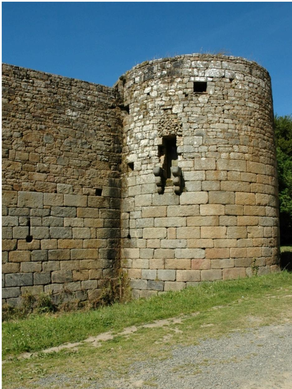
Vue de la barbacane : courtine et tour de plan circulaire. La partie basse est en pierre de taille de granite ; la partie haute en moellon. Sont visibles deux archères-canonniers, des embrasures et l'emplacement de latrines en encorbellement
