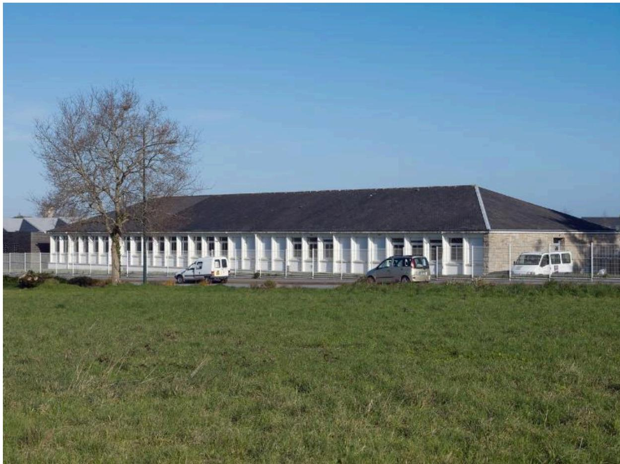
Vue d'ensemble de la façade ouest de l'externat : structure en béton armée et couverture en ardoise (Yves Guillou, architecte, 1962). A l'arrière plan, à gauche, les ateliers.
