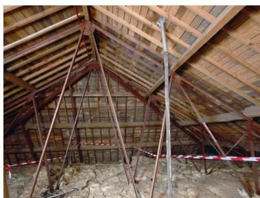
Charpente de l'internat (Yves Guillou, architecte, 1962) : charpente métallique en treillis de cornières. Noter la mixité des matériaux : métal pour les fermes et arbalétriers, bois pour les pannes et chevrons. Un témoignage de la préfabrication.
