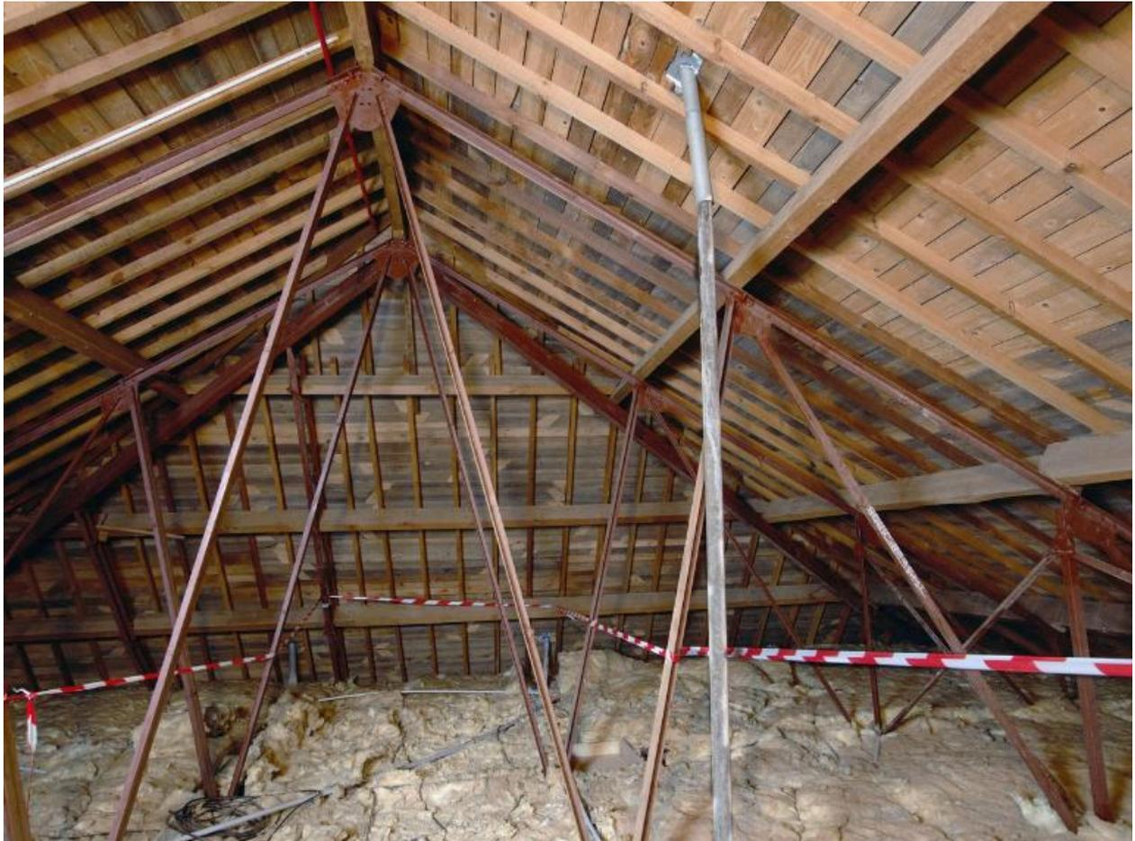
Charpente de l'internat (Yves Guillou, architecte, 1962) : charpente métallique en treillis de cornières. Noter la mixité des matériaux : métal pour les fermes et arbalétriers, bois pour les pannes et chevrons. Un témoignage de la préfabrication.
