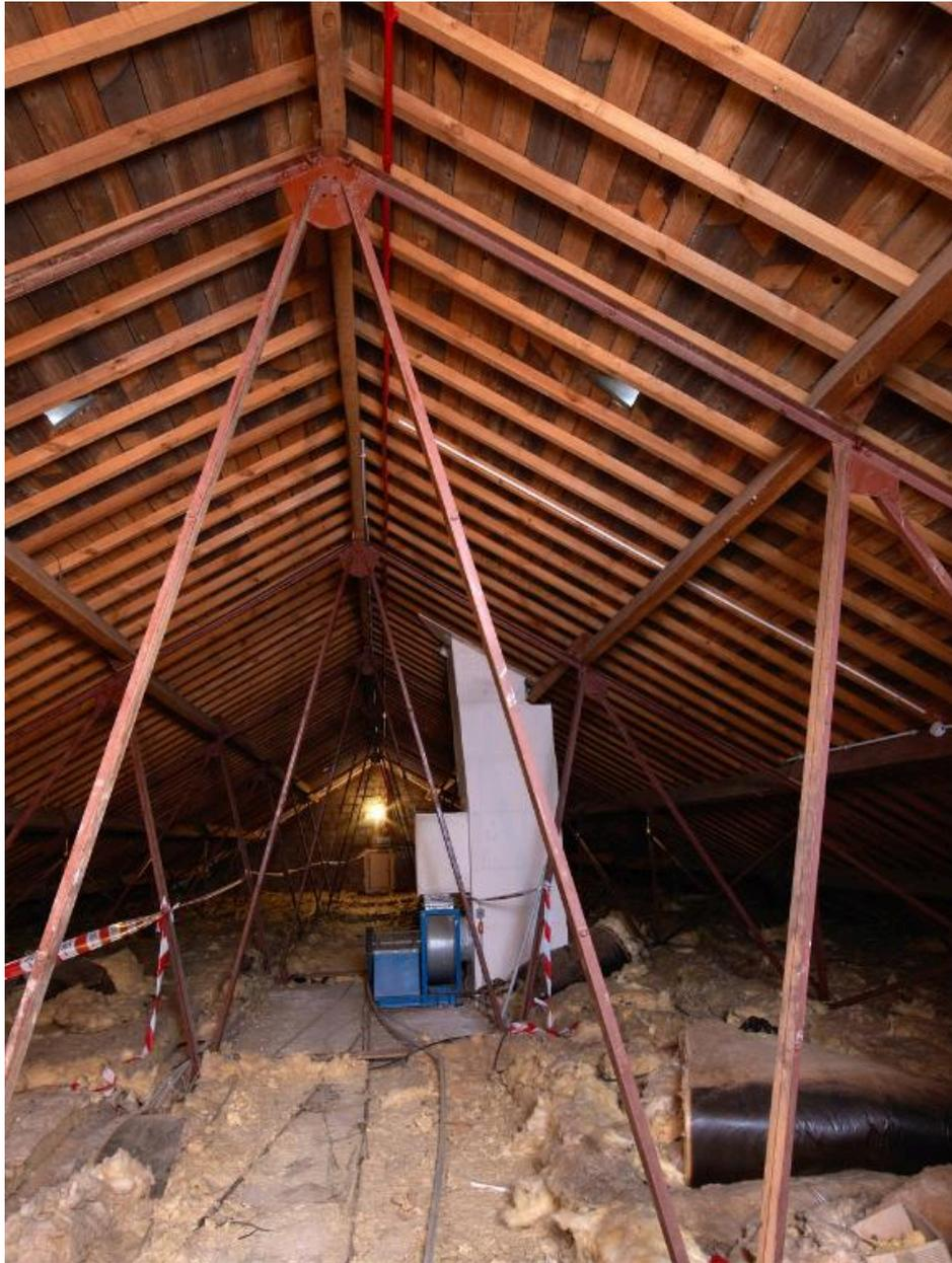
Charpente de l'internat (Yves Guillou, architecte, 1962) : charpente métallique en treillis de cornières. Noter la mixité des matériaux : métal pour les fermes, bois pour les pannes et chevrons. Un témoignage de la préfabrication.
