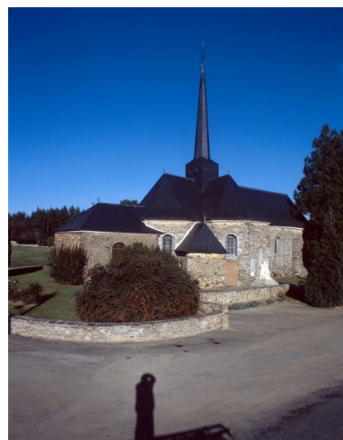
Vue générale sud-ouest Phot. Service régional de l'Inventaire de Bretagne IVR53_19983500001XA
