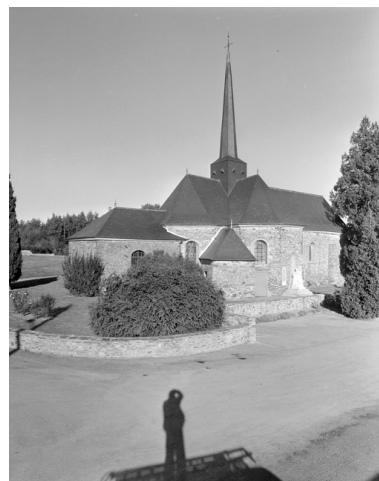
Vue générale sud-ouest Phot. Service régional de l'Inventaire de Bretagne IVR53_199835000013X
