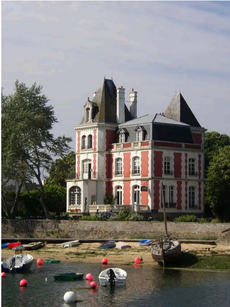
Vue générale de la Villa Margaret
