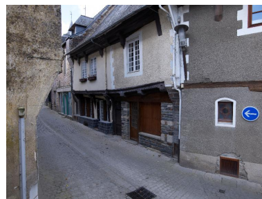
Maison : élévation principale vue du nord-est (état en 2012) Phot. Bernard Bègne IVR53_20125601457NUCA
