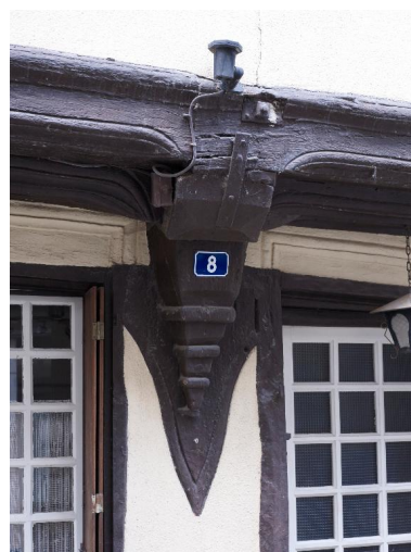
Maison, élévation principale : un aisselier mouluré (état en 2012) Phot. Bernard Bègne IVR53_20125601461NUCA
