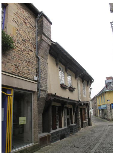
Maison : élévation principale vue du sud-est (état en 2012) Phot. Marie-Dominique Menant IVR53_20125608185NUCA
