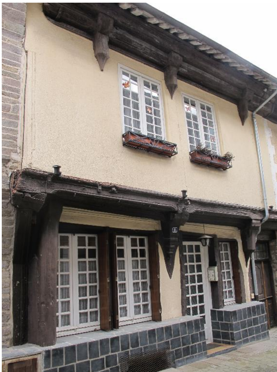
Maison : élévation principale vue du sud-est (état en 2012)
