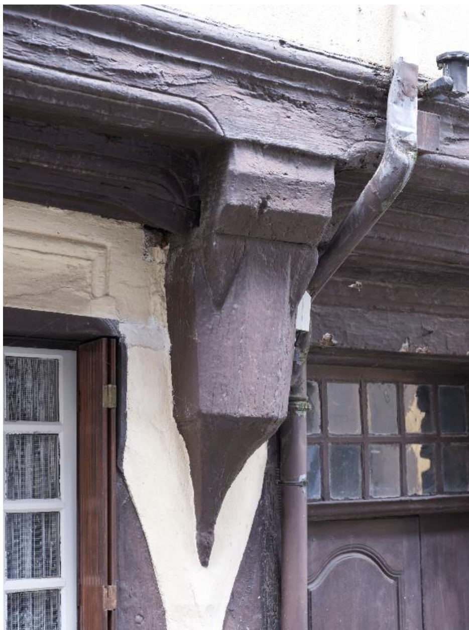
Maison, élévation principale : un aisselier mouluré (état en 2012)
