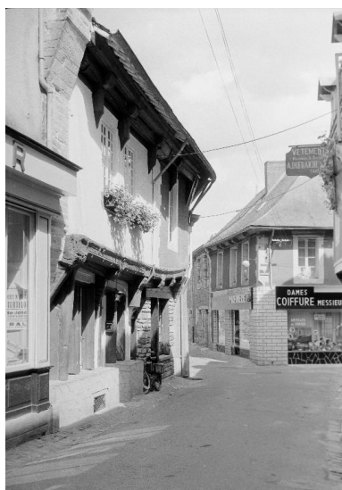
Maison : élévation principale vue du sud-est (état en 1969) Phot. Jean-Pierre Ducouret IVR53_20115600948Z
