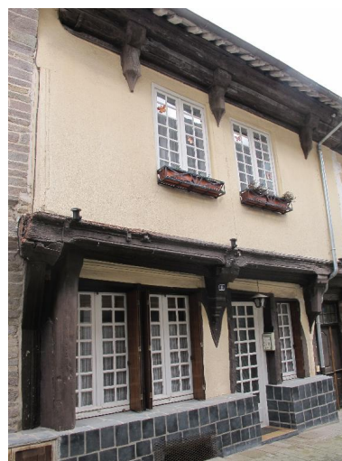
Maison : élévation principale vue du sud-est (état en 2012) Phot. Marie-Dominique Menant IVR53_20125608179NUCA
