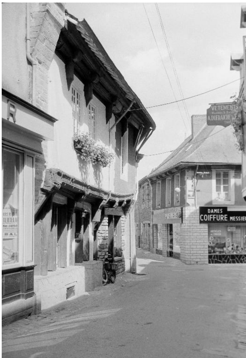
Maison : élévation principale vue du sud-est (état en 1969)
