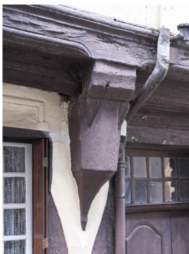
Maison, élévation principale : un aisselier mouluré (état en 2012) Phot. Bernard Bègne IVR53_20125601460NUCA
