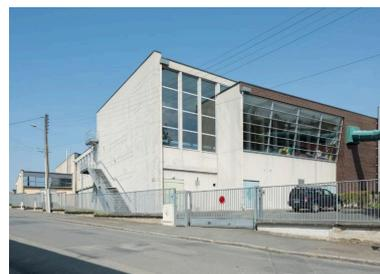
Ossature en béton armé et piliers scandant la façade vitrée
