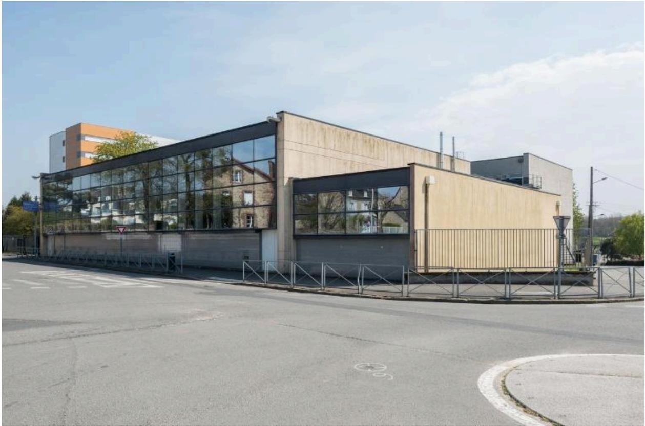
Ossature en béton armé, piliers scandant la façade vitrée
