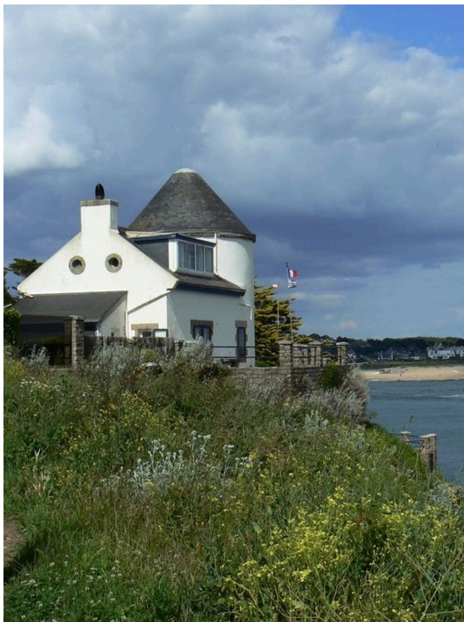
Vue générale du mât pilote
