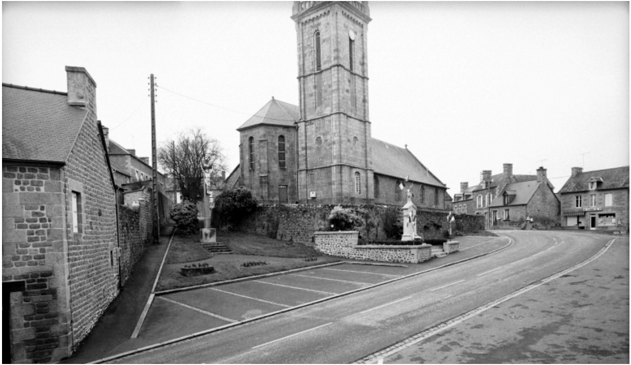
Elévation Nord-Est : vue générale
