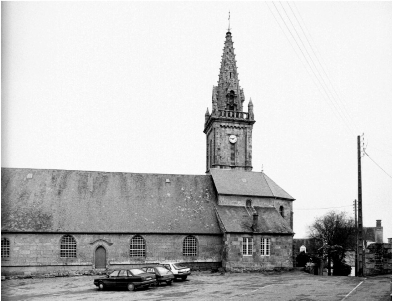
Elévation Sud, partie Est : vue générale
