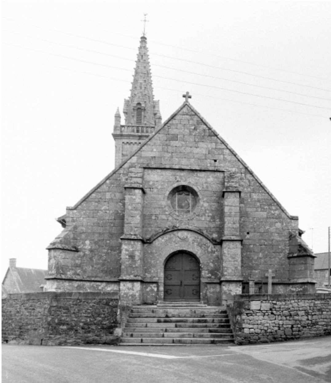
Elévation Ouest : vue générale
