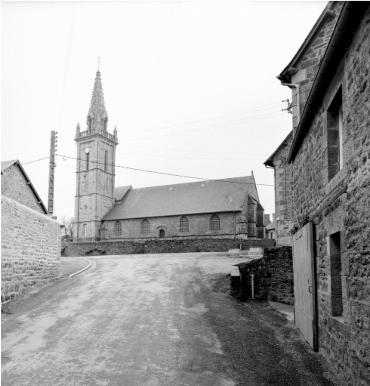
Elévation Nord : vue générale
