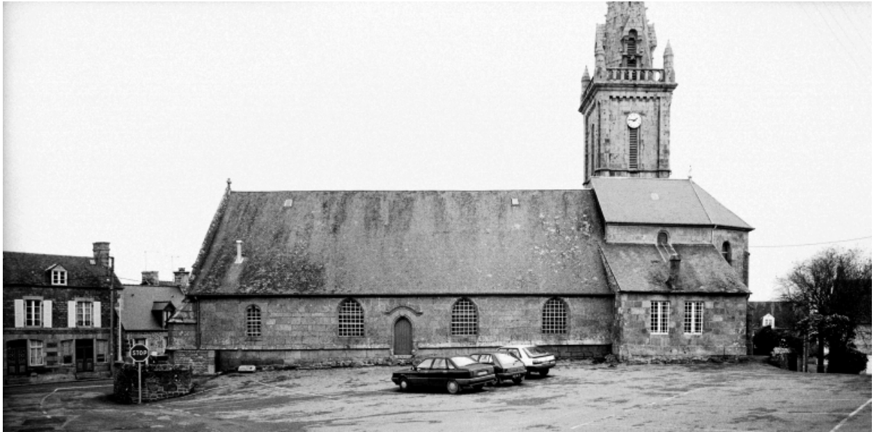
Elévation Sud : vue générale
