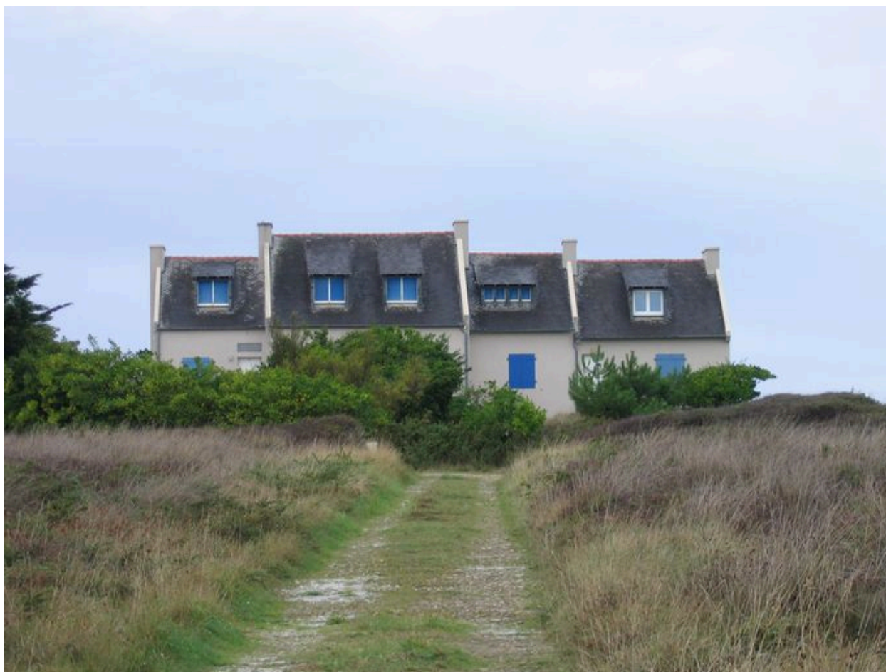
Elévation côté terre de la villa Dirag-ar-Mor
