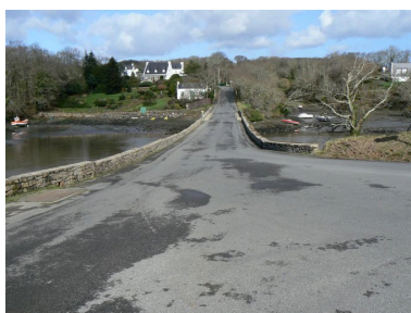
Route passant sur la digue Phot. Julien Amghar IVR53_20082908587NUCA
