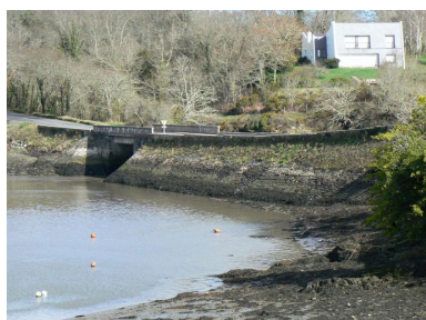
Digue-route de Pont Du Phot. Julien Amghar IVR53_20082908586NUCA
