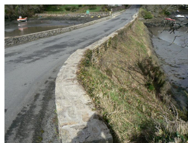
Perré incliné de la digue-route de Pont Du Phot. Julien Amghar IVR53_20082908588NUCA
