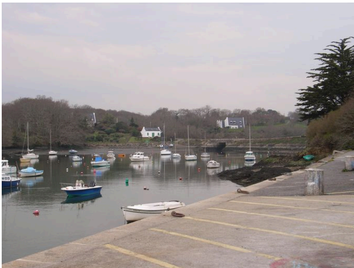
Vue générale de la digue-route de Pont Du
