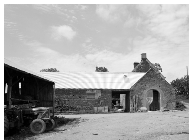
Vue générale des communs Phot. François Dagorn IVR53_19745600213X
