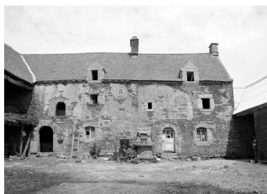
Vue générale de la façade antérieure Phot. François Dagorn IVR53_19745600215X
