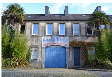
Entrée principale des bureaux, N°20 au plan Phot. Andrée Le Gall-Sanquer IVR53_20152907015NUCA
