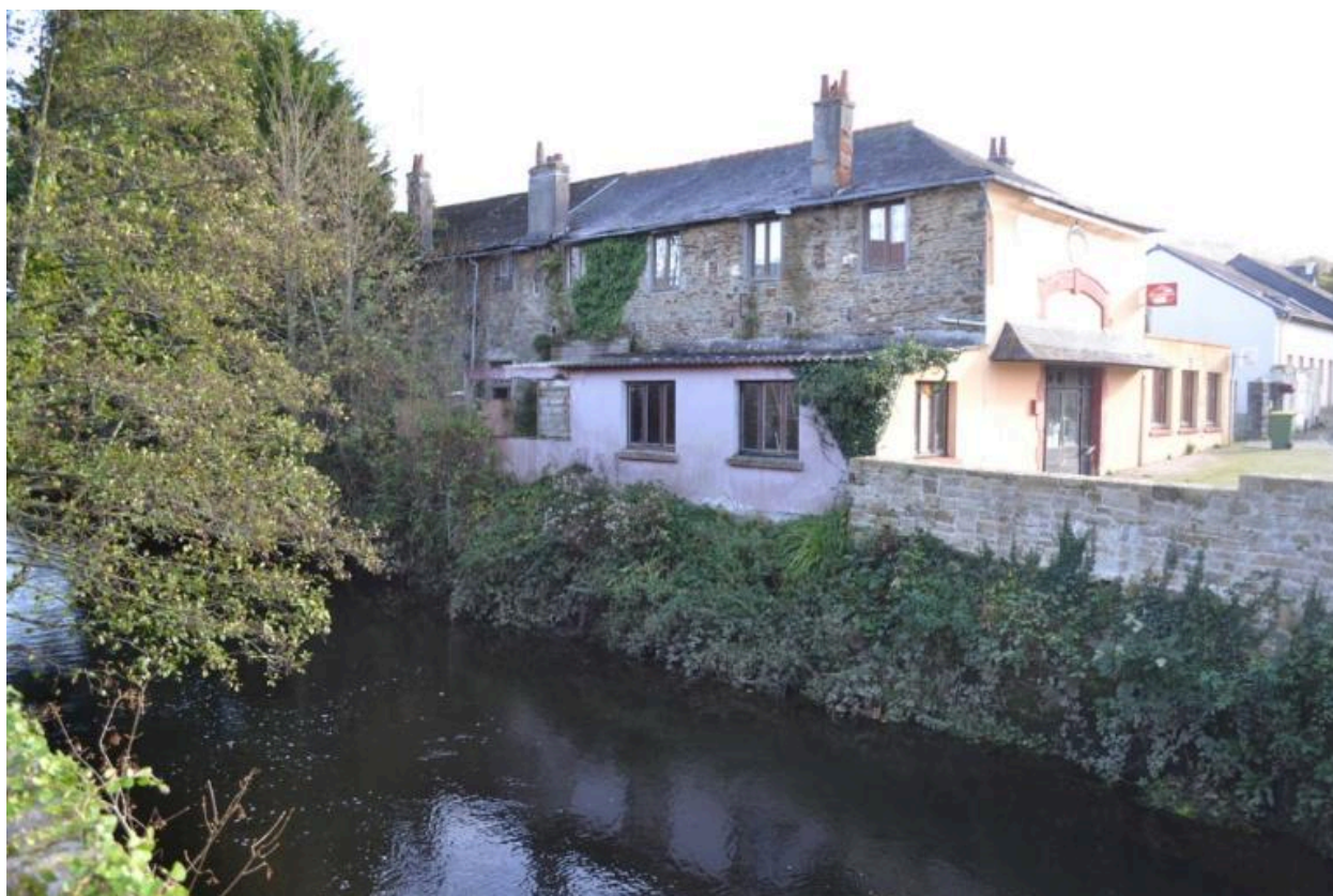
Peignerie. Vue générale nord de la N°33 au plan
