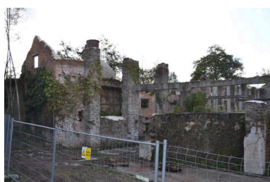
Ruines du "séchoir à l'air libre". Vue générale nord-est, N°2A au plan Phot. Andrée Le Gall-Sanquer
