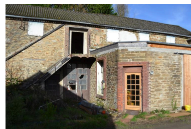
Bâtiment appelé "scotcher", N°34 au plan Phot. Andrée Le Gall-Sanquer IVR53_20152907013NUCA
