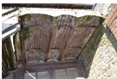
Peignerie. Revers du palier de l'escalier extérieur : entrevous en berceau en brique Phot. Andrée Le Gall-Sanquer IVR53_20152907014NUCA
