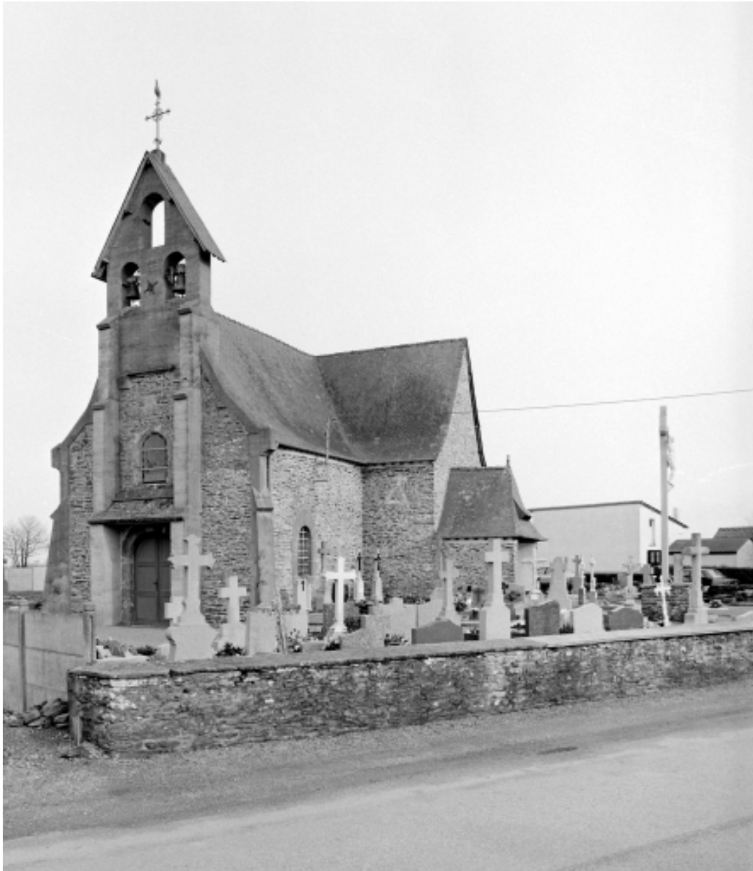
Elévation Sud-Ouest : vue générale
