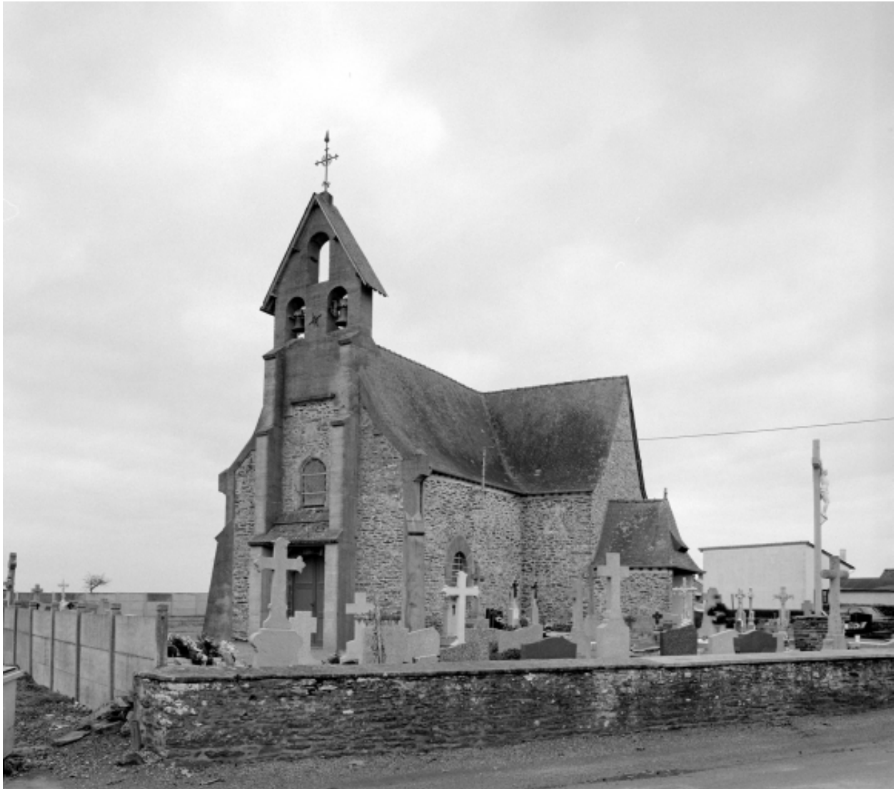
Elévation Sud-Ouest : vue générale
