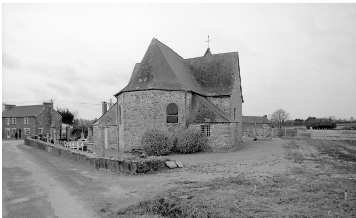
Elévation Est : vue générale
