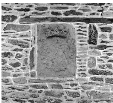
Elévation Est, chevet, blason : vue générale Phot. Bernard Bègne, Phot. M. Loyon IVR53_19923500989X
