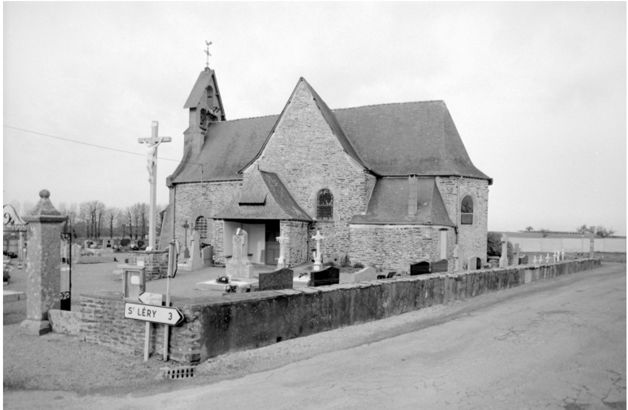
Elévation Sud : vue générale
