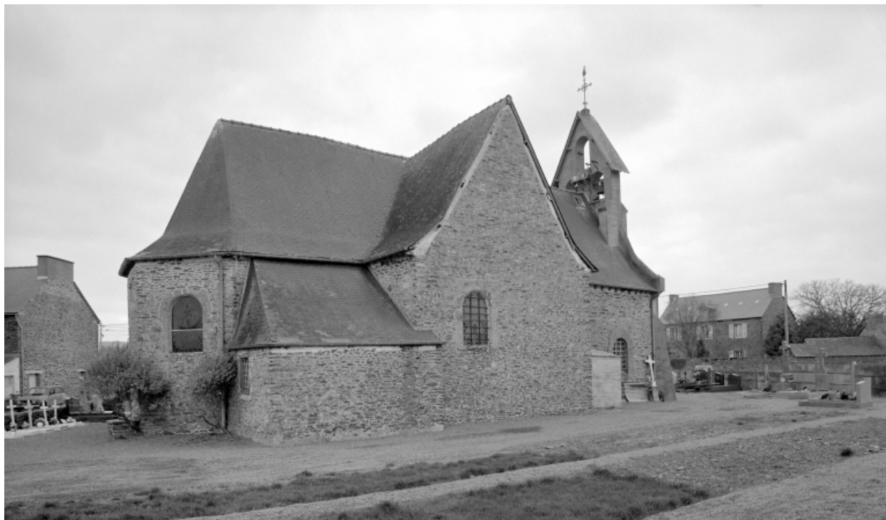
Elévation Nord : vue générale
