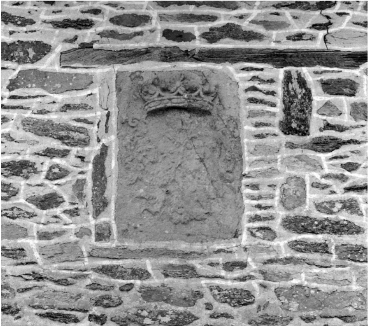
Elévation Est, chevet, blason : vue générale
