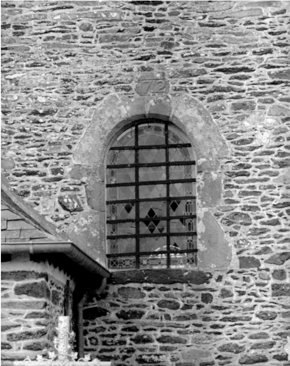
Elévation Sud, fenêtre datée 1712 : vue générale
