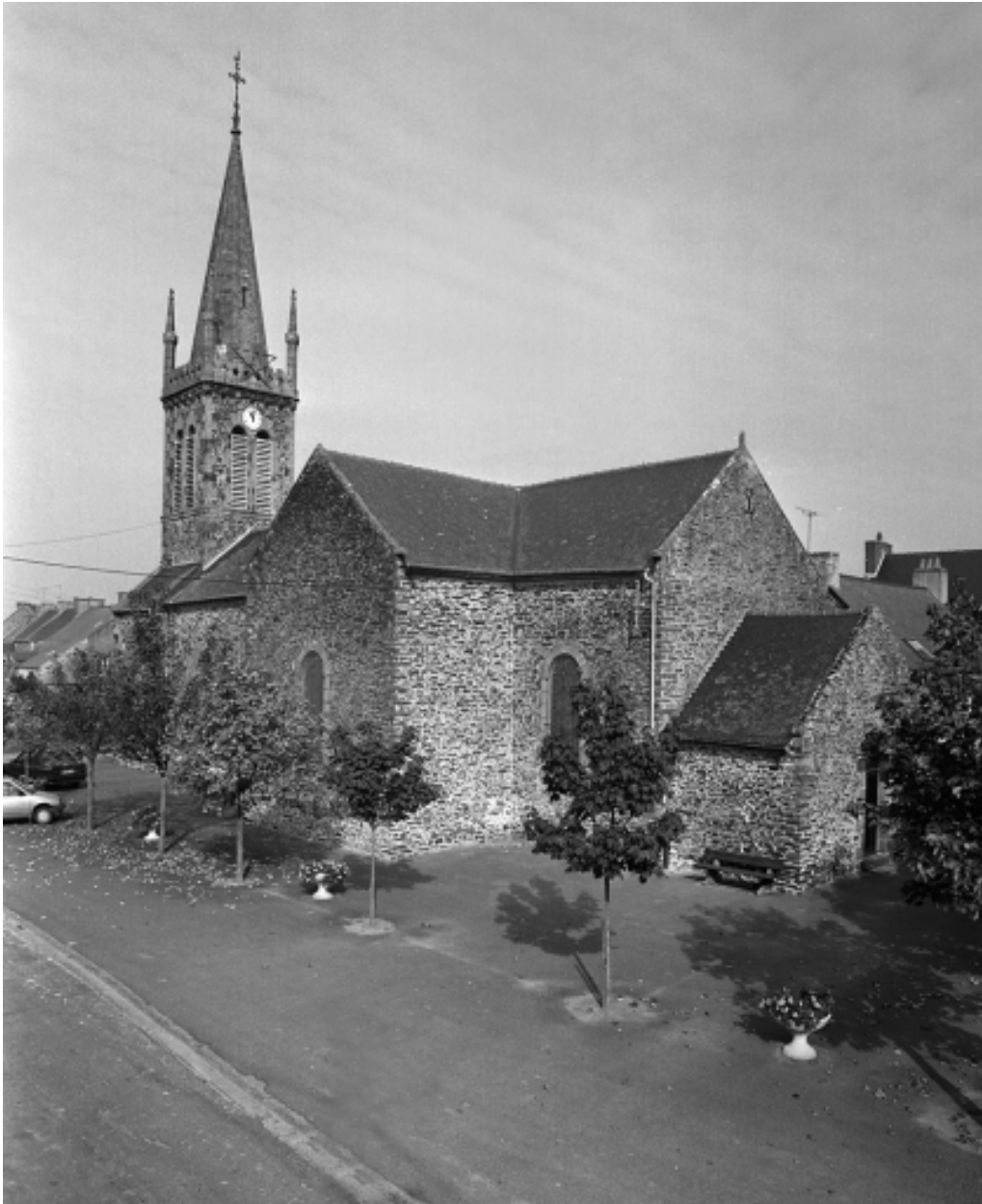
Vue générale sud-est
