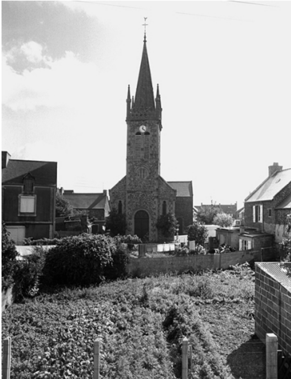
Elévation ouest : vue générale
