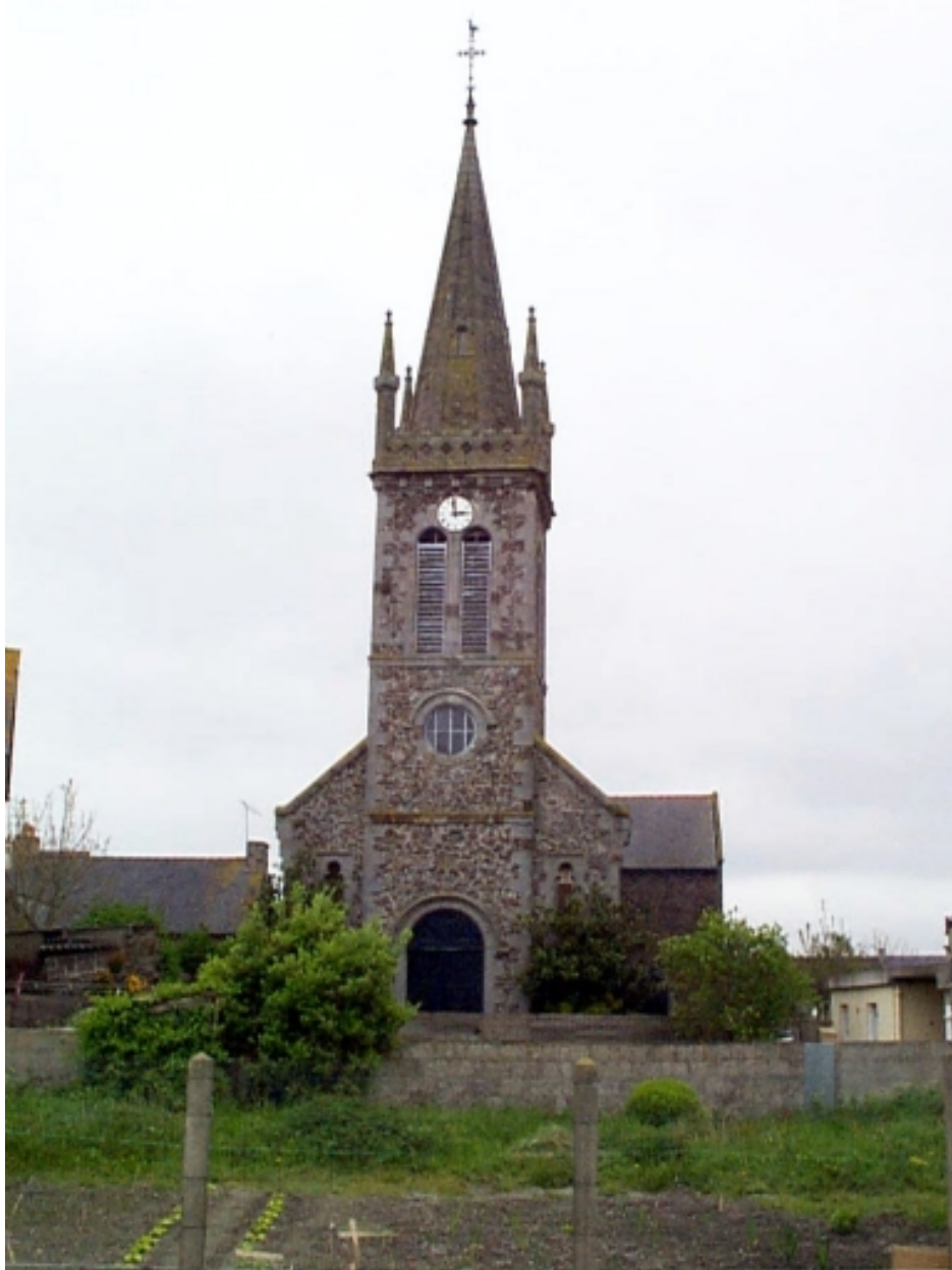
Elévation ouest : vue générale
