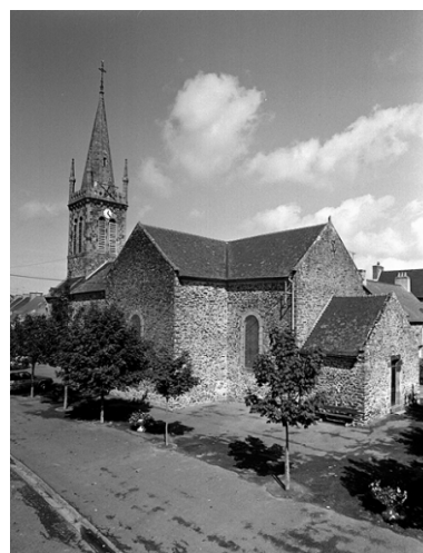
Vue générale sud-est Phot. Guy Artur, Phot. Norbert Lambart IVR53_19943501801X
