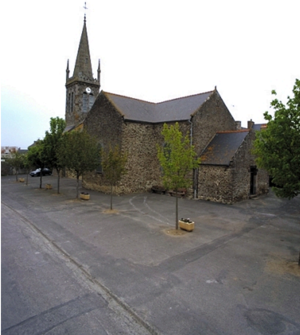
Vue générale sud-est
