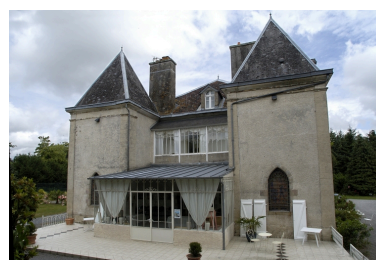
Elévation ouest Phot. Bernard Bègne IVR53_20042900118NUCA
