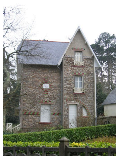
Vue latérale de la villa La Roseraie Phot. Françoise Péron IVR53_20062908630NUCA
