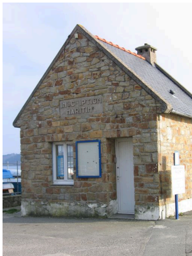
Vue générale de l'ancien bureau du garde maritime Phot. Françoise Péron IVR53_20062908553NUCA
