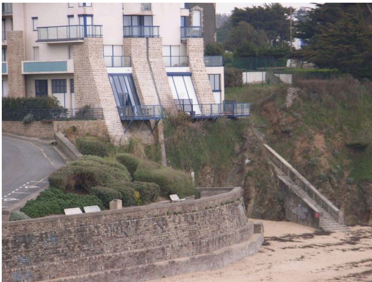
Piliers en pierres apparentes s'appuyant sur la falaise
