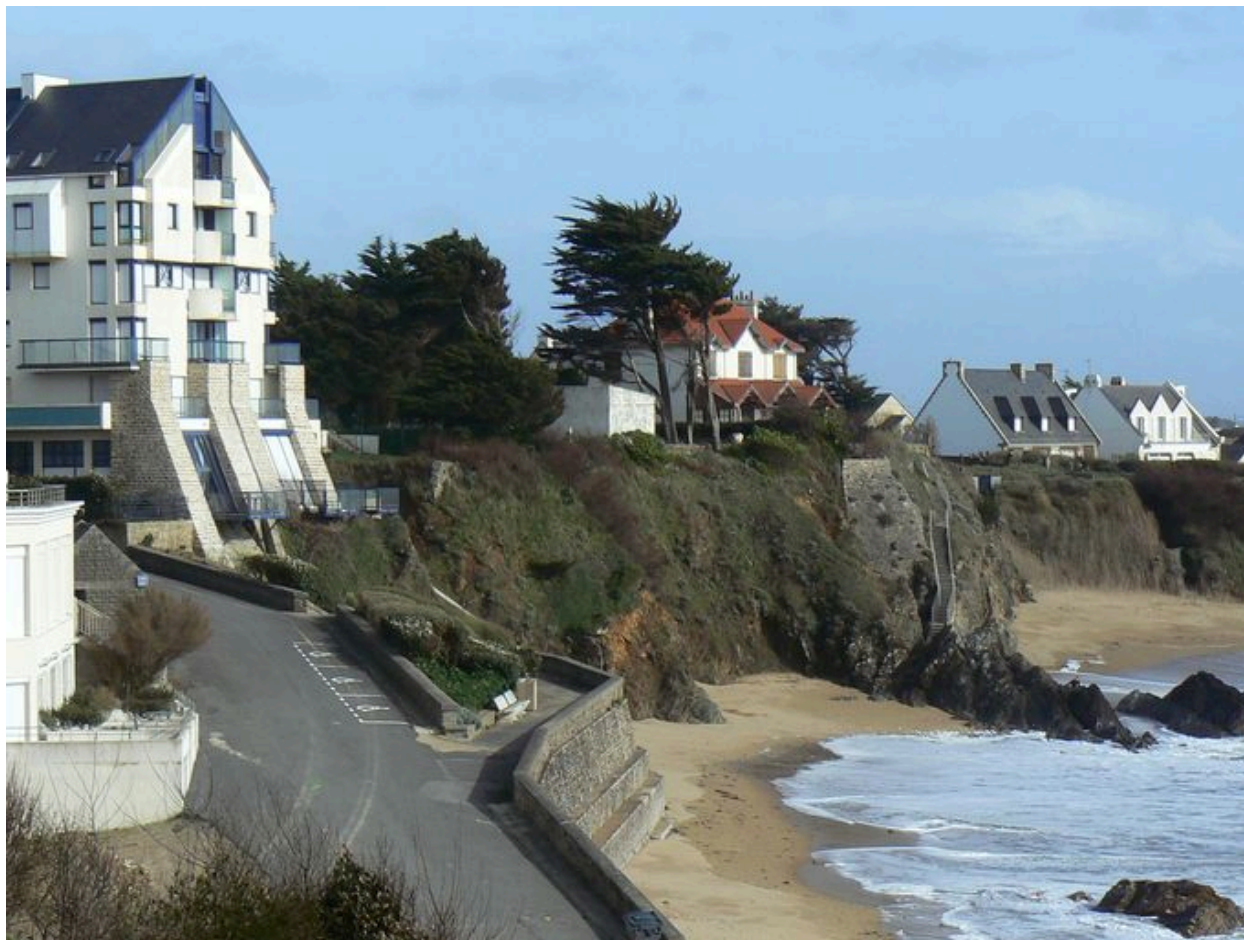
Vue d'ensemble de la façade sud de l'ancien Hôtel des Dunes et de la plage des Grands-Sables
