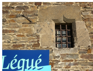
Vue de détail d'une petite ouverture en anse de panier, fermée par une grille en fer forgé Phot. Guy Prigent IVR53_20082213452NUCA
