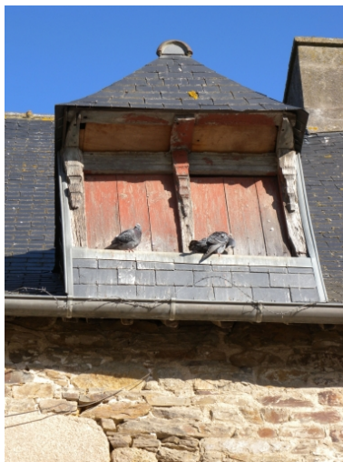
Vue de détail d'une lucarne en bois mouluré Phot. Guy Prigent IVR53_20082213457NUCA
