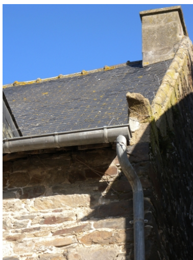
Vue de détail d'un rempart à crossette au niveau de la toiture Phot. Guy Prigent IVR53_20082213451NUCA
