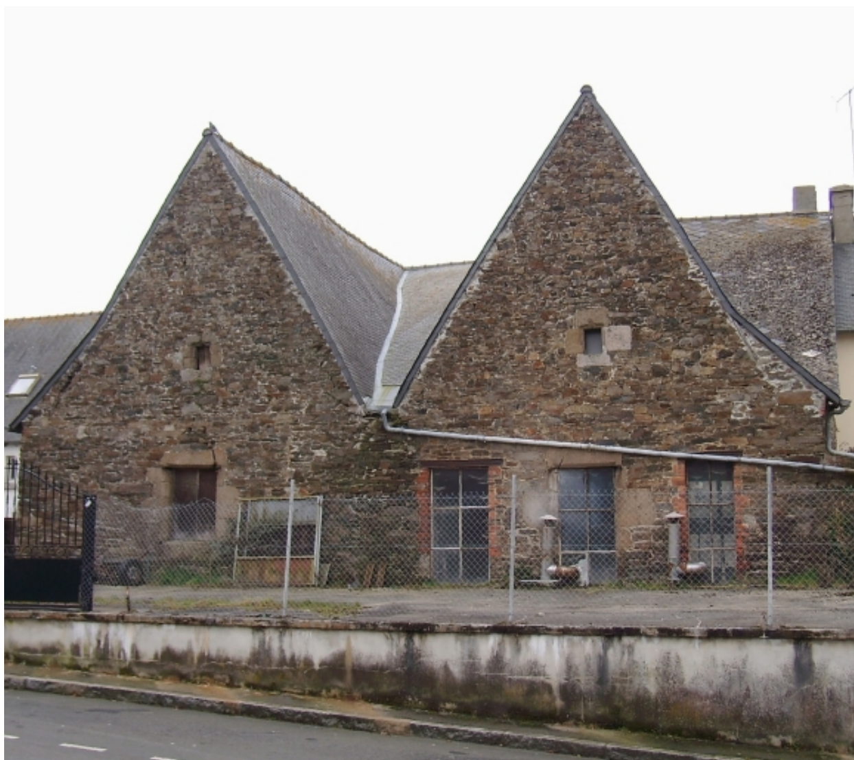
Vue générale (façade postérieure)
