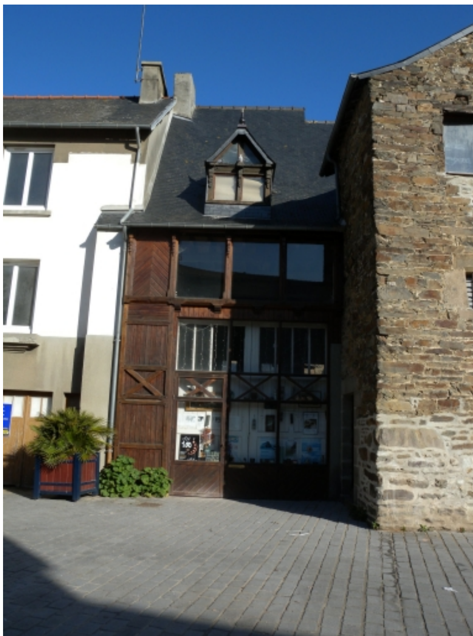
Vue de la façade mitoyenne en pans de bois
