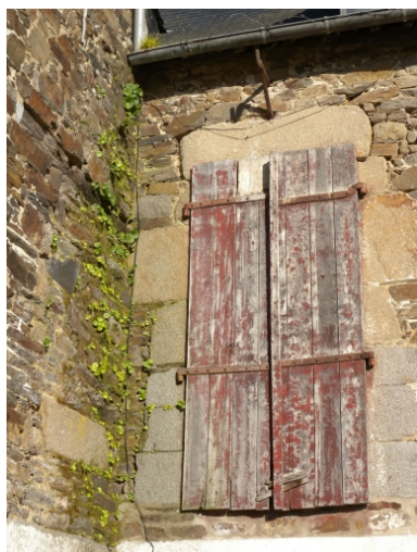
Vue de détail d'une fenêtre avec l'encadrement en pierre de taille (granite) Phot. Guy Prigent IVR53_20082213450NUCA
