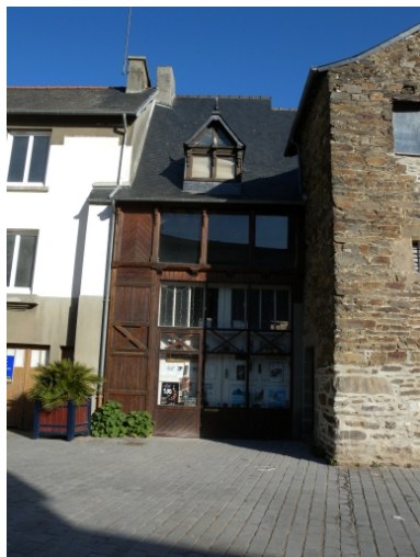
Vue de la façade mitoyenne en pans de bois Phot. Guy Prigent IVR53_20082213453NUCA
