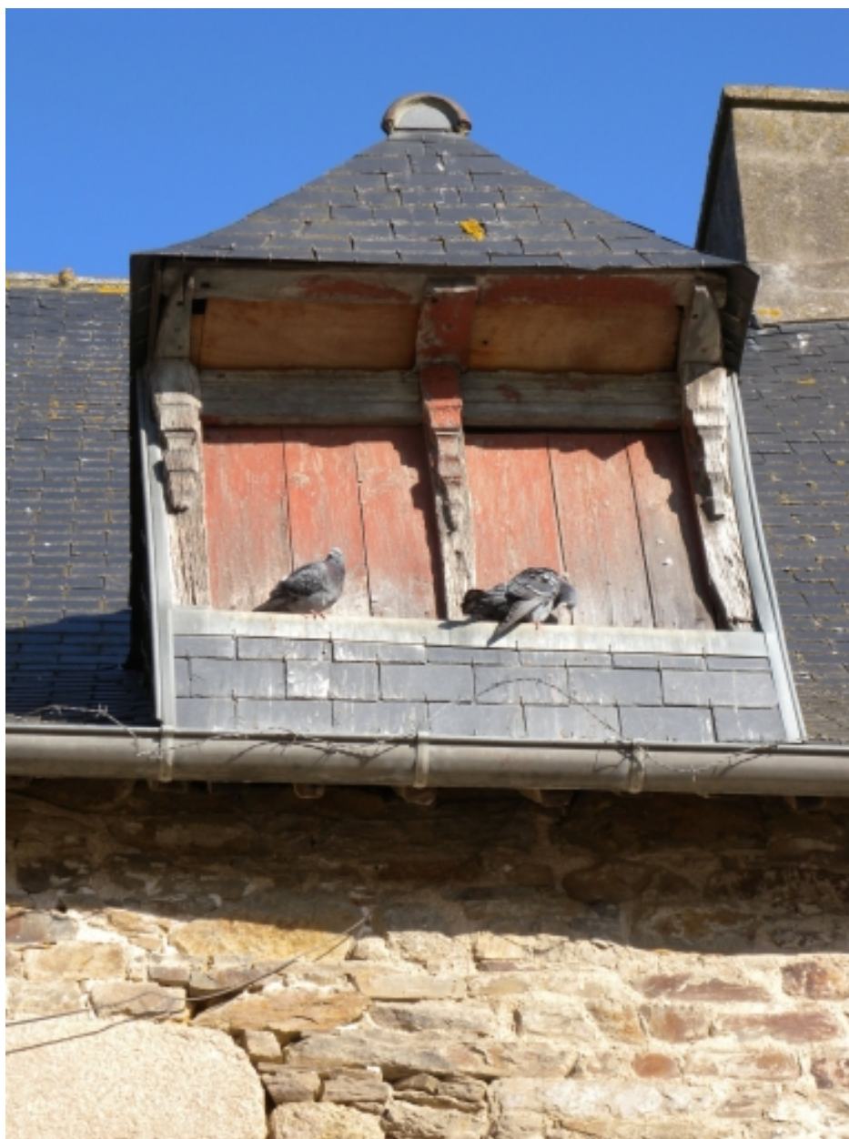
Vue de détail d'une lucarne en bois mouluré
