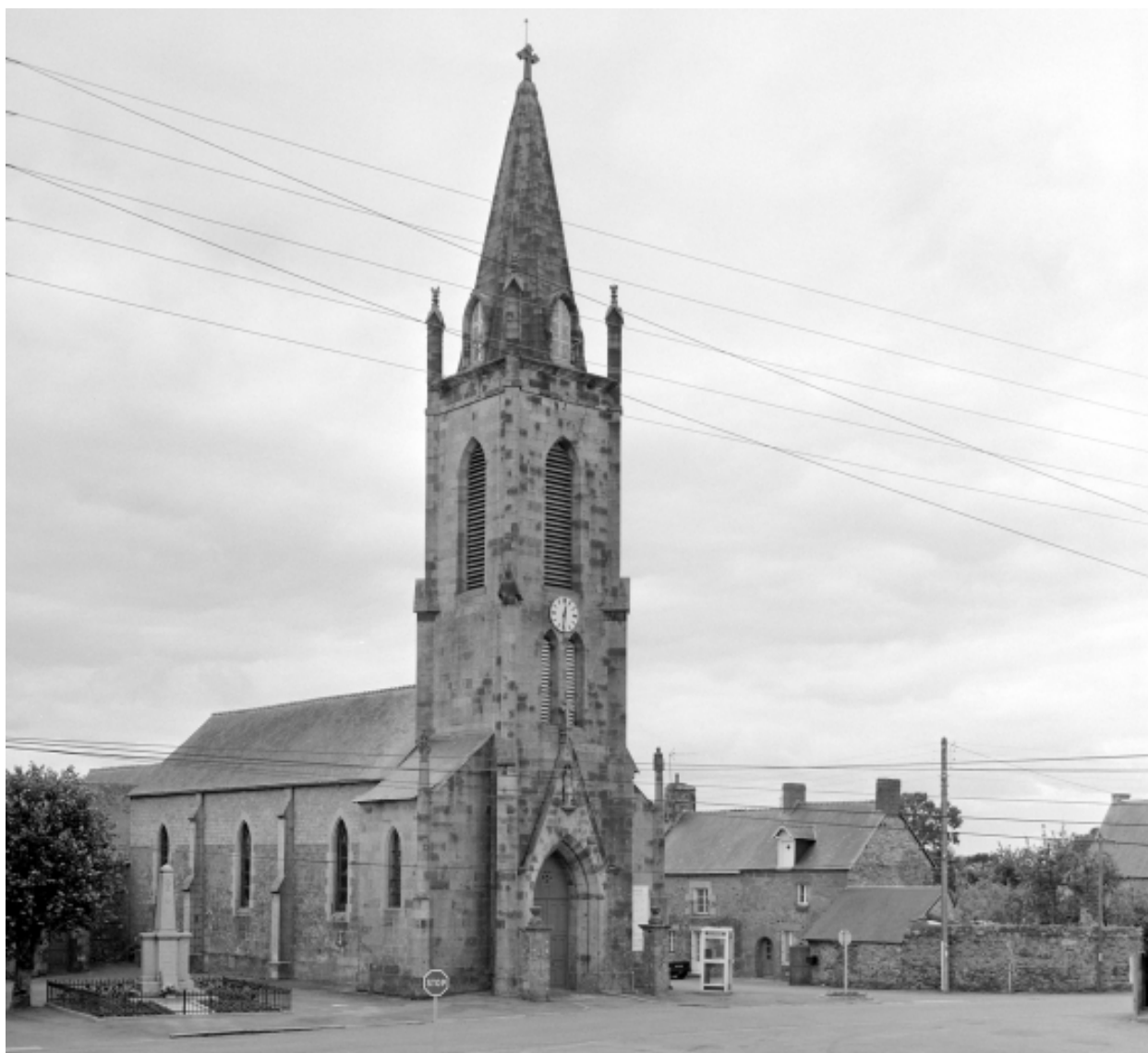
Elévation Nord-Ouest : vue générale
