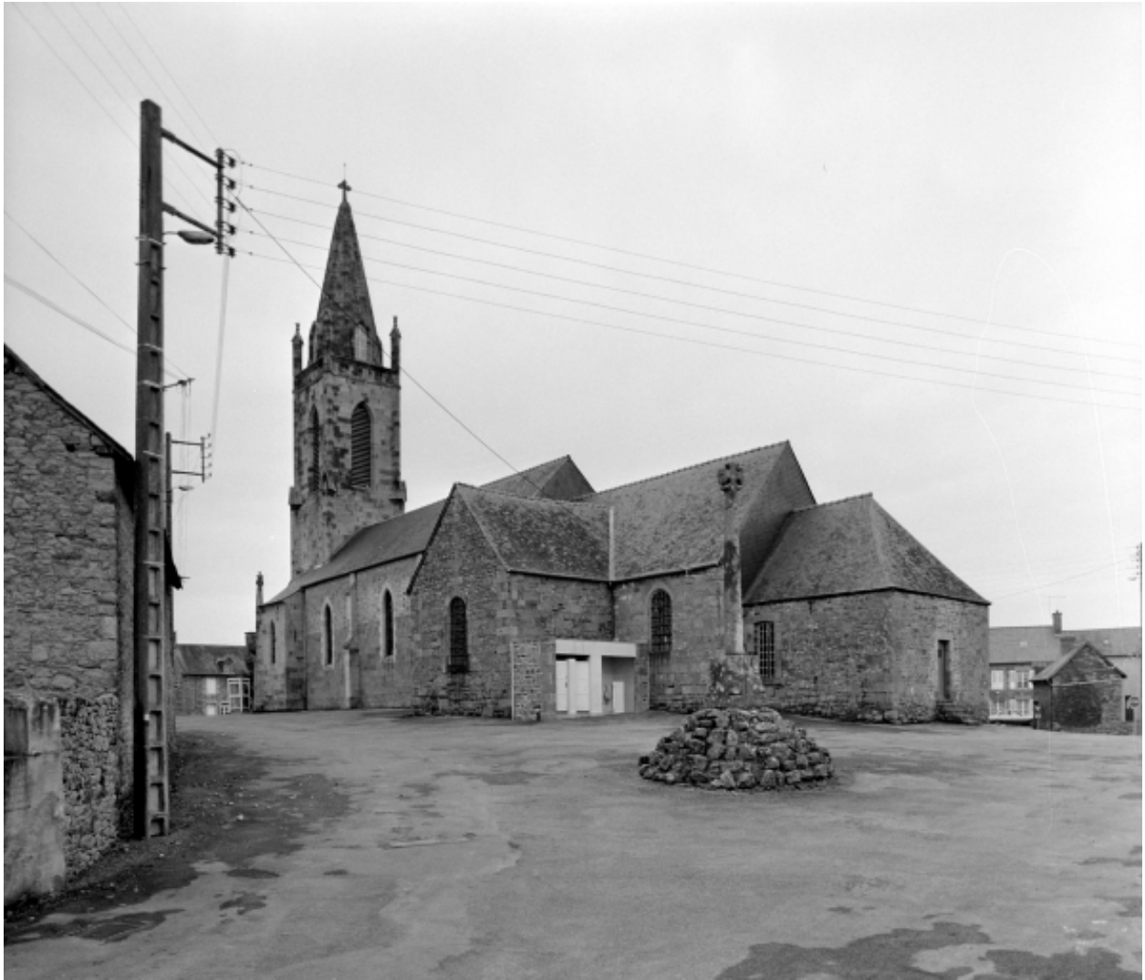
Elévation Sud-Est : vue générale
