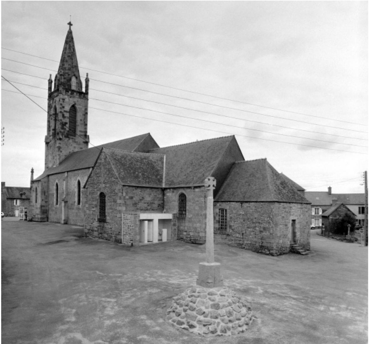
Elévation Sud-Est : vue générale
