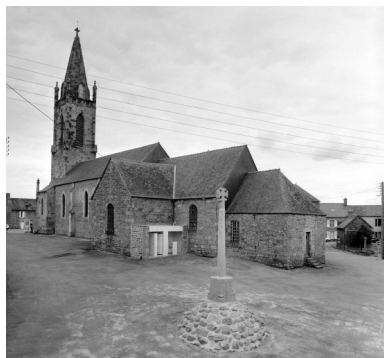
Elévation Sud-Est : vue générale Phot. Guy Artur, Phot. Norbert Lambart IVR53_19943501275X
