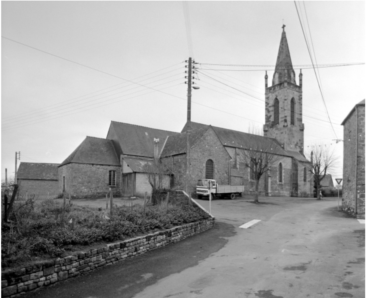
Elévation Nord-Est : vue générale
