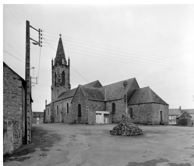
Elévation Sud-Est : vue générale Phot. Guy Artur, Phot. Norbert Lambart IVR53_19943500113X
