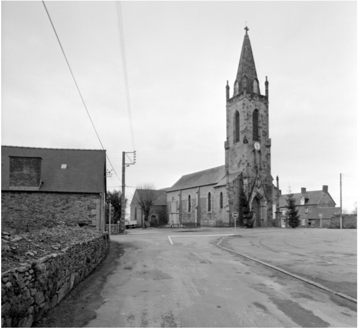
Elévation Nord-Ouest : vue générale
