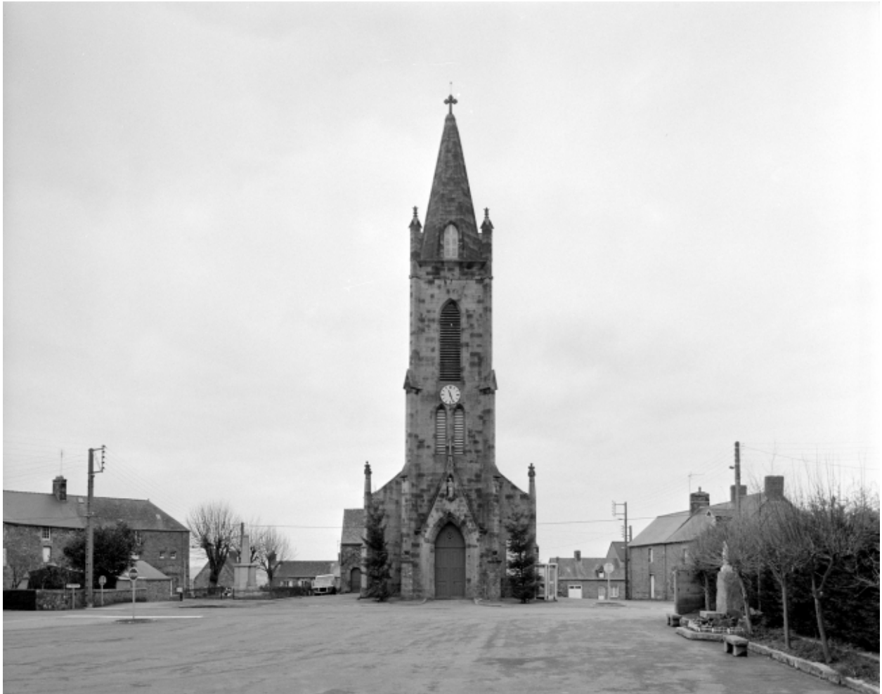
Elévation Ouest : vue générale
