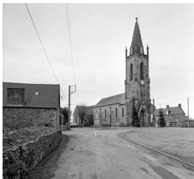
Elévation Nord-Ouest : vue générale Phot. Guy Artur, Phot. Norbert Lambart IVR53_19943500115X
