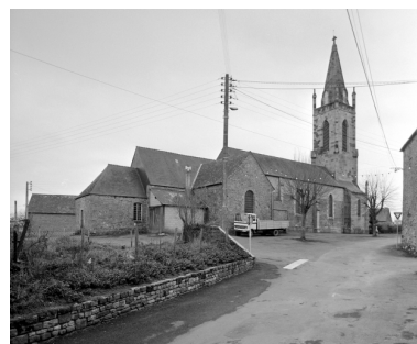
Elévation Nord-Est : vue générale Phot. A. Boden IVR53_19943500116X
