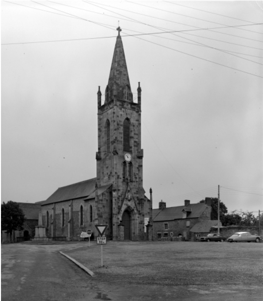
Elévation Nord-Ouest : vue générale
