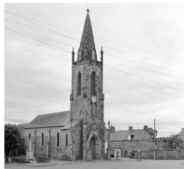
Elévation Nord-Ouest : vue générale Phot. Guy Artur, Phot. Norbert Lambart IVR53_19943501276X
