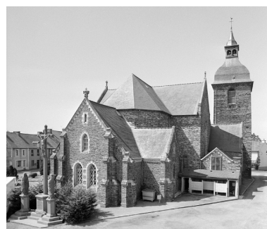
Vue générale est Phot. Guy Artur, Phot. Norbert Lambart IVR53_19943501769X
