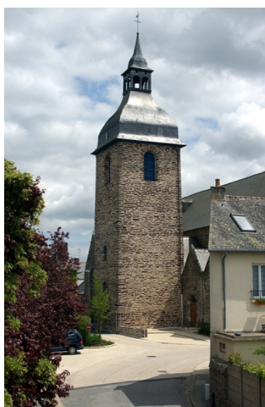
La tour nord bâtie en 1620, vestige de l'ancien édifice Phot. Guy Artur, Phot. Norbert Lambart IVR53_20023502931NUCA
