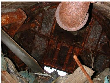
Vue du puits de la cloche blindée : remontée au milieu des débris (état en 2003). L'entrée principale du bunker étant remblayée, le puits de la cloche blindée constitue le seul accès
