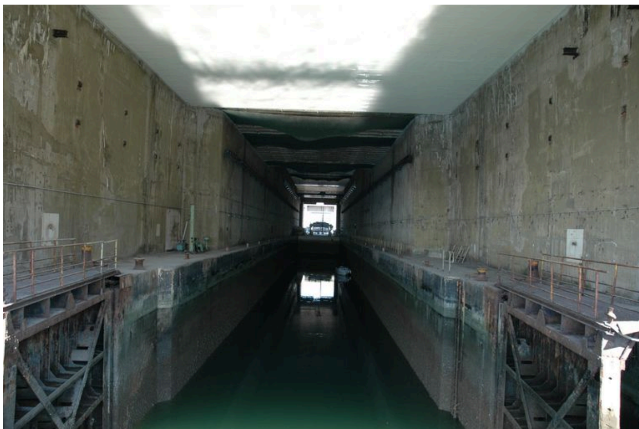
Vue générale de l'intérieur de l'avéole du slipway (2005). Deux portes étanches permettent de retenir l'eau dans le bassin avant le pompage
