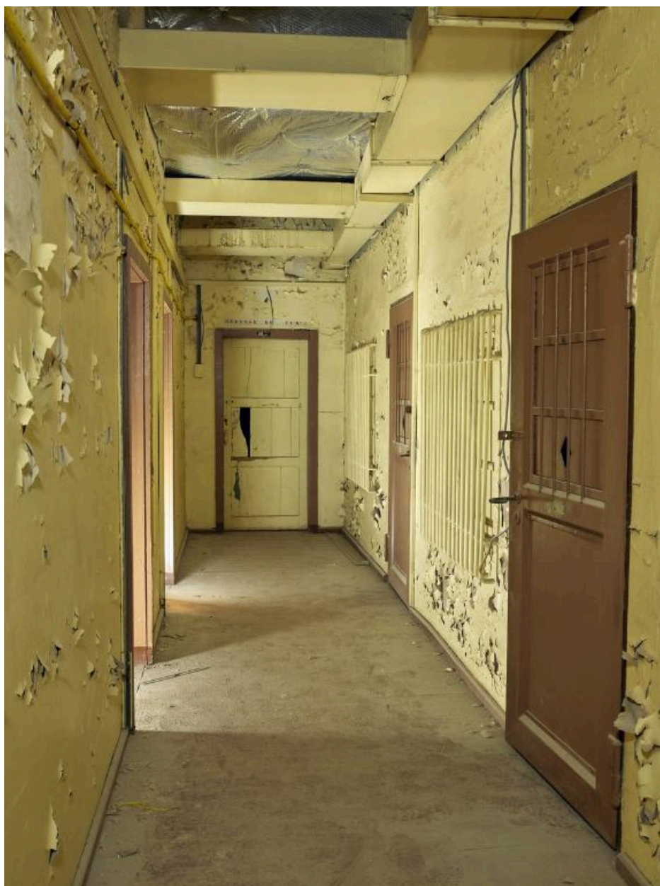
Vue du couloir du troisième étage de la nef n° 3 desservant des bureaux (en 1945). Les deux bureaux situés à droite ont été transformés en cellule (porte et fenêtre barreautes)
