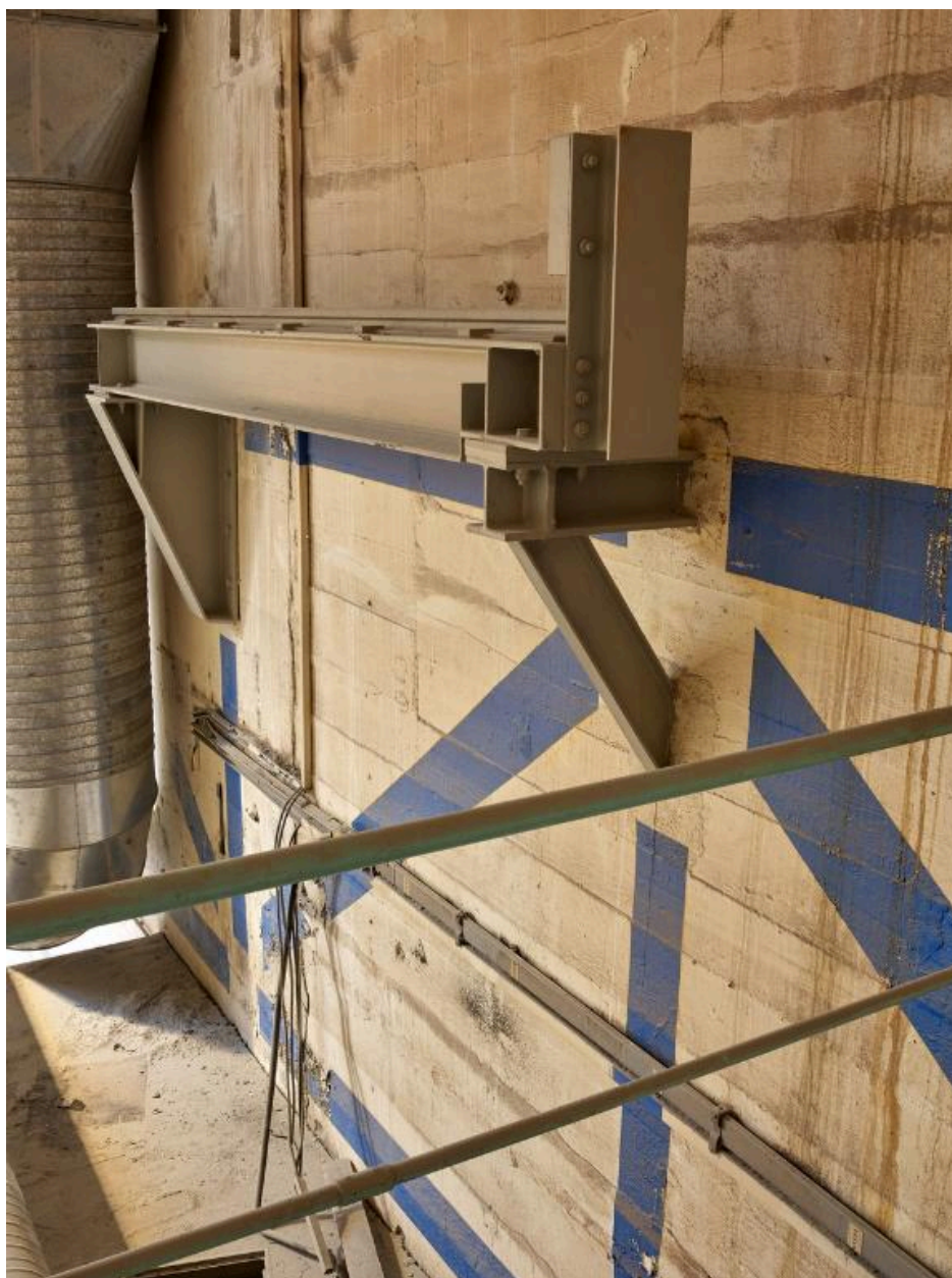
Vue de l'extrémité du chemin de roulement du pont roulant de la nef n° 3
