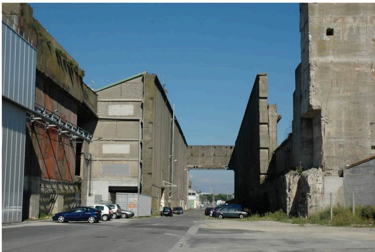
Vue des bunkers "KI" (à gauche) et "KIV" (à droite) : au centre, la rue du Commandant-L'Herminier (2005)
