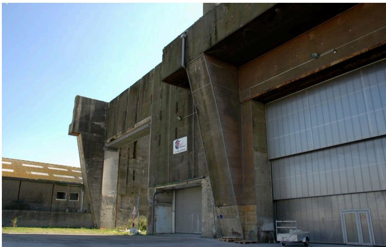
Vue de l'angle nord du bunker "KI" (alvéole K5) et mur du bunker "KIV"
