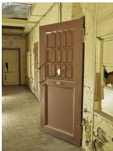
Vue du couloir du troisième étage de la nef n° 3 desservant des bureaux (en 1945). Les deux bureaux situés à droite ont été transformés en cellule (porte et fenêtre barreautes) Phot. Bernard Bègne IVR53_20235600129NUCA
