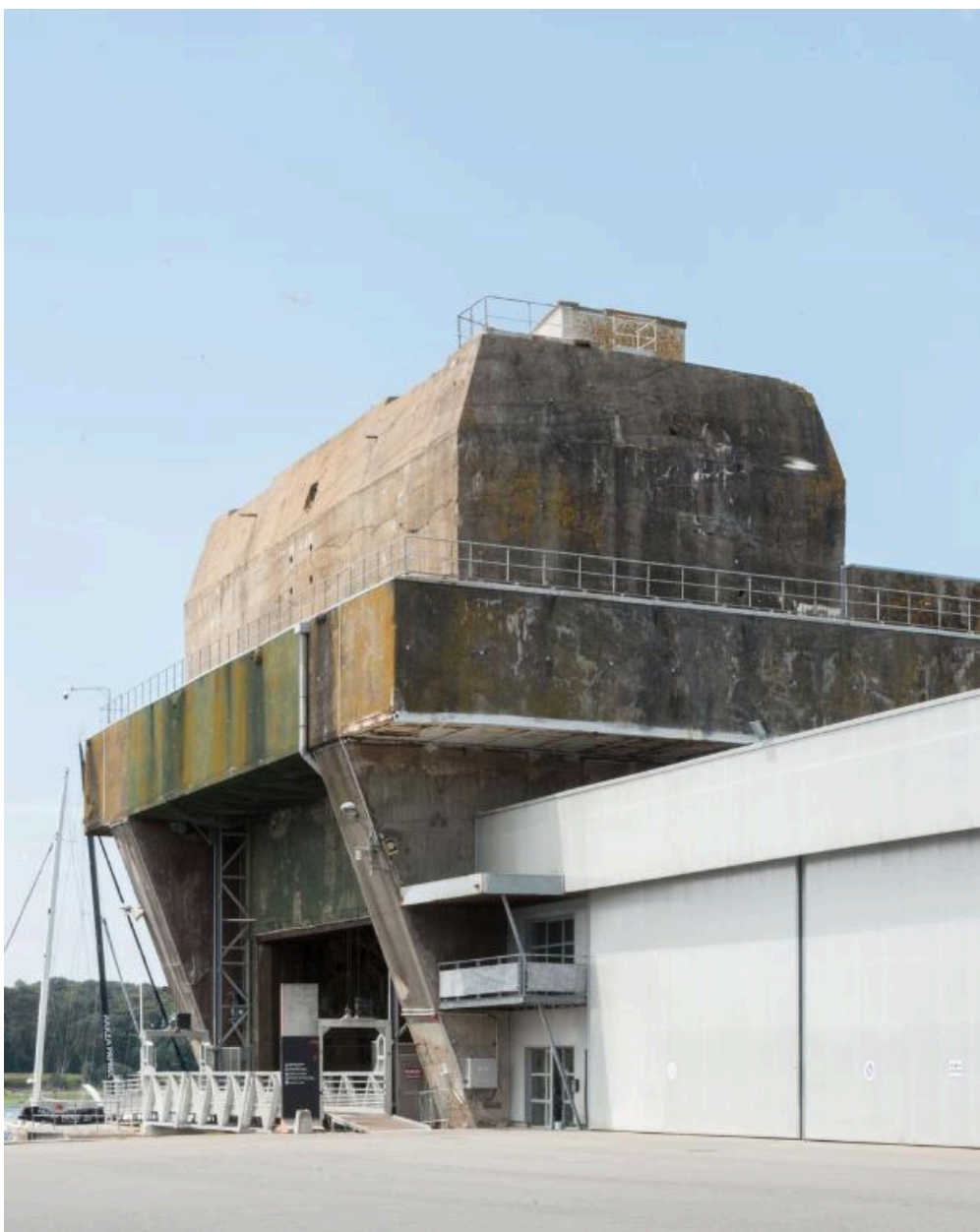
Vue de l'entrée du slipway surmontée d'un envuvement pour un canon antiaérien. A droite, docks
