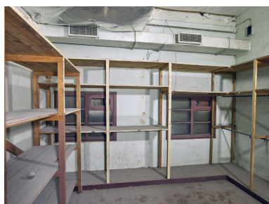
Vue de l'une des pièces du troisième étage de la nef n° 3 : bureau (en 1945), transformé en magasin avec étagères de rangement. A signaler : baies en second jour, plancher en bois et système de ventilation par bouches de soufflage
