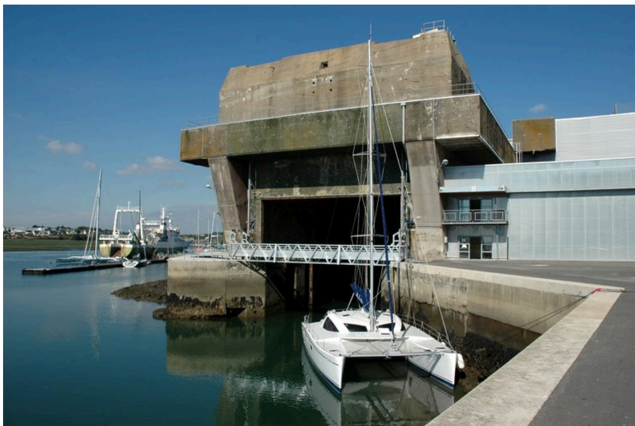
Vue de l'entrée du slipway (2005). Au premier plan, grand catamaran de croisière. A droite, flankant le bunker, docks
