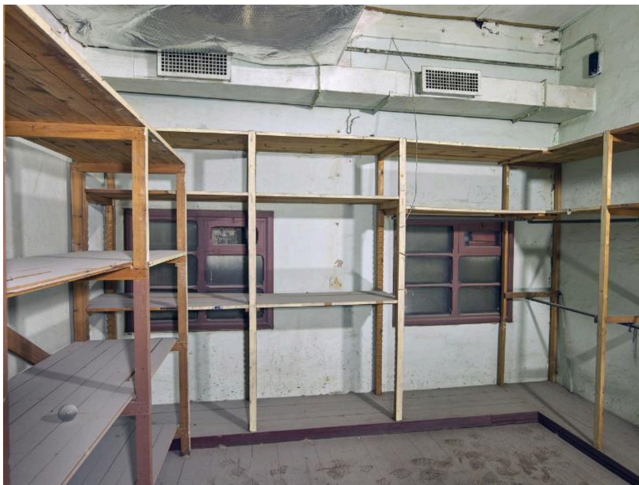
Vue de l'une des pièces du troisième étage de la nef n° 3 : bureau (en 1945), transformé en magasin avec étagères de rangement. A signaler : baies en second jour, plancher en bois et système de ventilation par bouches de soufflage
