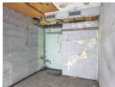
Vue de l'une des pièces du troisième étage de la nef n° 3 : bureau (en 1945). A signaler : plancher en bois, emplacement d'un radiateur et système de ventilation par bouches de soufflage Phot. Bernard Bègne IVR53_20235600130NUCA
