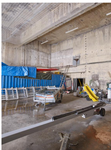
Vue la chaudronnerie devenue atelier du Port à sec : accroché au mur, un lavabo de la période allemande témoigne de la présence d'un étage
