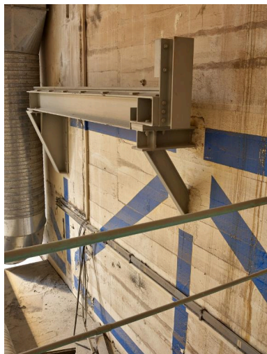
Vue de l'extrémité du chemin de roulement du pont roulant de la nef n° 3 Phot. Bernard Bègne IVR53_20235600126NUCA
