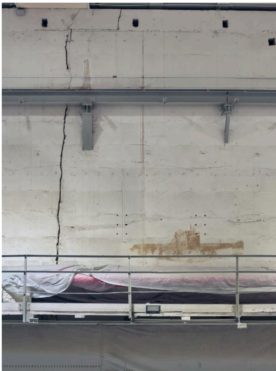
Vue de l'une des peintures murales d'origine française de la nef n° 1 : représentation d'un sous-marin de type "Daphné" (passerelle est). En haut, le chemin de roulement des ponts roulants. La nef abrite le chantier naval Marsaudon Composites
