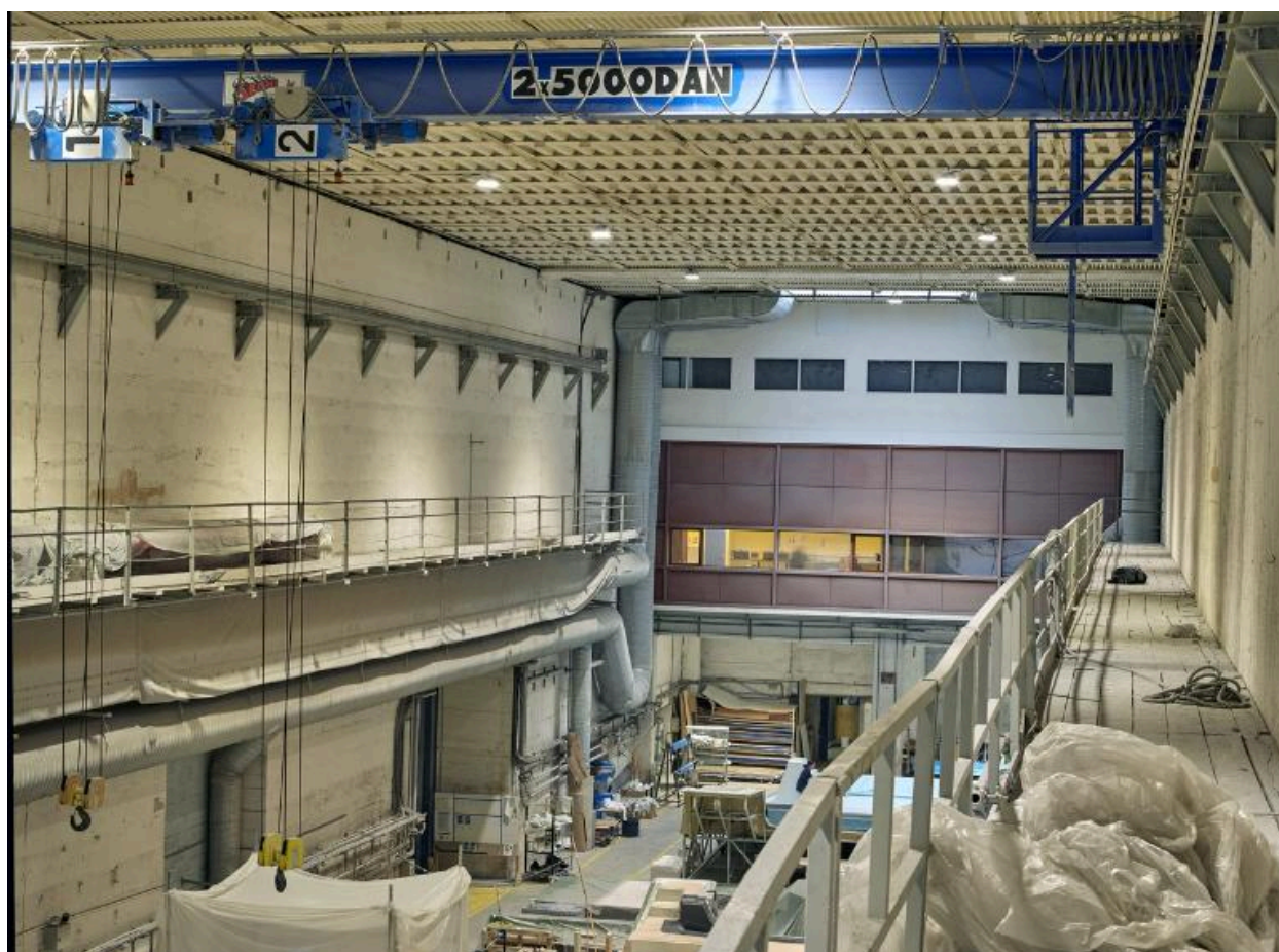
Vue de l'extrémité sud de la nef n° 1 depuis la passerelle ouest. En haut, au premier plan : l'un des deux ponts roulants. La nef abrite le chantier naval Marsaudon Composites
