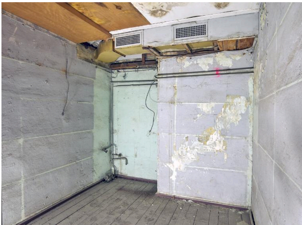
Vue de l'une des pièces du troisième étage de la nef n° 3 : bureau (en 1945). A signaler : plancher en bois, emplacement d'un radiateur et système de ventilation par bouches de soufflage
