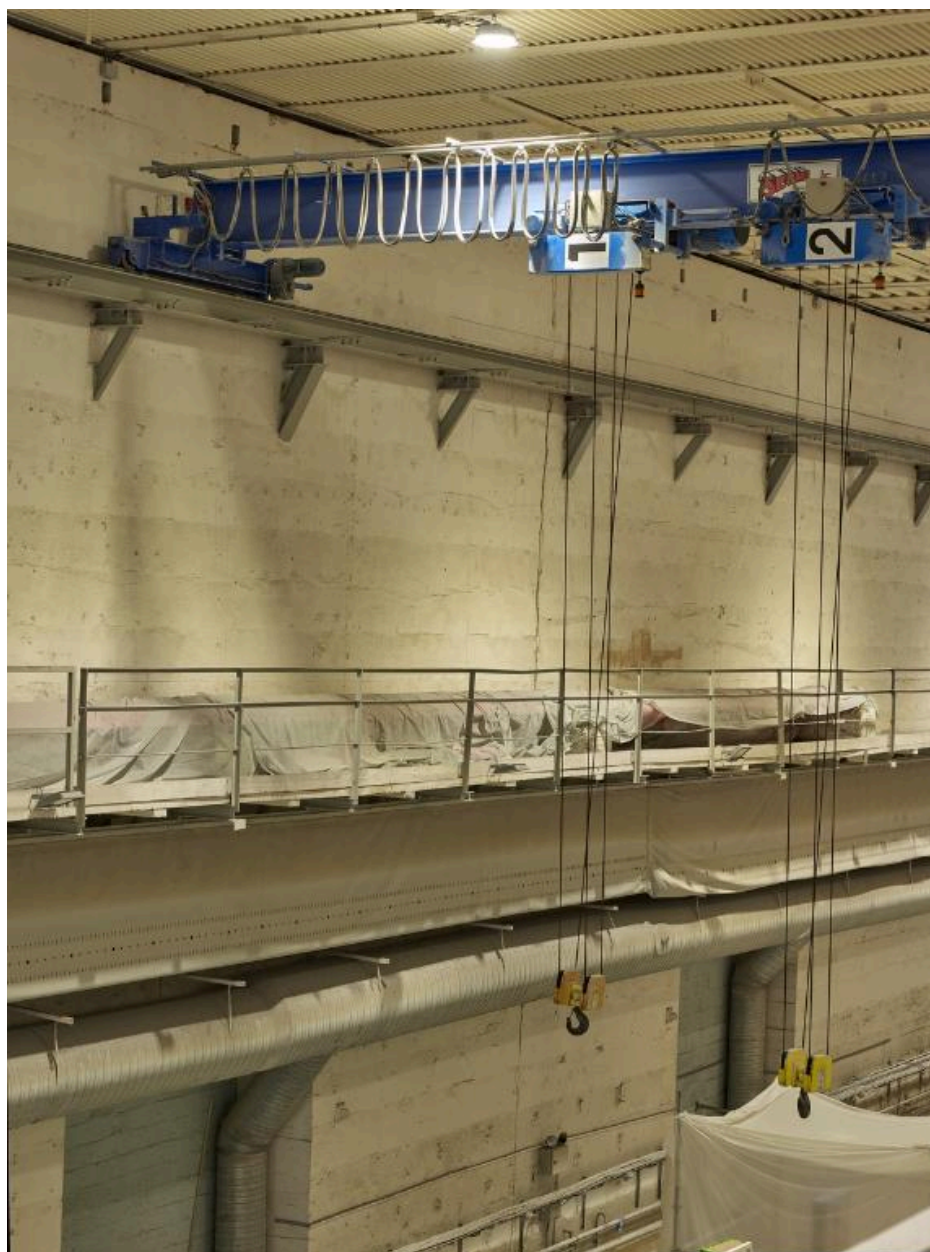
Vue de la passerelle est et de l'un des deux ponts roulants de la nef n° 1. Sur le mur, l'une des peintures murales d'origine française : représentation d'un sous-marin de type "Daphné". La nef abrite le chantier naval Marsaudon Composites
