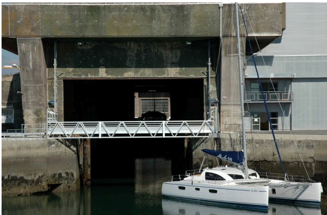
Vue de l'entrée du slipway (2005). Au premier plan à droite, grand catamaran de croisière
