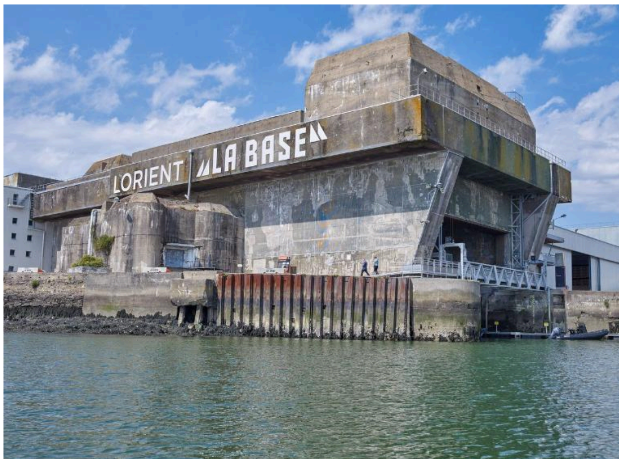
Vue de l'entrée du slipway, élévation ouest. Le bunker "KI" est surmonté d'un envuvement pour un canon antiaérien. A gauche, casemate de flanquement
