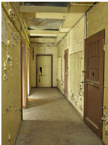
Vue du couloir du troisième étage de la nef n° 3 desservant des bureaux (en 1945). Les deux bureaux situés à droite ont été transformés en cellule (porte et fenêtre barreautes) Phot. Bernard Bègne IVR53_20235600127NUCA
