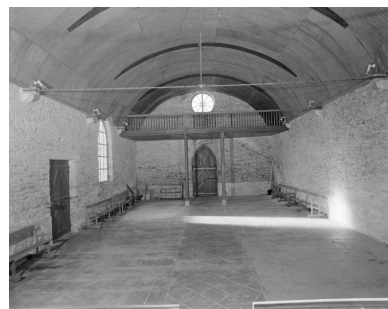
Vue intérieure, nef vers l'ouest. Phot. Bernard Bègne IVR53_19975600741X
