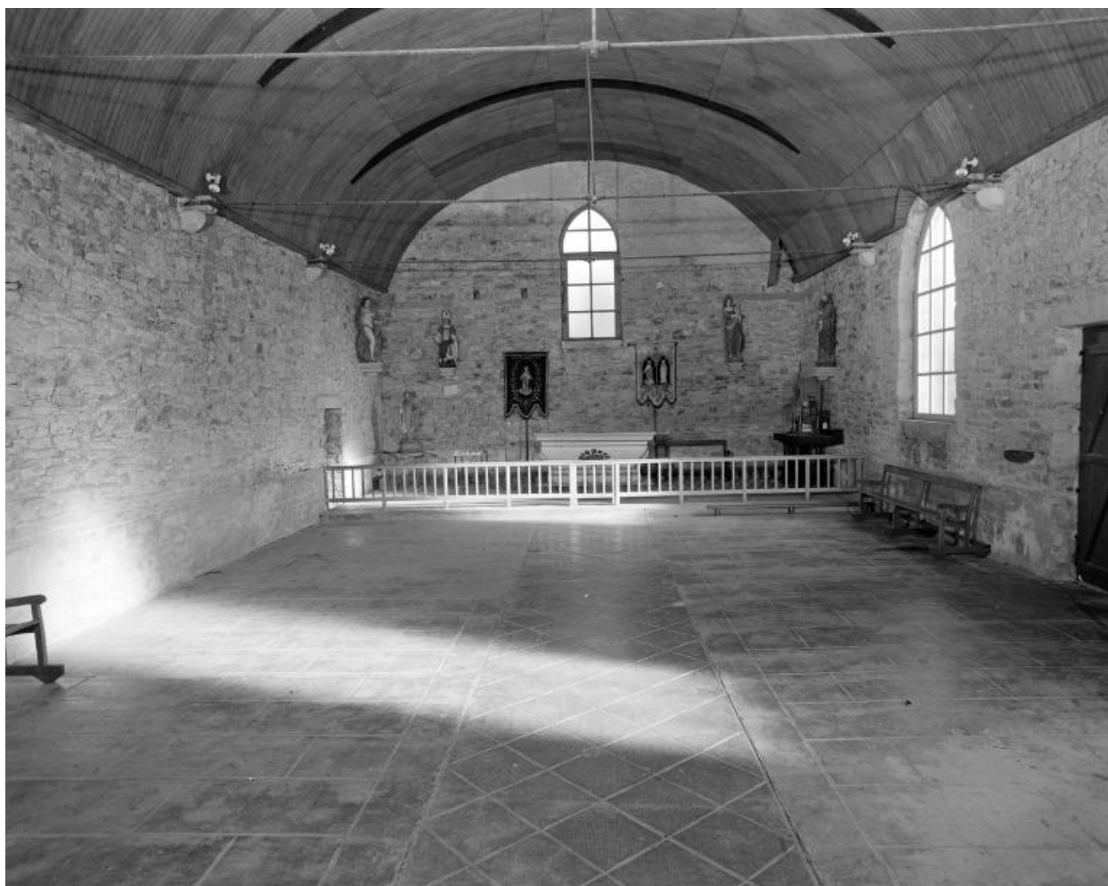
Vue intérieure vers l'est.
