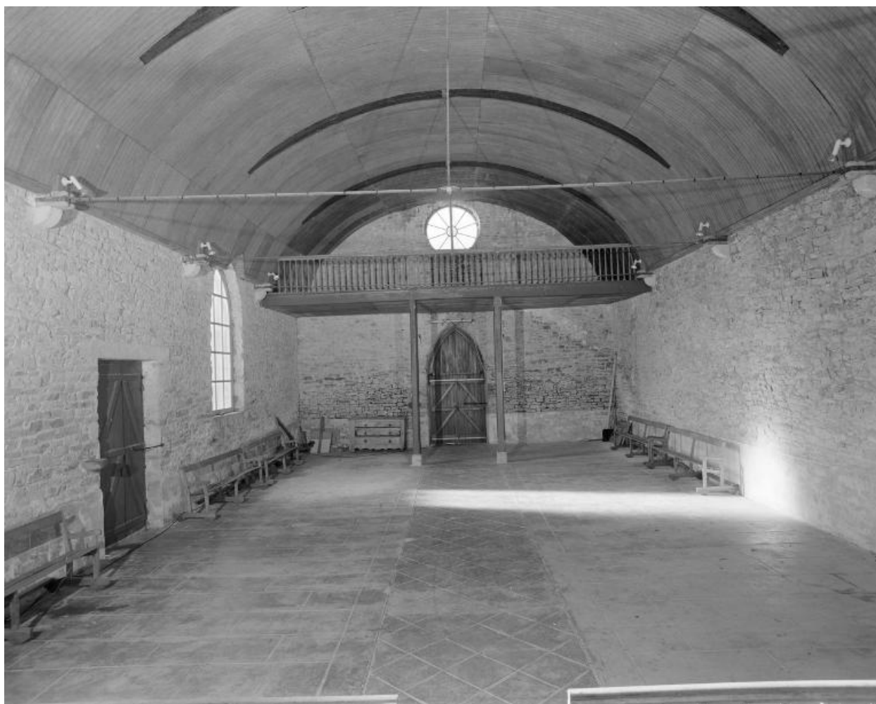
Vue intérieure, nef vers l'ouest.
