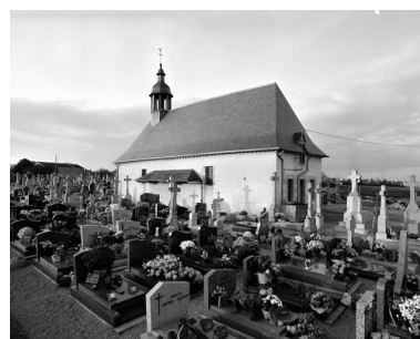
Elévation Sud-Est : vue générale Phot. Bernard Bègne, Phot. M. Loyon IVR53_19923500974X
