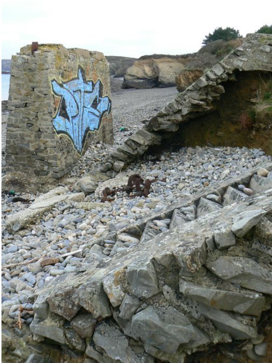
Vestiges de l'annexe du centre d'aviation maritime
