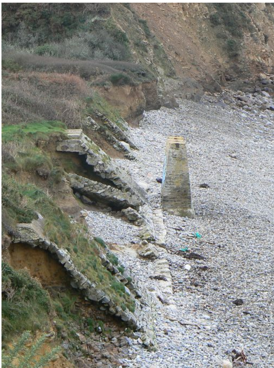
Vestiges de l'annexe du centre d'aviation maritime
