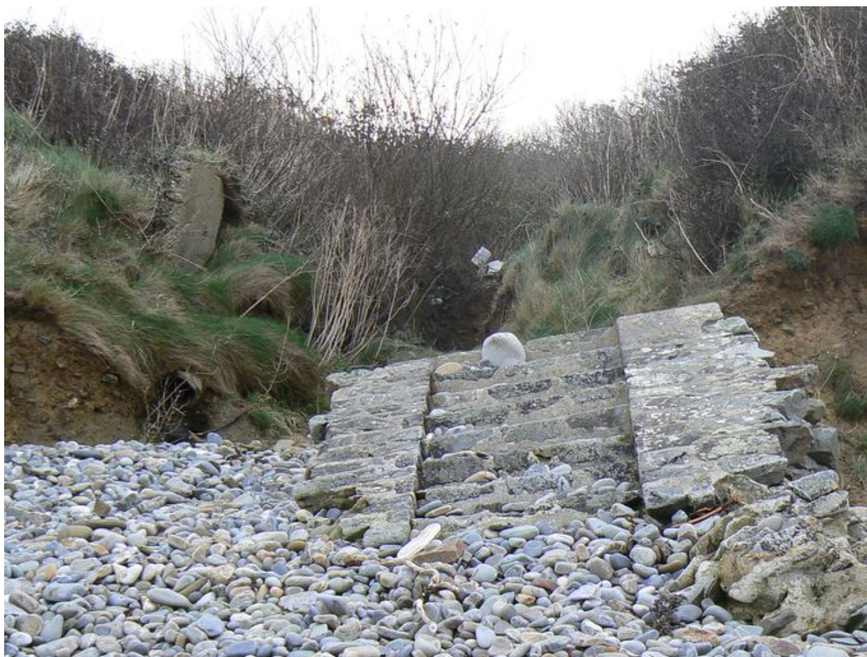
Vestiges de l'annexe du centre d'aviation maritime, détail de l'escalier
