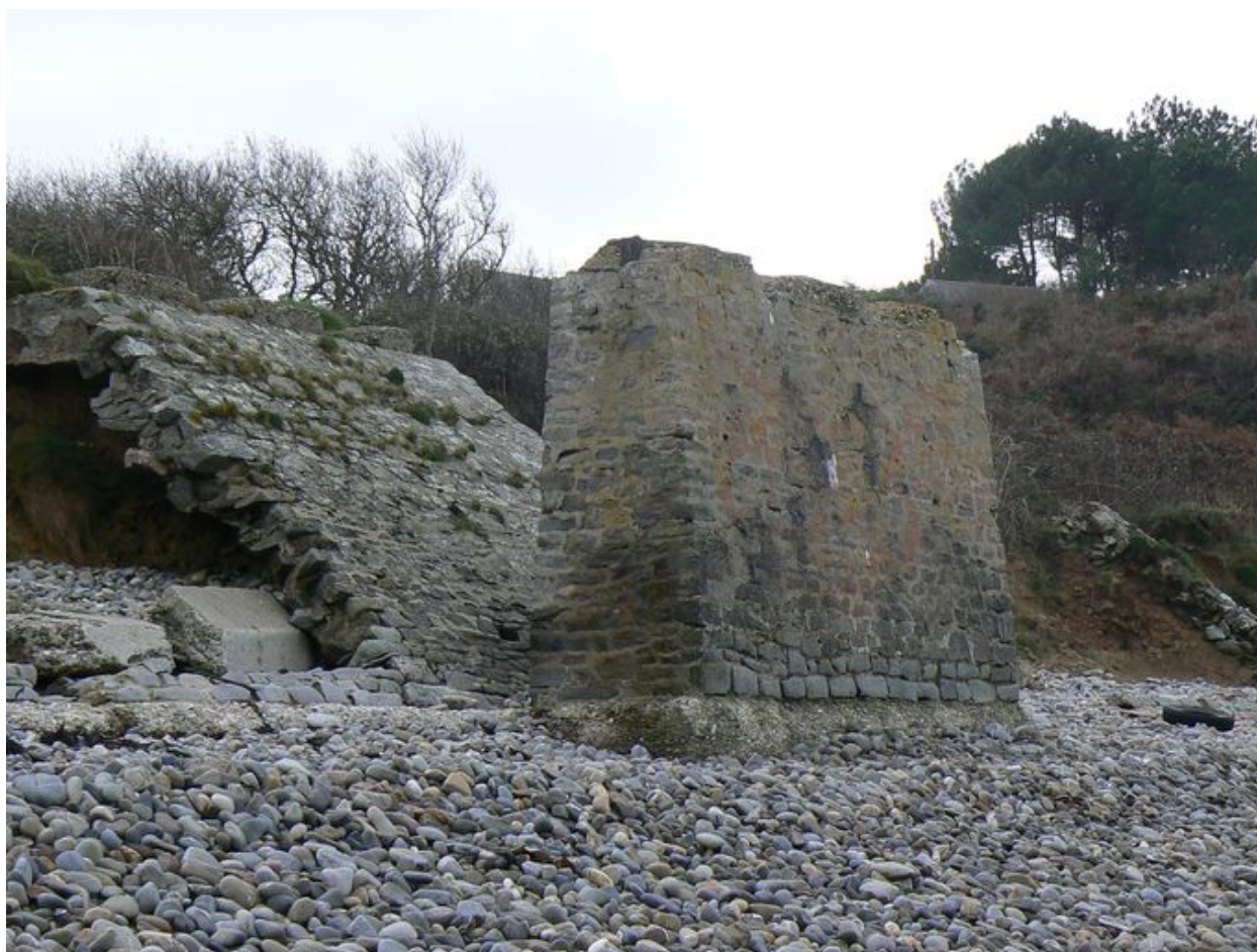
Vestiges de l'annexe du centre d'aviation maritime
