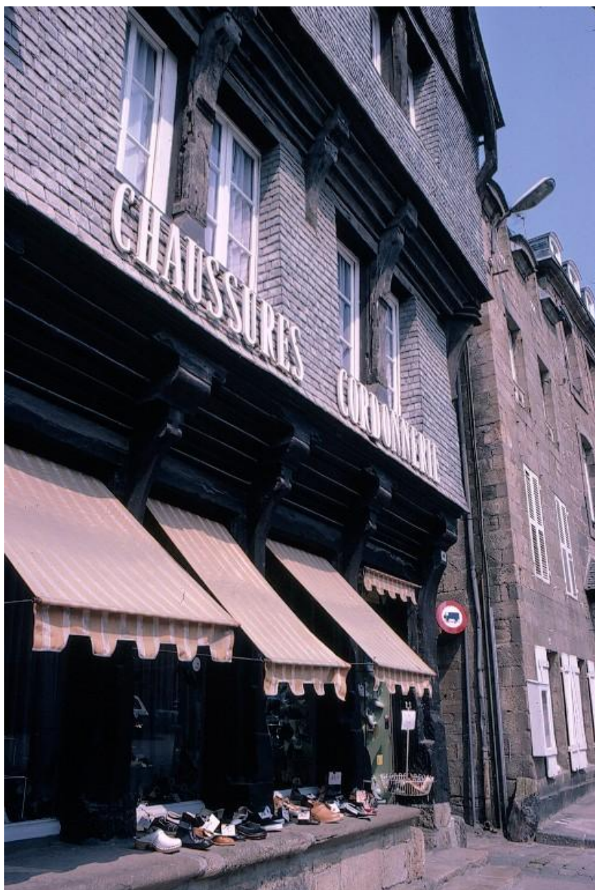
Maison n°3, vue latérale du rez-de-chaussée et du premier étage.
