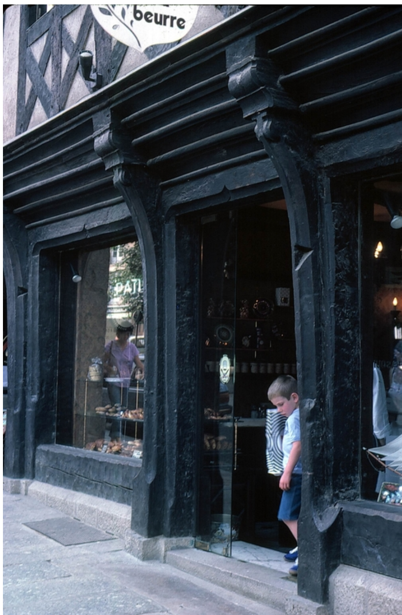
Maison n°5, vue de détail du rez-de-chaussée et de l'encorbellement.
