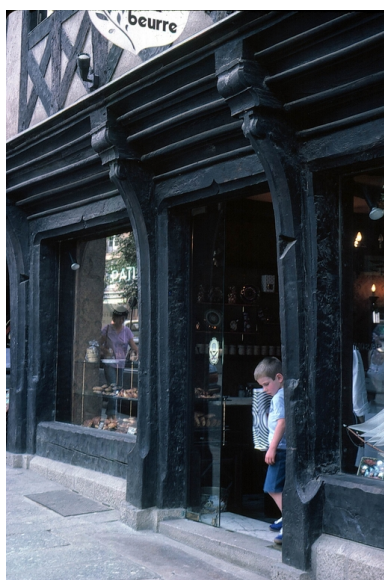
Maison n°5, vue de détail du rez- de-chaussée et de l'encorbellement. Phot. Service régional de l'Inventaire de Bretagne IVR53_19852200182ZA
