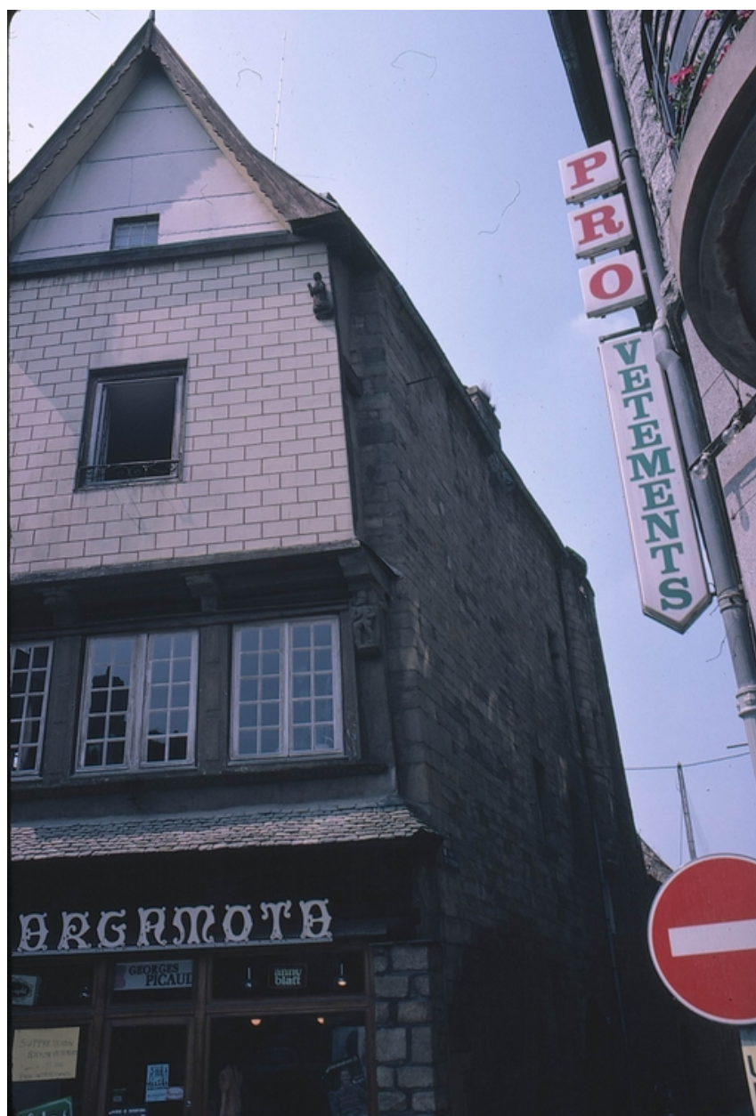
Maison n°2, vue générale, angle droit.
