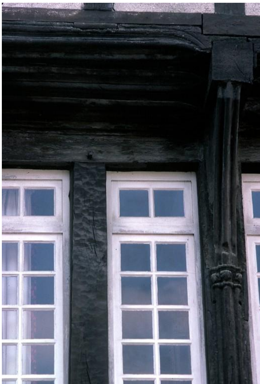
Maison n°1, détail de fenêtre et encorbellement.
