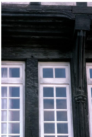
Maison n°1, détail de fenêtre et encorbellement. Phot. Auteur inconnu (phototype/graphique) IVR53_19842200133ZA
