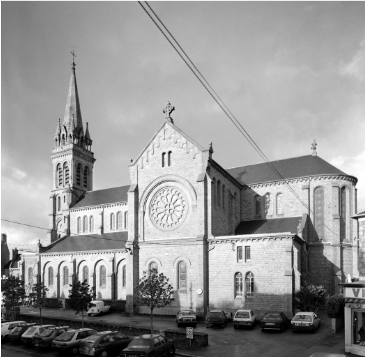
Elévation Sud : vue générale
