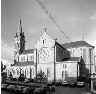
Elévation Sud : vue générale Phot. Guy Artur, Phot. Norbert Lambart IVR53_19943502418V
