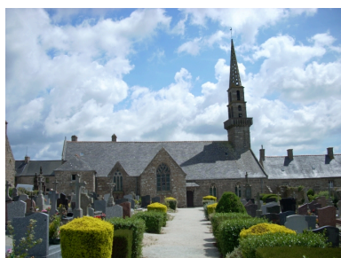
Brélès, église paroissiale : élévation nord Phot. Gwénaél Fauchille IVR53_20082906220NUCA
