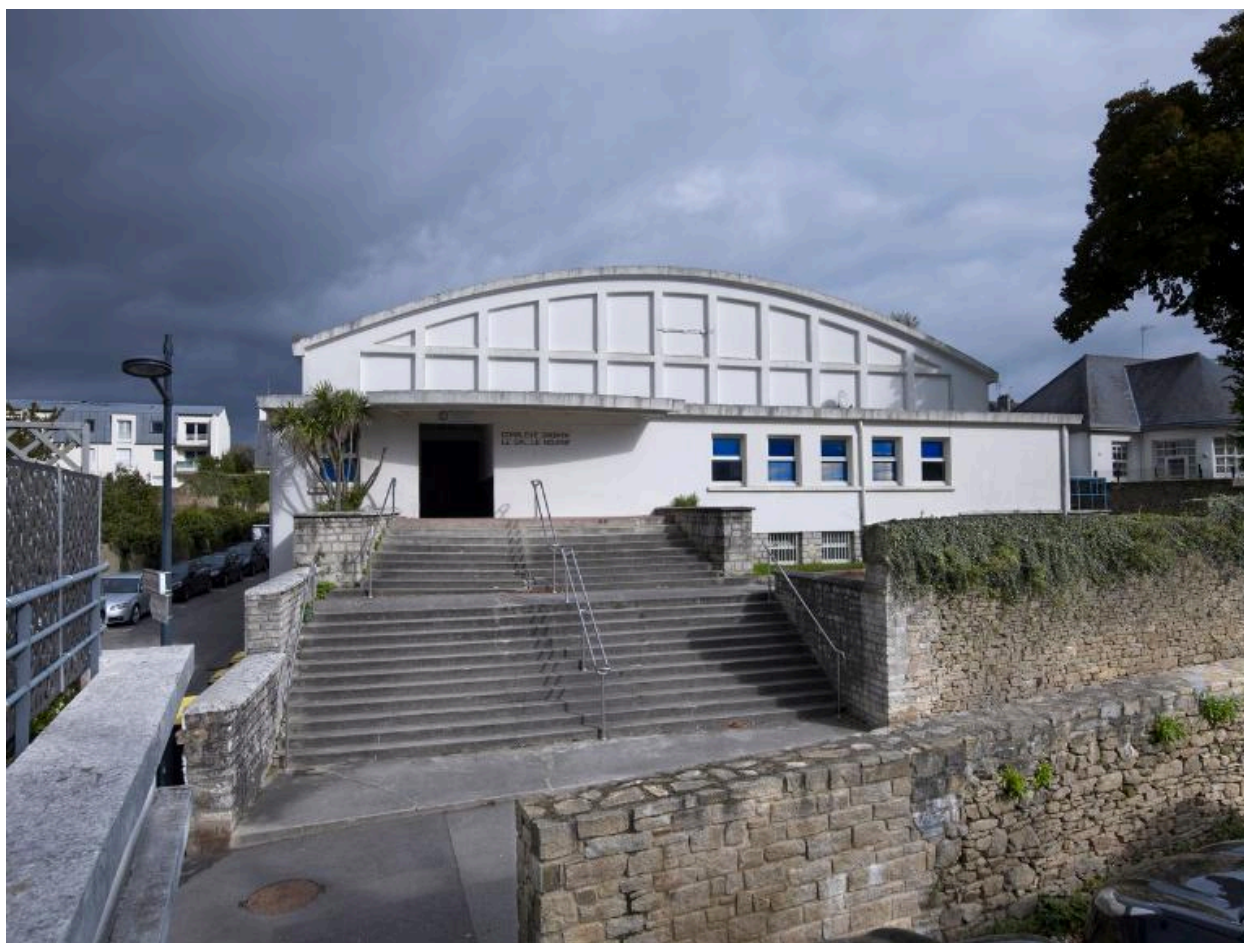
Vue générale prise du sud
