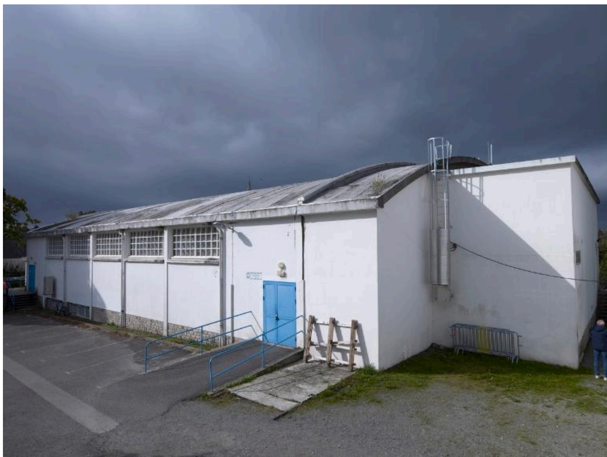
Vue générale prise du nord-est
