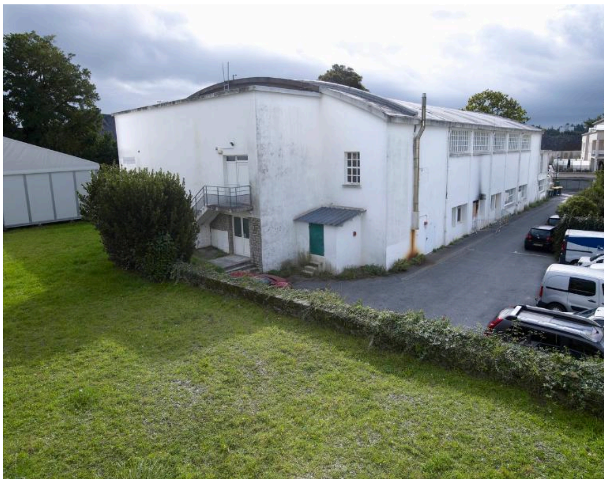
Vue générale prise du nord-ouest
