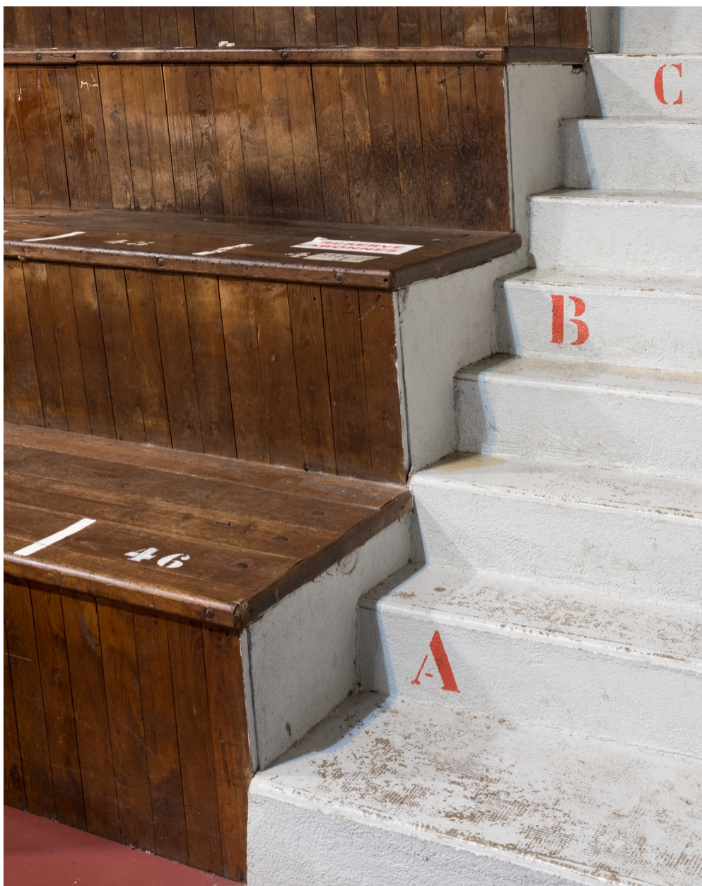
Gradins en bois, les sièges y sont numérotés à la peinture blanche ; marches en béton avec indication des rangs peints en rouge
