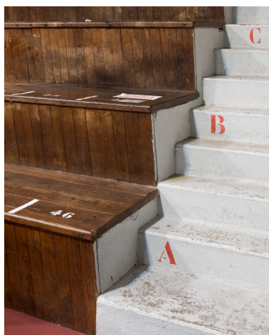
Gradins en bois, les sièges y sont numérotés à la peinture blanche ; marches en béton avec indication des rangs peints en rouge
