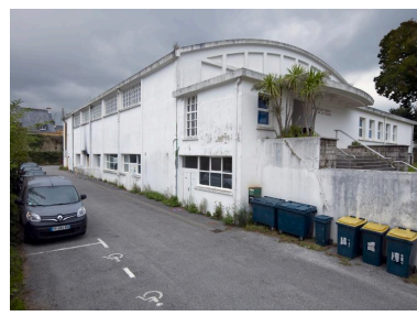
Le gymnase vu du sud-ouest Phot. Bernard Bègne IVR53_20195600405NUCA
