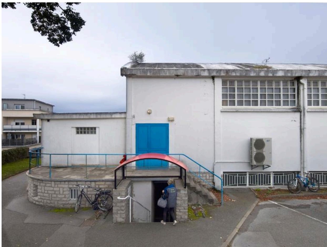
Angle sud-est du gymnase
