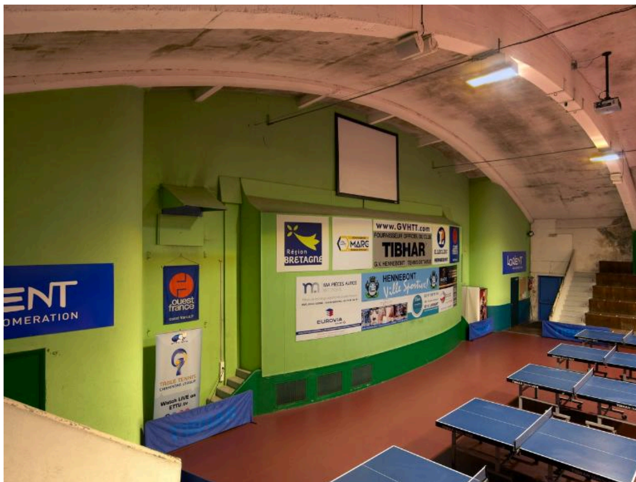
La voûte en béton
