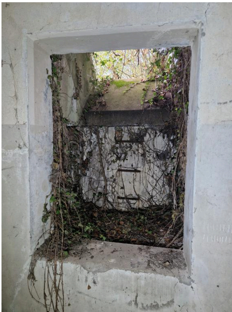
Vue de la fenêtre de la pièce ouest
