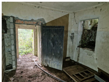
Vue de l'entrée de la pièce ouest. A droite, fenêtre Phot. Guillaume Lécueillier IVR53_20232205403NUCA
