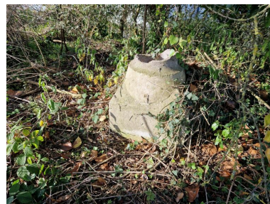
Vue de la souche de cheminée émergeant de la dalle de couverture Phot. Guillaume Lécueillier IVR53_20232205394NUCA
