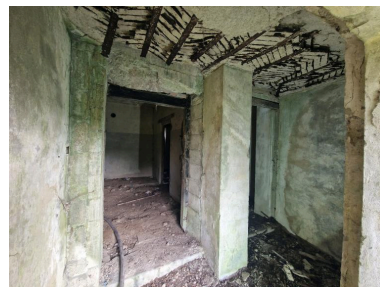
Vue du vestibule depuis l'entrée : il donne sur deux portes. Au centre, pilier en parpaing plein soutenant la dalle de couverture. Au plafond, ferrailage composé de grilles métalliques de roulement pour piste d'avion Phot. Guillaume Lécueillier IVR53_20232205397NUCA
