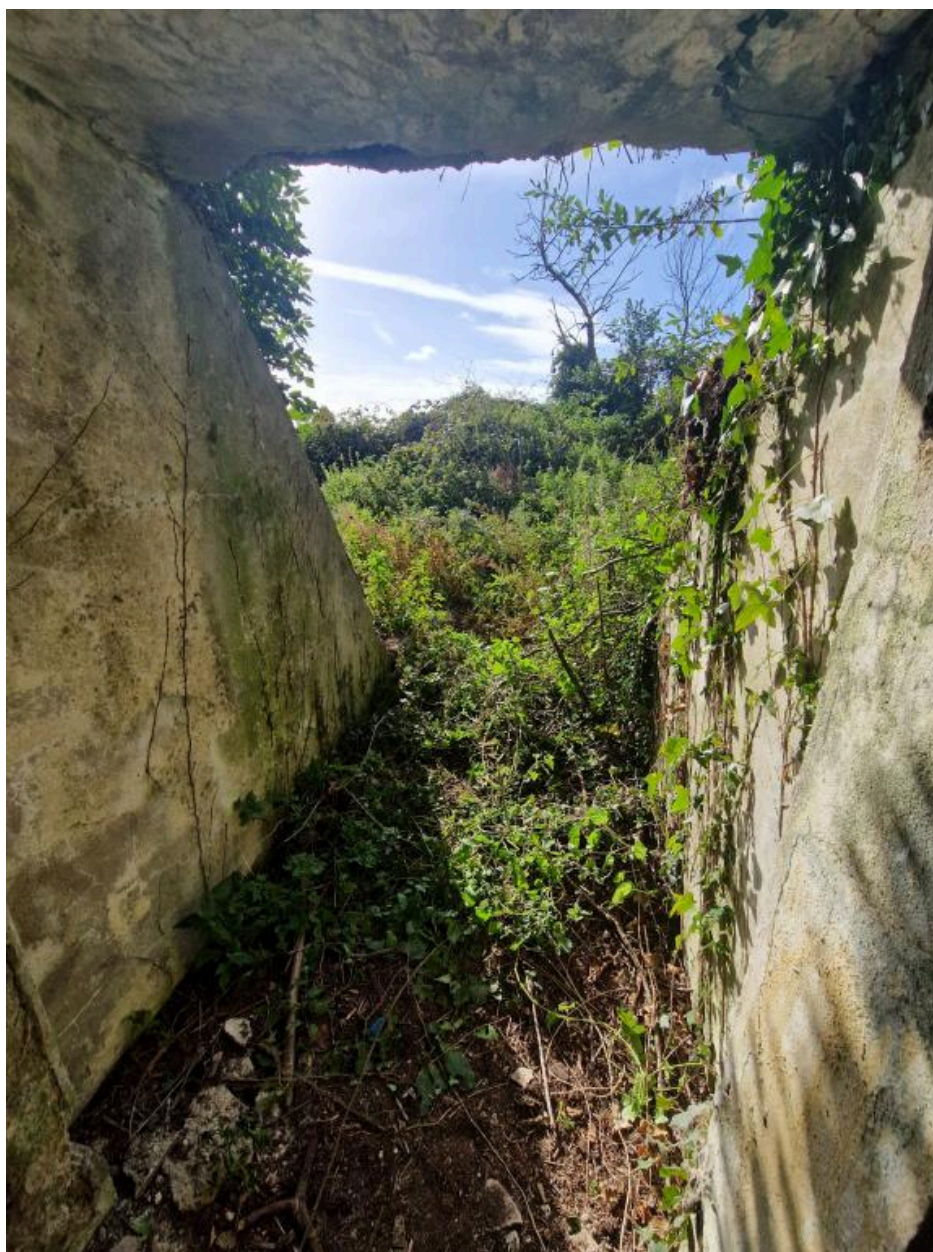
Vue de l'entrée située au sud depuis le vestibule : elle est protégée par deux murs latéraux obliques
