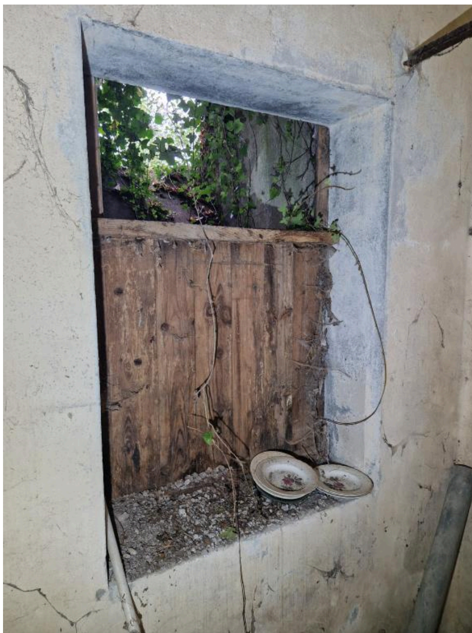
Vue de la fenêtre de la petite pièce ouest située au fond
