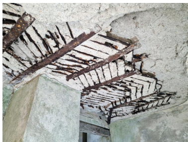
Vue du ferrailage de la dalle de couverture composé de grilles métalliques de roulement pour piste d'avion Phot. Guillaume Lécueillier IVR53_20232205399NUCA
