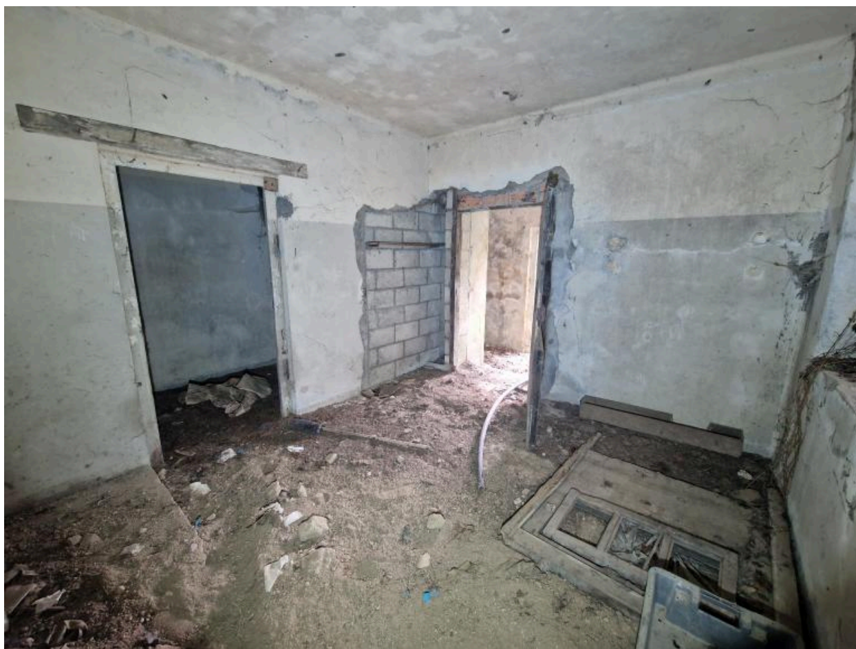
Vue générale de la pièce ouest. A gauche, porte donnant sur le couloir est. Au sol à droite, la porte en bois avec jour
