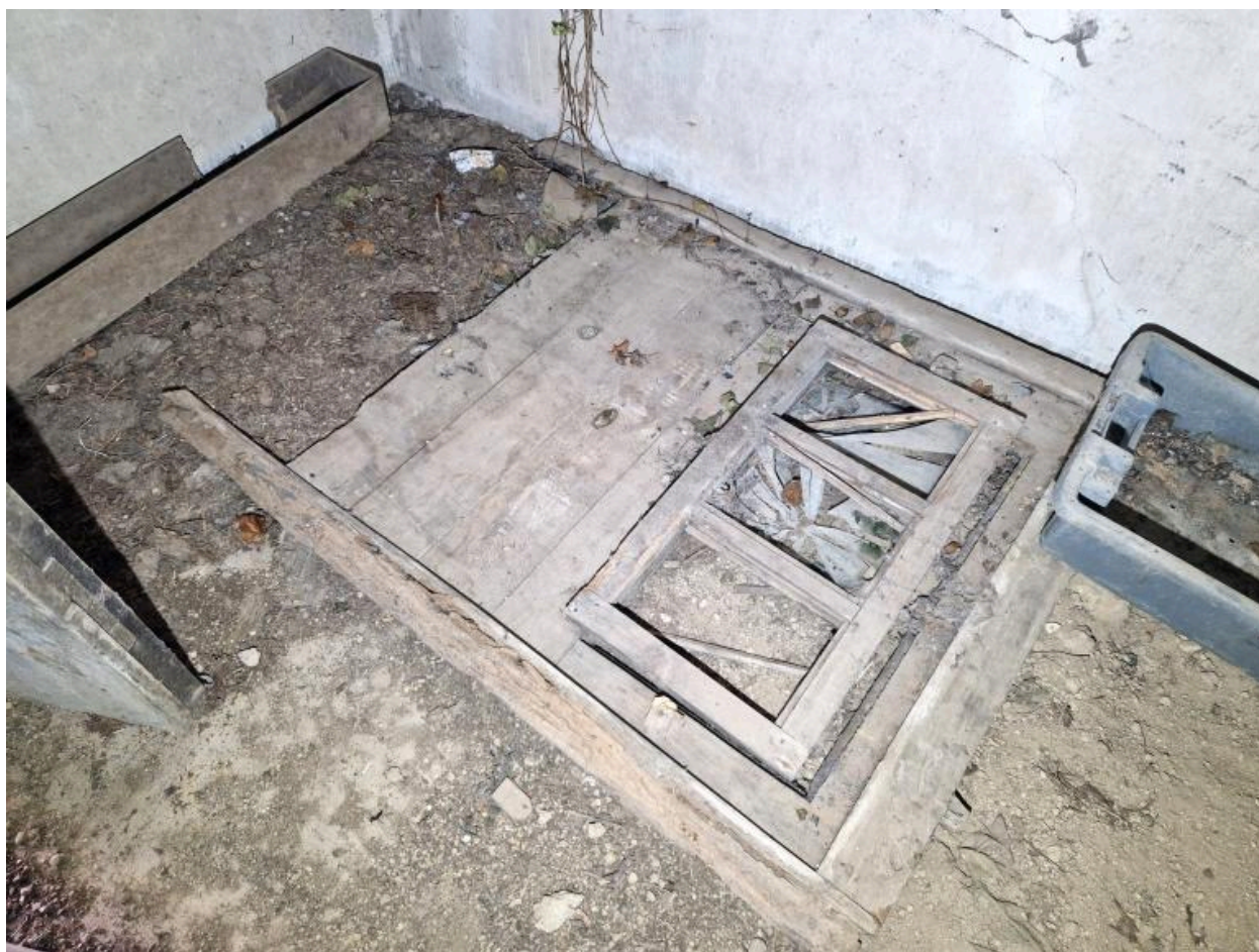
Vue de la porte en bois avec jours gisant au sol dans la pièce ouest
