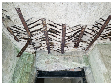
Vue du ferrailage de la dalle de couverture composé de grilles métalliques de roulement pour piste d'avion Phot. Guillaume Lécueillier IVR53_20232205398NUCA
