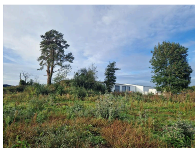
Vue de situation depuis le nord Phot. Guillaume Lécueillier
