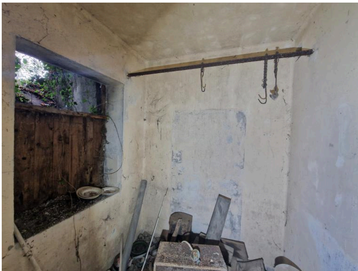
Vue de la petite pièce ouest située au fond
