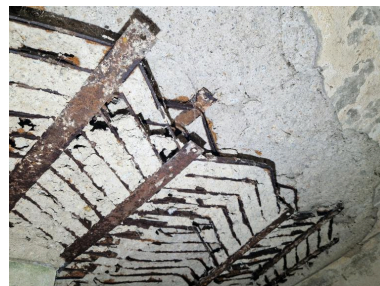
Vue du ferrailage de la dalle de couverture composé de grilles métalliques de roulement pour piste d'avion Phot. Guillaume Lécueillier IVR53_20232205400NUCA
