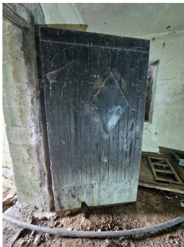
Vue de la porte en bois de la pièce ouest Phot. Guillaume Lécueillier IVR53_20232205405NUCA
