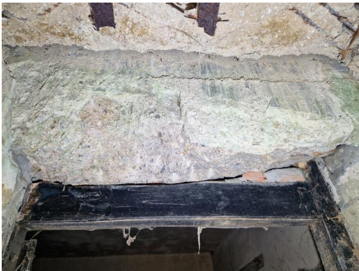
Vue du linteau en béton armé de la porte ouest depuis le vestibule
