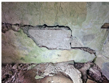
Vue du mur ouest en parpaing plein du vestibule Phot. Guillaume Lécueillier IVR53_20232205401NUCA
