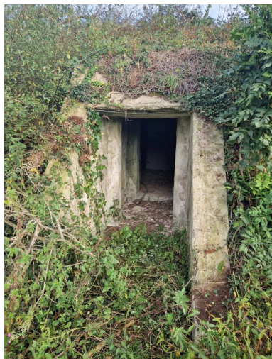
Vue de l'entrée située au sud : elle est protégée par deux murs latéraux obliques Phot. Guillaume Lécueillier IVR53_20232205392NUCA
