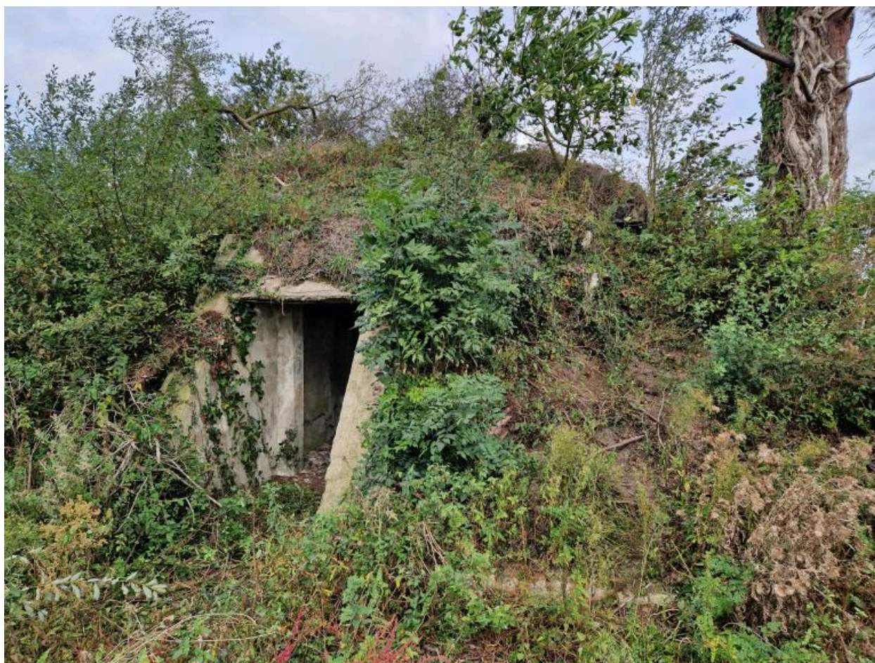
Vue de l'entrée située au sud
