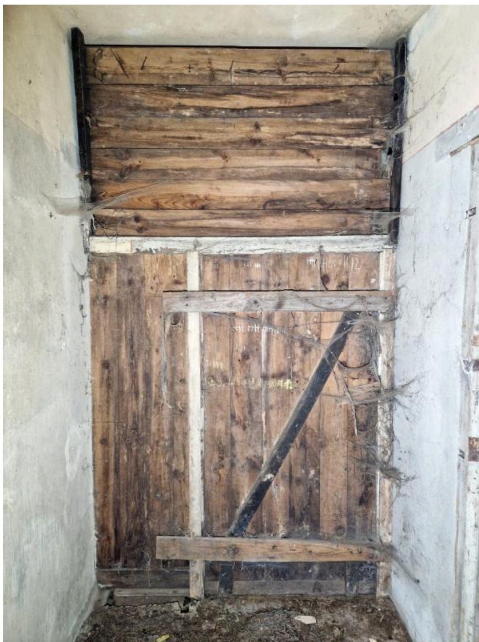
Vue de la porte en bois du couloir est depuis l'intérieur
