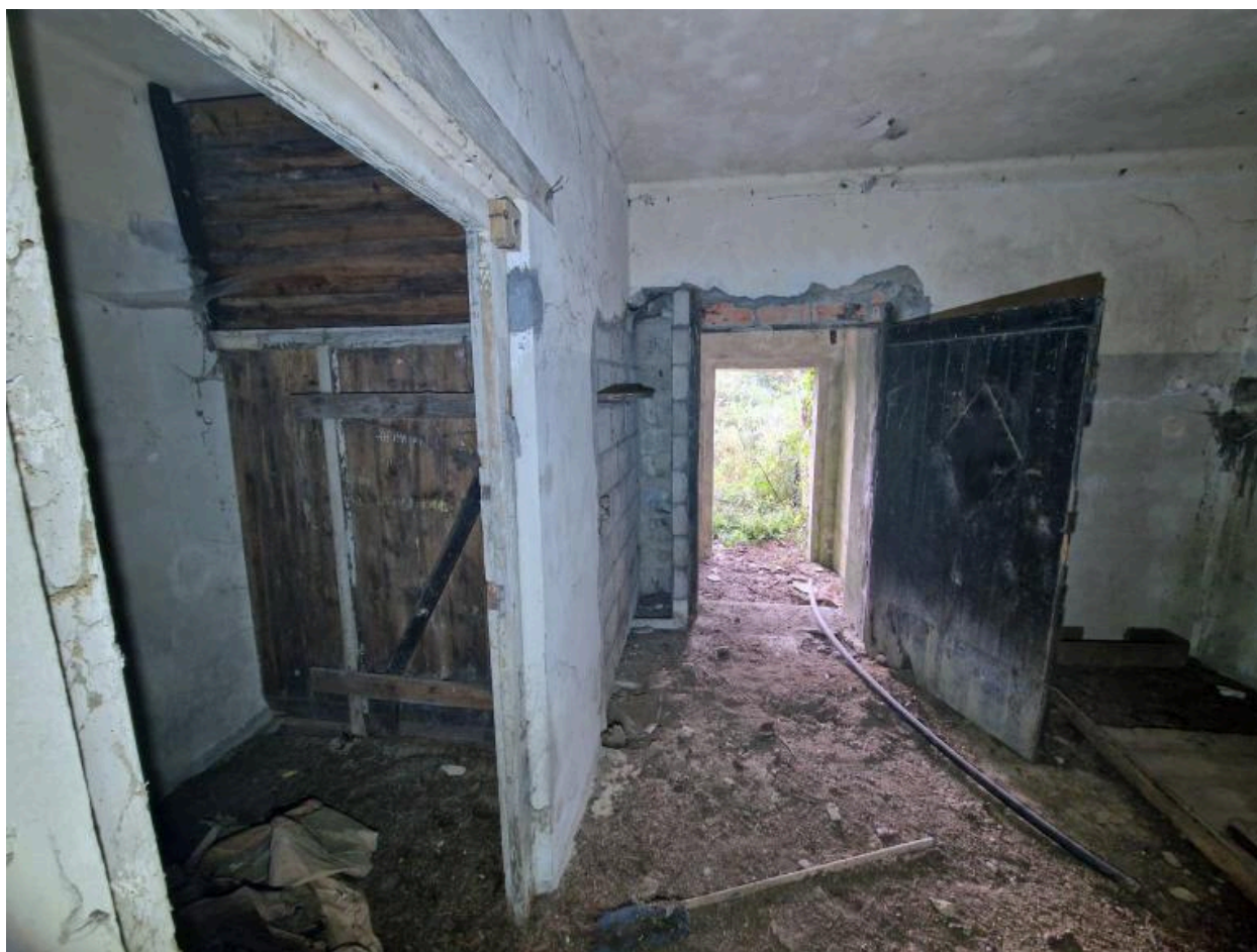
Vue de la communication avec le couloir est. Au fond, l'entrée de la pièce ouest avec sa porte
