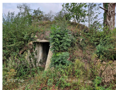
Vue de l'entrée située au sud Phot. Guillaume Lécueillier
