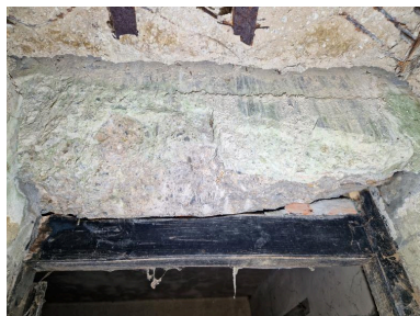
Vue du linteau en béton armé de la porte ouest depuis le vestibule Phot. Guillaume Lécueillier IVR53_20232205416NUCA
