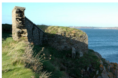
Vue du mur défensif Est et du parapet de la batterie basse Phot. Guillaume Lécueillier IVR53_20042904157NUCA
