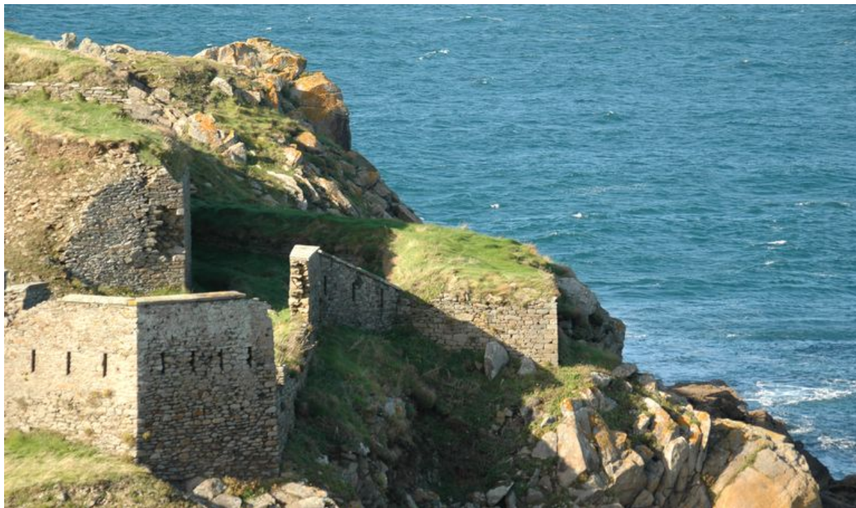
Vue du mur défensif à l'Est (en partie effondré)
