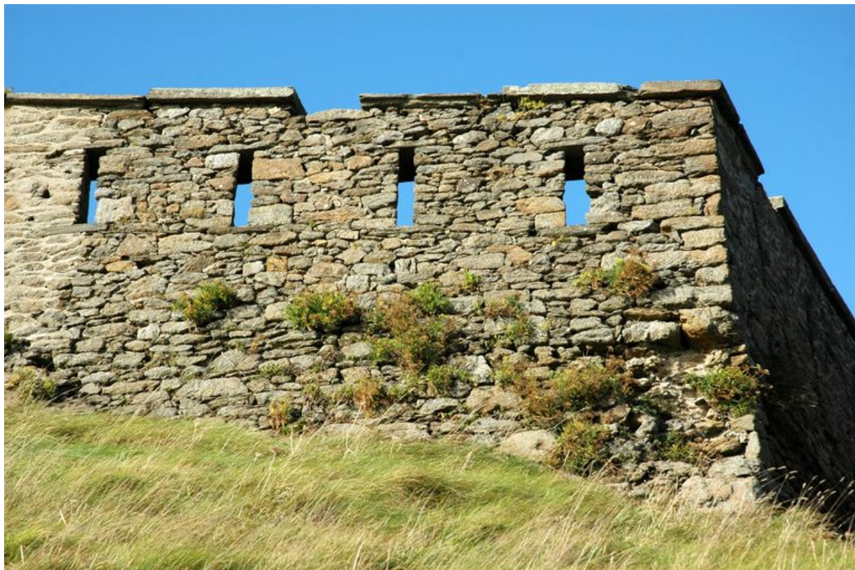
Elévation Sud : détail des créneaux de fusillade
