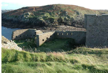
L'entrée est encadrée par un mur défensif percé de créneau de fusillade. Noter la lézarde à l'angle Nord-est de réduit Phot. Guillaume Lécueillier IVR53_20042904151NUCA
