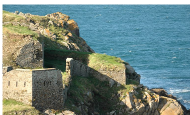
Vue du mur défensif à l'Est (en partie effondré) Phot. Guillaume Lécueillier IVR53_20042904130NUCA
