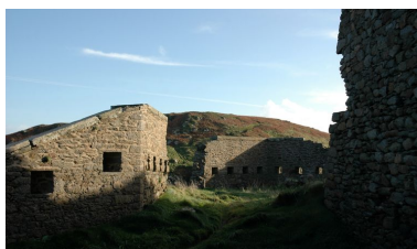
Vue du mur défensif depuis la batterie basse Phot. Guillaume Lécueillier IVR53_20042904158NUCA
