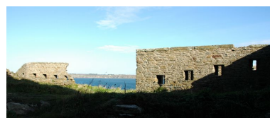
Vue du mur défensif à l'Est (en partie effondré) Phot. Guillaume Lécueillier IVR53_20042904163NUCA
