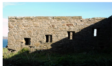
Créneaux de fusillade flanquant l'entrée Phot. Guillaume Lécueillier IVR53_20042904164NUCA
