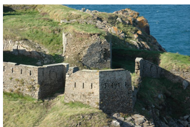
Vue de l'entrée et du mur défensif Est (en partie effondré) Phot. Guillaume Lécueillier IVR53_20042904129NUCA
