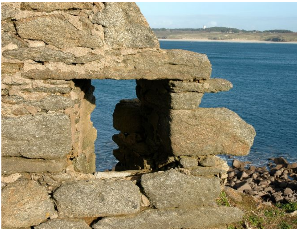
Détail d'un créneau de fusillade. En arrière-plan : la plage des Blancs-Sablons
