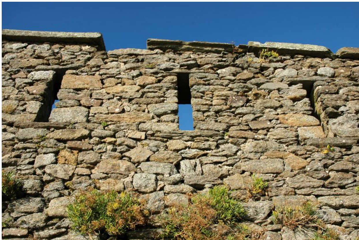
Elévation Sud : détail des créneaux de fusillade. Les pierres de faîtage sont essentielles au maintien de l'enceinte
