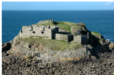
Vue générale de l'îlette de Kermorvan Phot. Guillaume Lécueillier IVR53_20042904125NUCA
