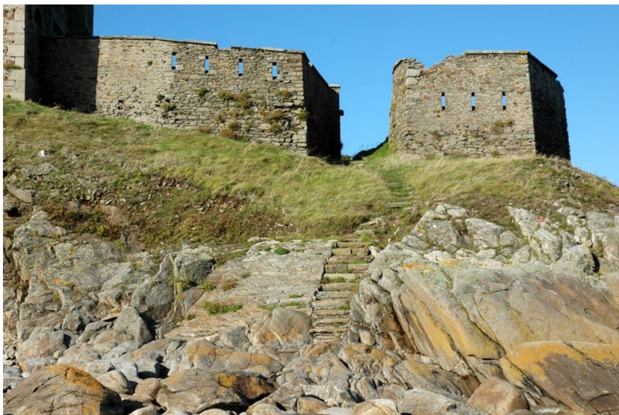
Vue générale de l'entrée. Le mur défensif est percé de créneau de fusillade
