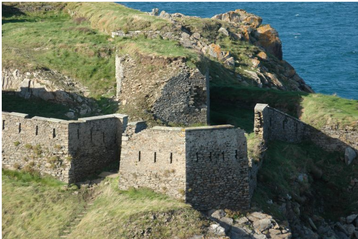
Vue de l'entrée et du mur défensif Est (en partie effondré)
