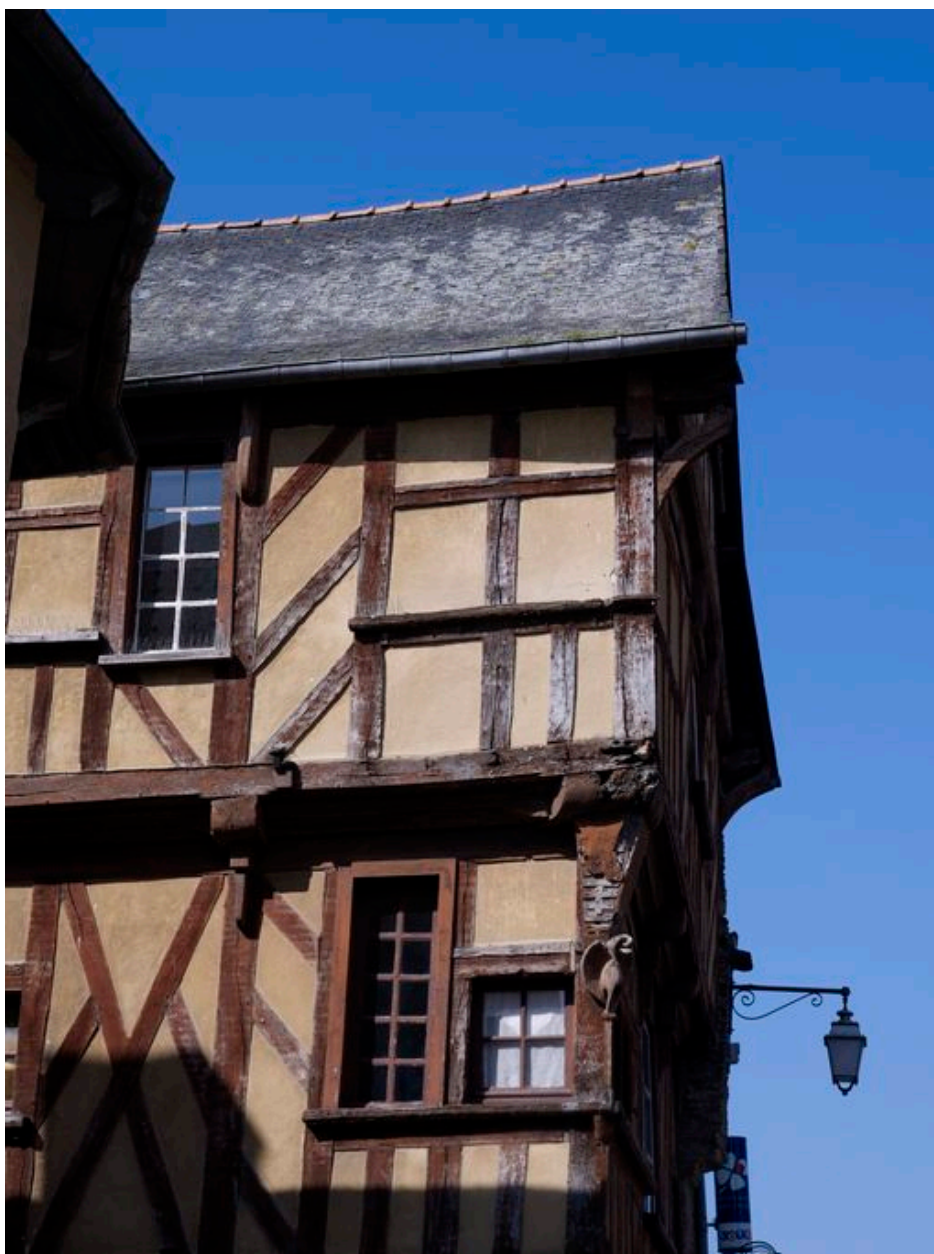
Maison : élévation sur la place, 2e et 3e niveaux (état en 2011)
