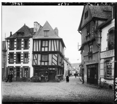
Maison (à droite) : élévation ouest (état en 1936) Phot. Henri Deneux IVR53_20155606018NUCB
