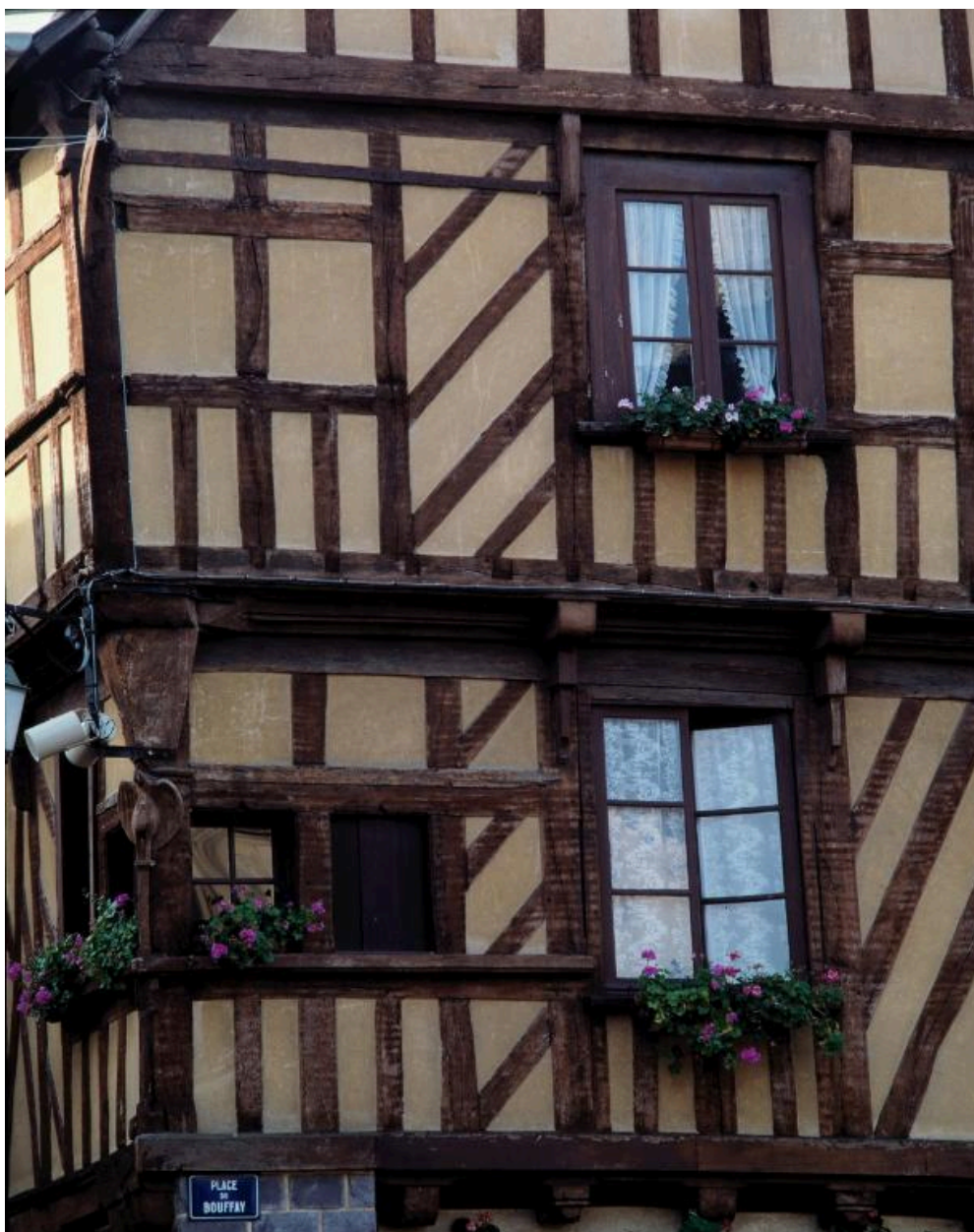
Maison : élévation sur la place, 2e et 3e niveaux (état en 1988)
