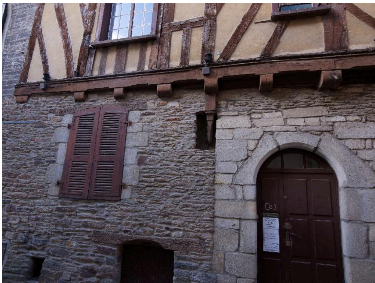
Maison, élévation sur la rue Sainte-Anne, 1er niveau : porte et partie inférieure du pan-de-bois (état en 1988)
