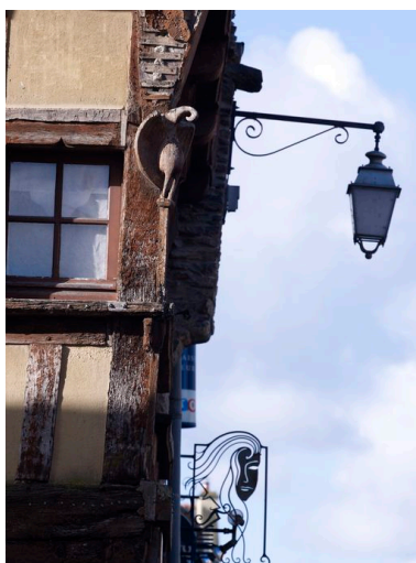
Maison : élévation sur la rue Sainte-Anne, 2e niveau : le pélican (état en 2012) Phot. Bernard Bègne IVR53_20125601259NUCA
