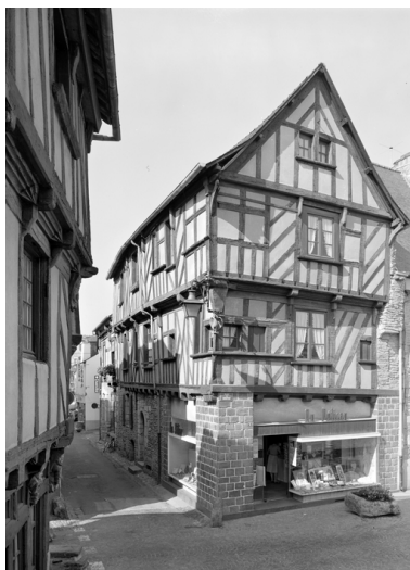
Maison : vue générale prise du nord-ouest (état en 1984) Phot. Guy Artur, Phot. Norbert Lambart IVR53_19845600867V
