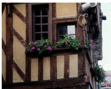
Maison : élévation sur la rue Sainte-Anne, 2e niveau : les fenêtres d'angle et le pélican (état en 1988) Phot. Norbert Lambart IVR53_19885600751XA
