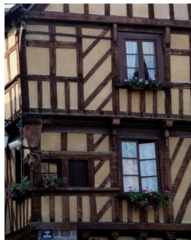
Maison : élévation sur la place, 2e et 3e niveaux (état en 1988) Phot. Norbert Lambart IVR53_19885600768XA
