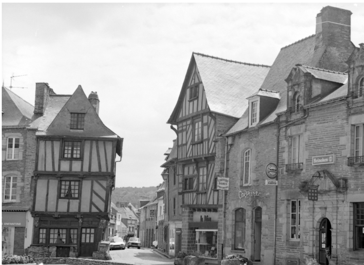
Maison (au centre de la photo) : vue générale prise du sud-est (état en 1984)
