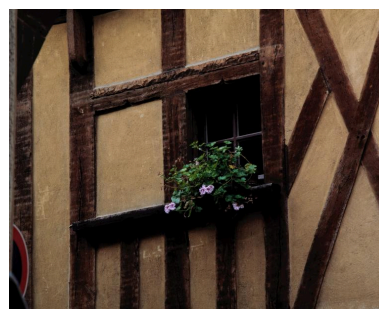
Maison, élévation sur la rue Sainte-Anne, 2e niveau : une fenêtre (état en 1988) Phot. Norbert Lambart IVR53_19885600752XA
