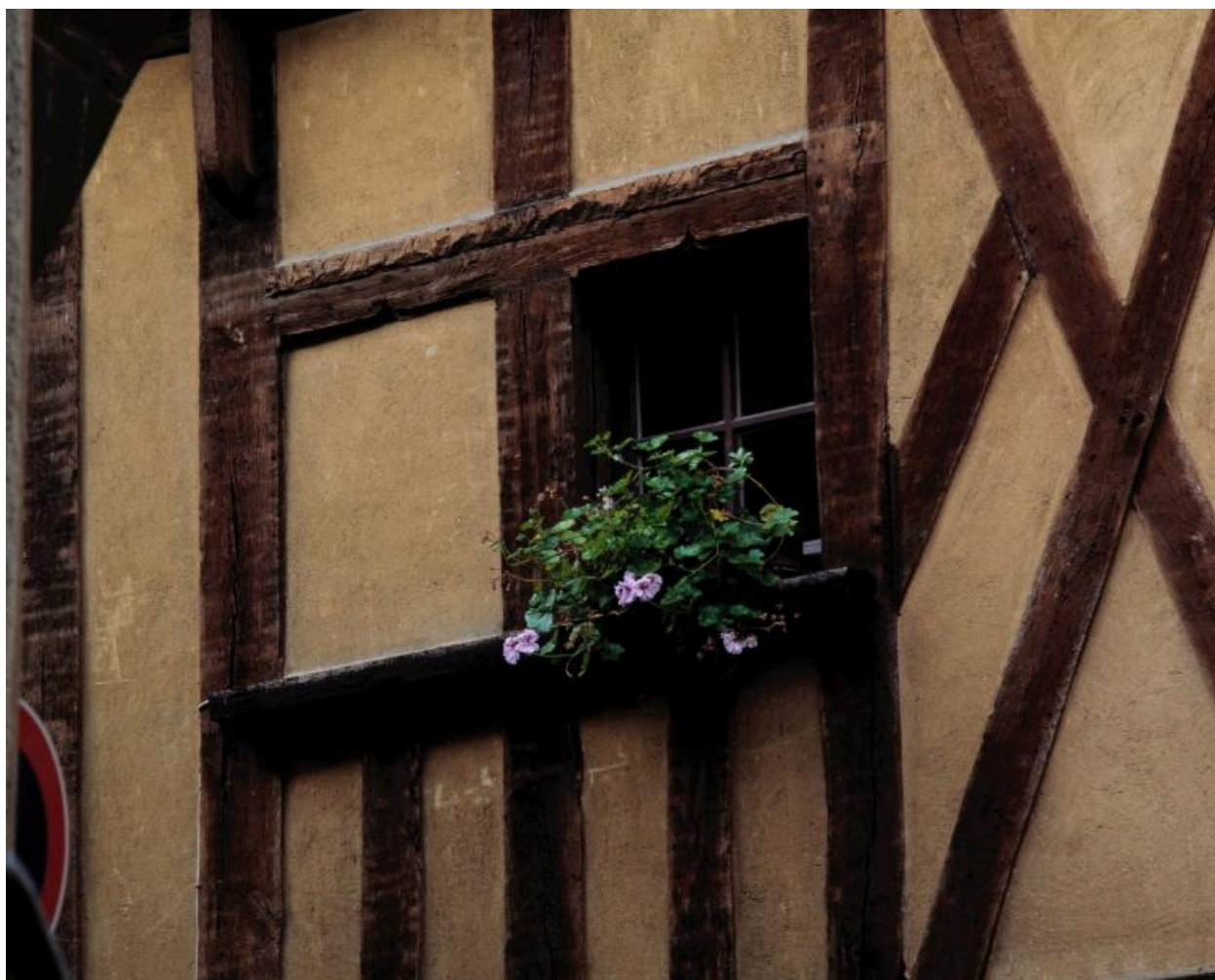
Maison, élévation sur la rue Sainte-Anne, 2e niveau : une fenêtre (état en 1988)
