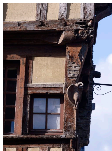
Maison : élévation sur la place, 2e niveau : le pélican (état en 2012) Phot. Bernard Bègne IVR53_20125601260NUCA
