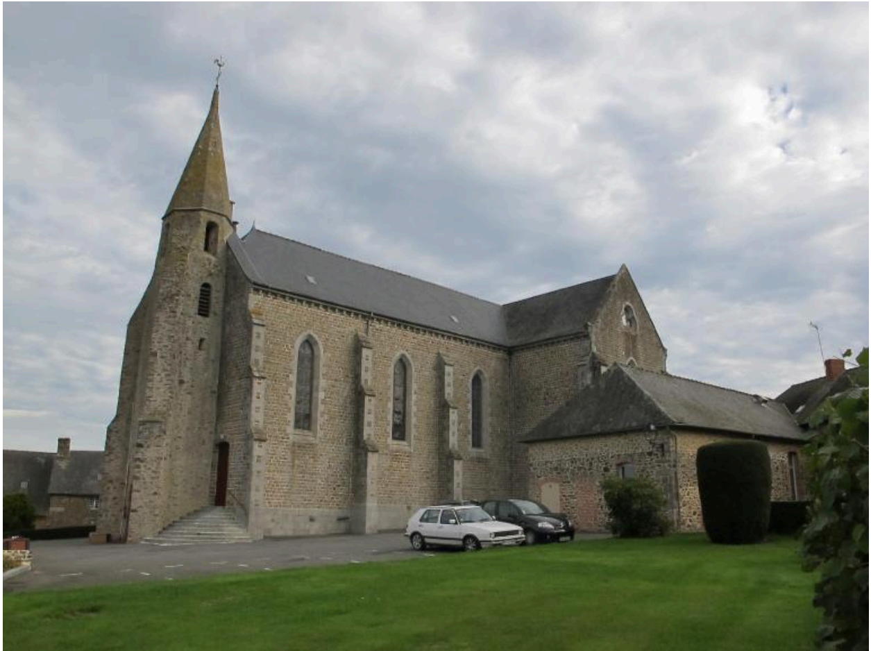
Vue générale : côté sud-ouest
