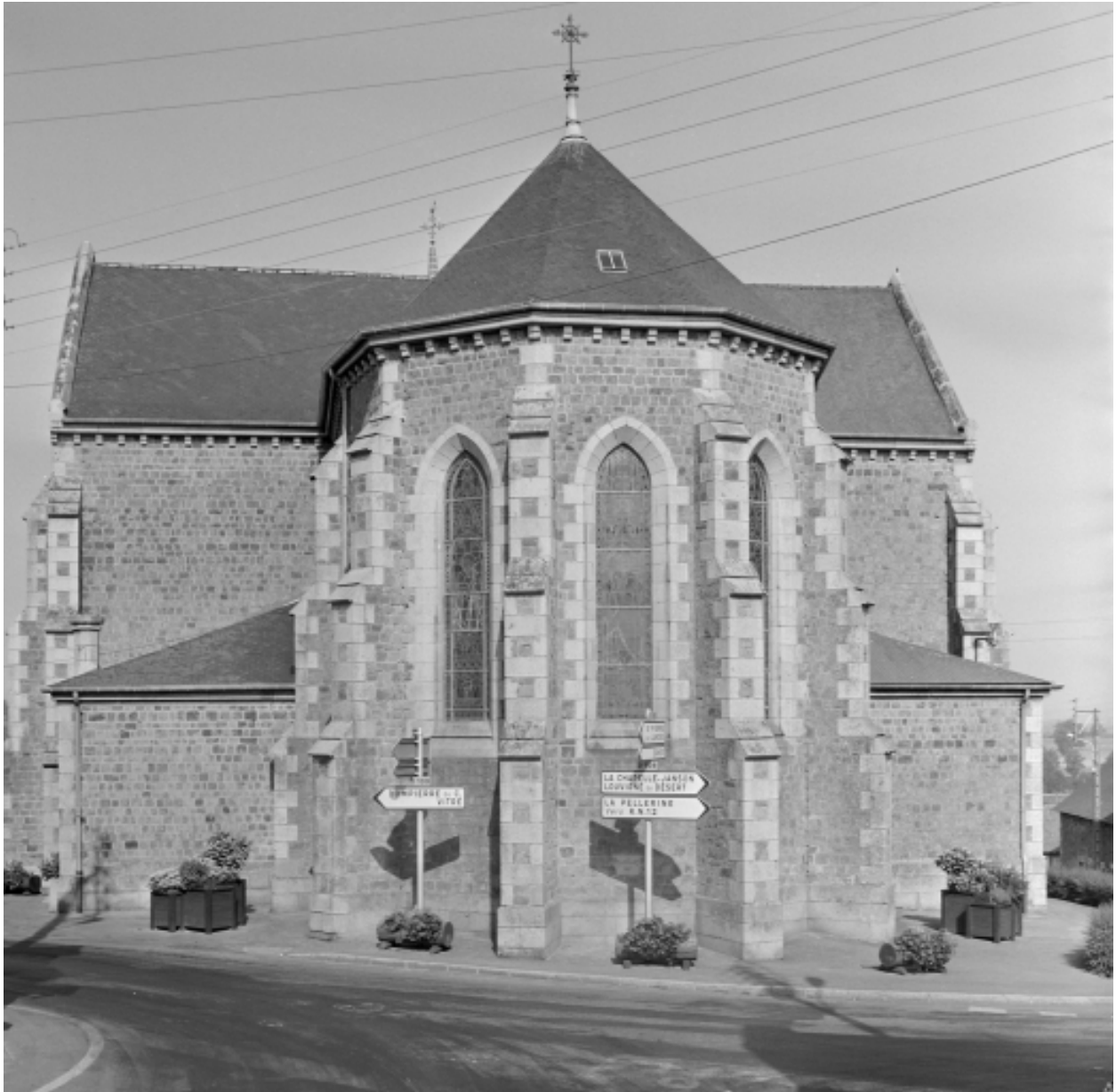
Elévation Est : vue générale
