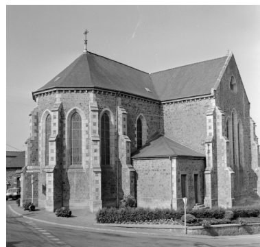
Elévation Nord-Est : vue générale
