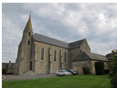
Vue générale : côté sud-ouest
