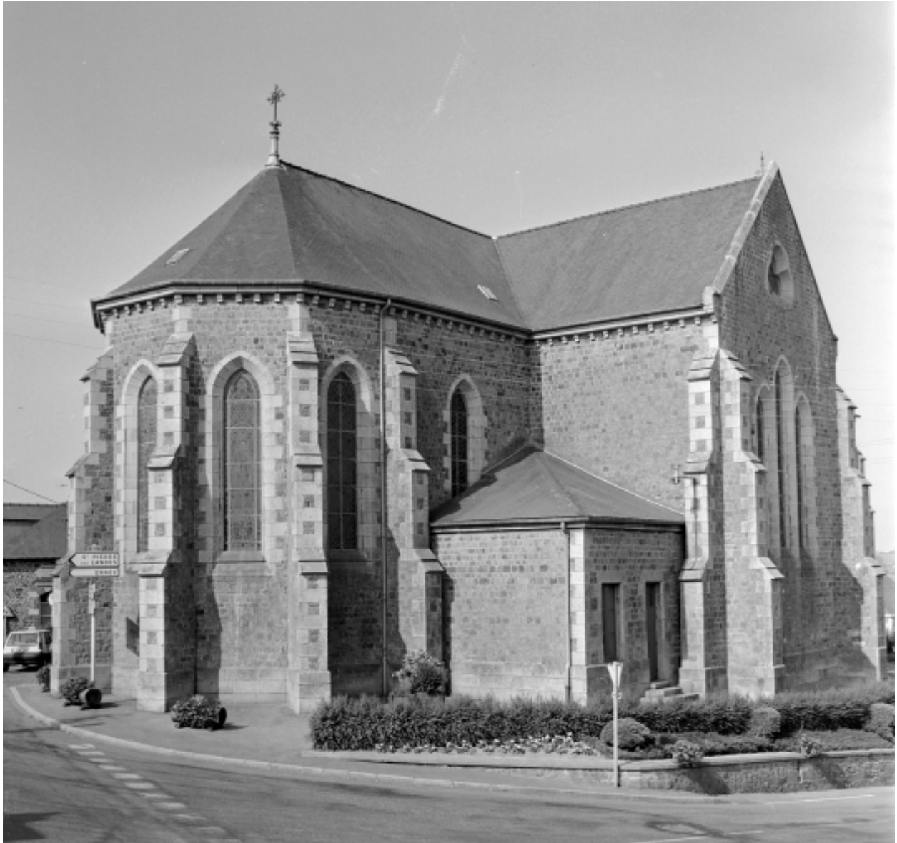
Elévation Nord-Est : vue générale
