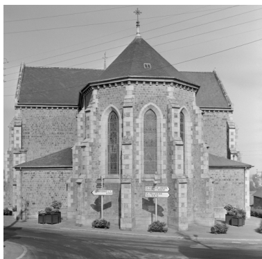
Elévation Est : vue générale
