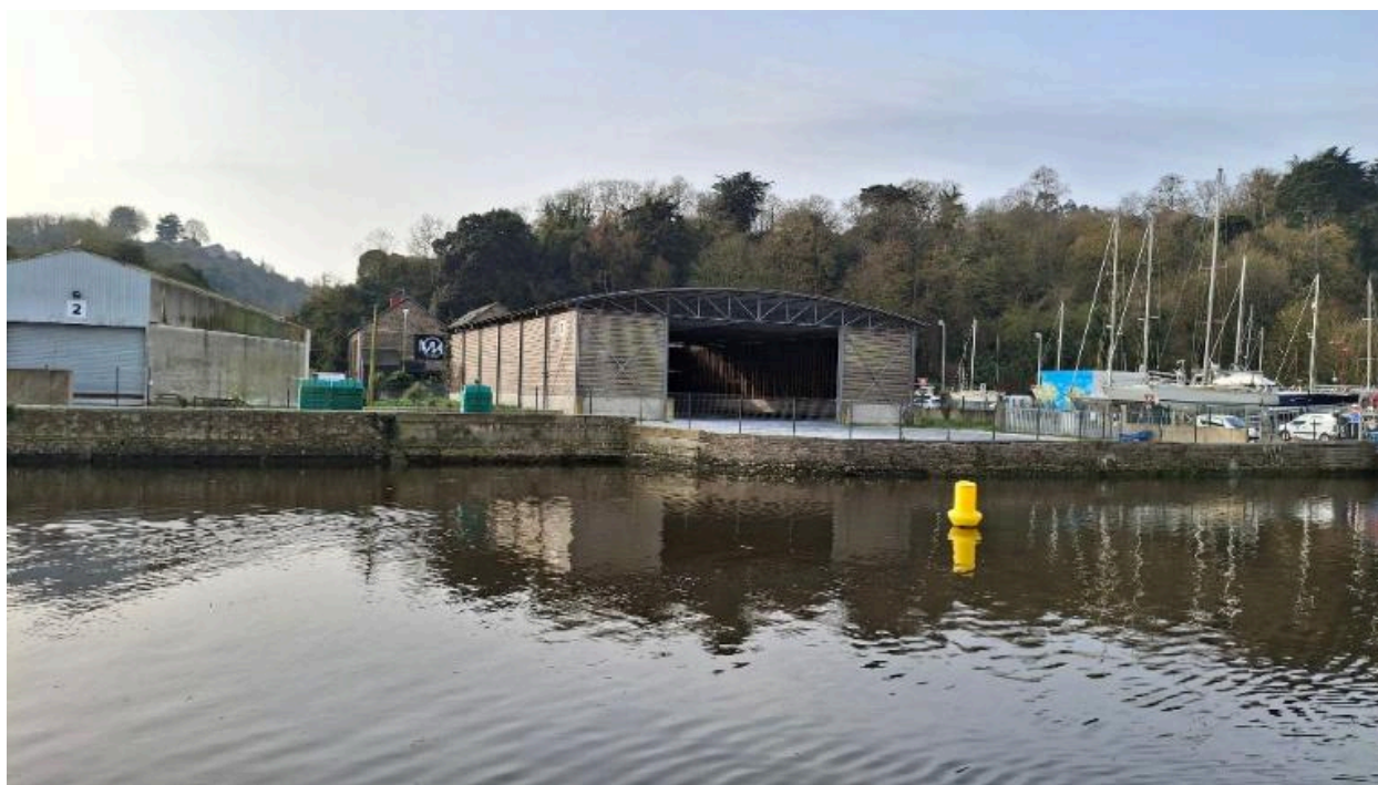
Pont du Gouëdic à proximité du pont tournant
