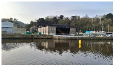
Pont du Gouëdic à proximité du pont tournant Phot. Erwana L'Haridon IVR53_20262210088NUCA
