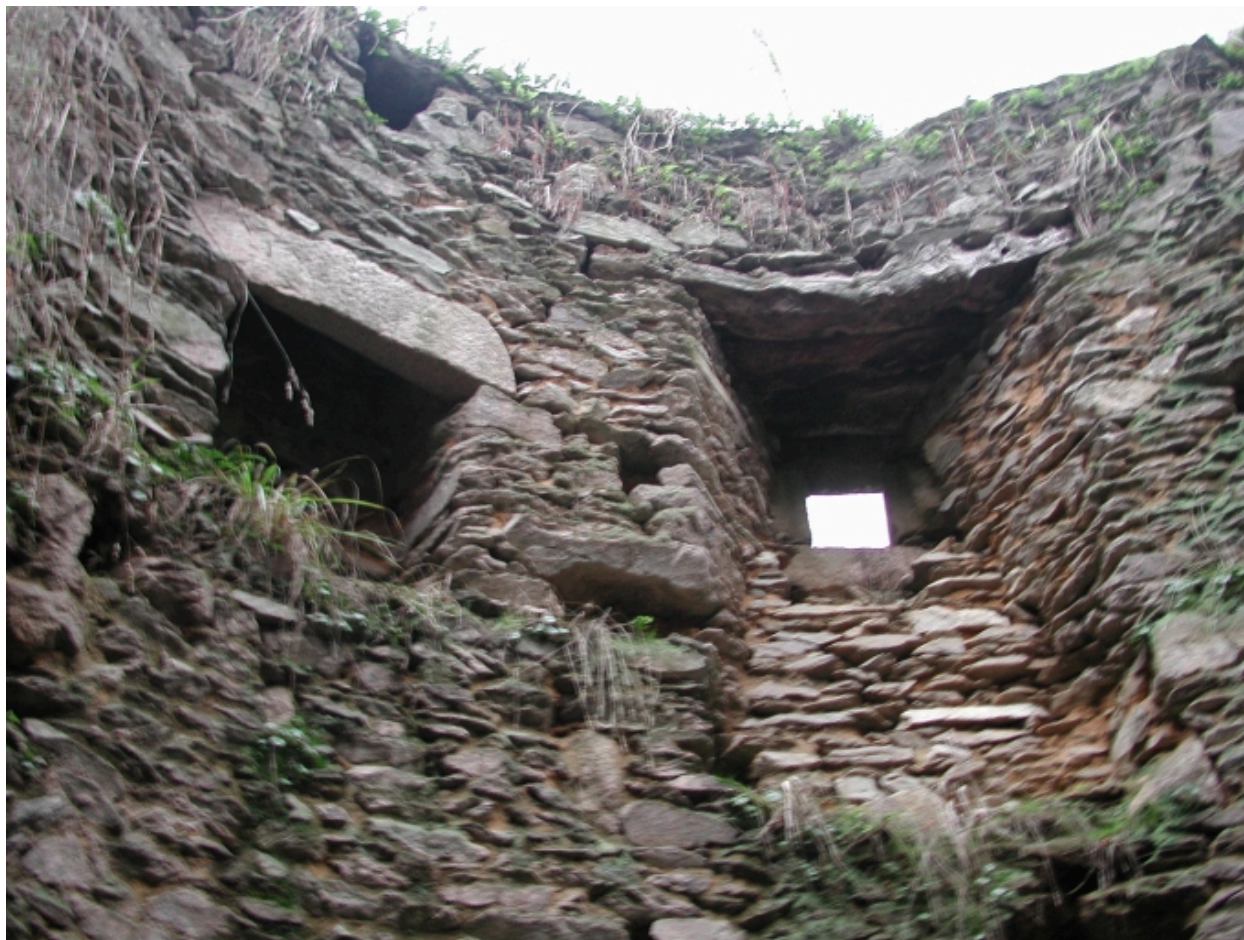
Vue des ouvertures supérieures sous le couronnement supportant la charpente détruite
