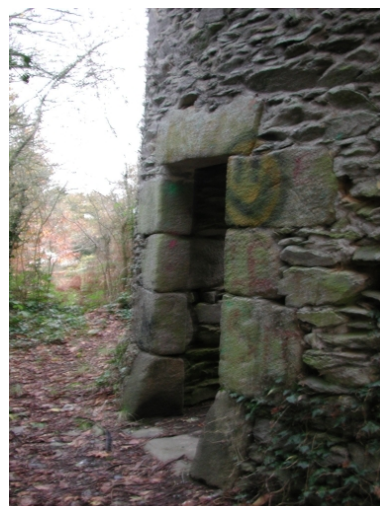
Vue de l'une des portes avec l'encadrement en pierres de taille
