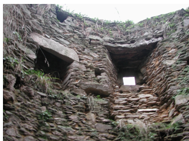
Vue des ouvertures supérieures sous le couronnement
