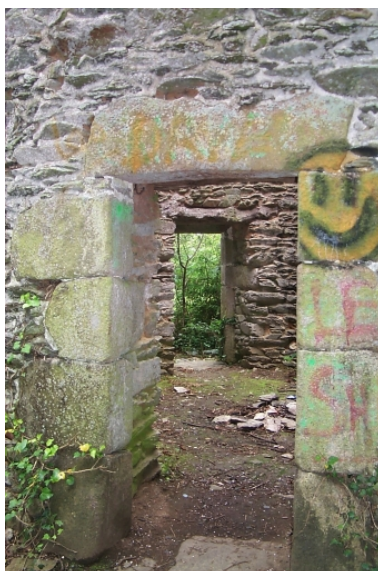
Vue des portes en vis-à-vis
