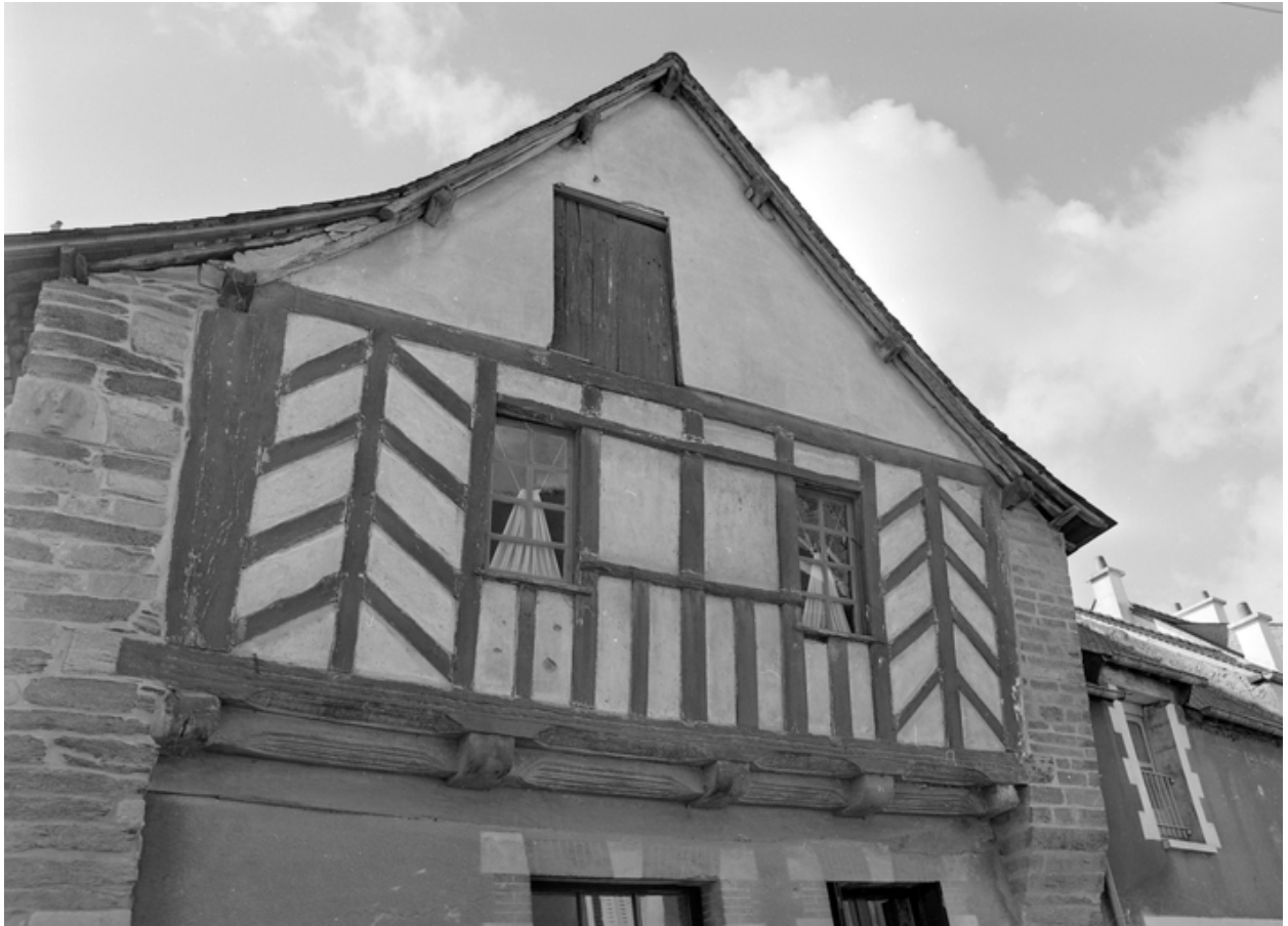
Maison 16 rue aux Roux, élévation nord : détail du pan de bois en encorbellement.
