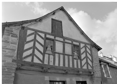
Maison 16 rue aux Roux, élévation nord : détail du pan de bois en encorbellement. Phot. Auteur inconnu IVR53_19775601008X
