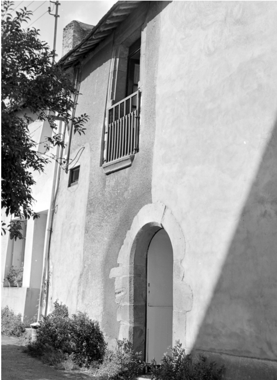
Maison 16 rue aux Roux, élévation est.
