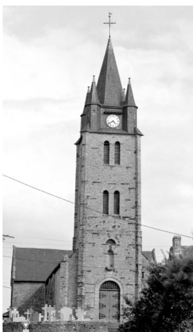
Elévation ouest, vue générale. Phot. Guy Artur, Phot. Norbert Lambart
