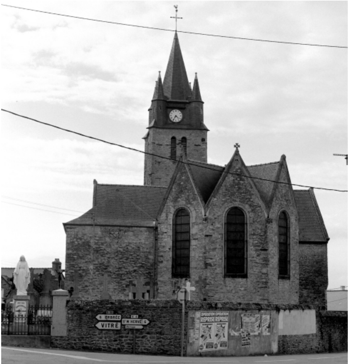
Elévation est, vue générale.
