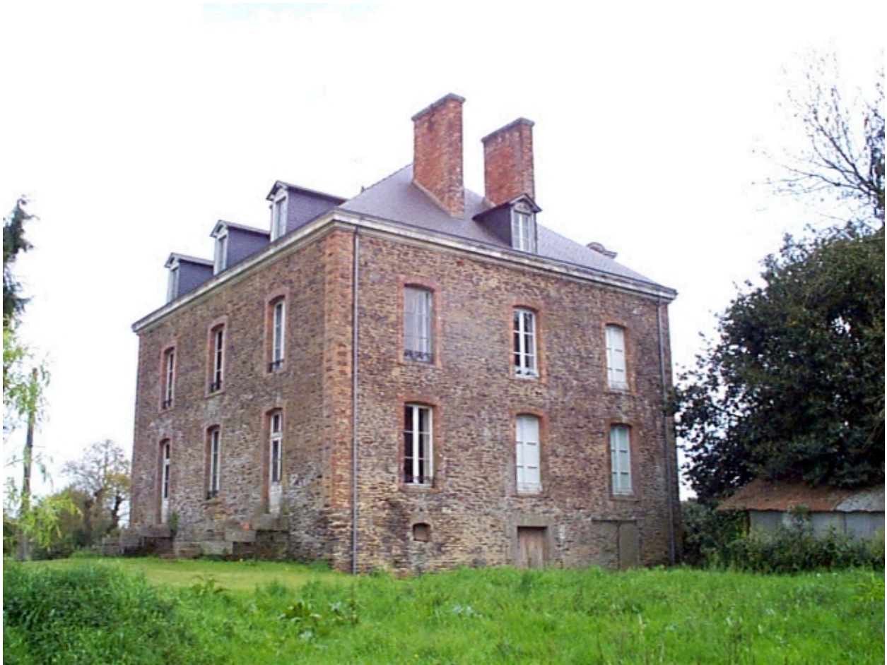
Pignon ouest : vue générale
