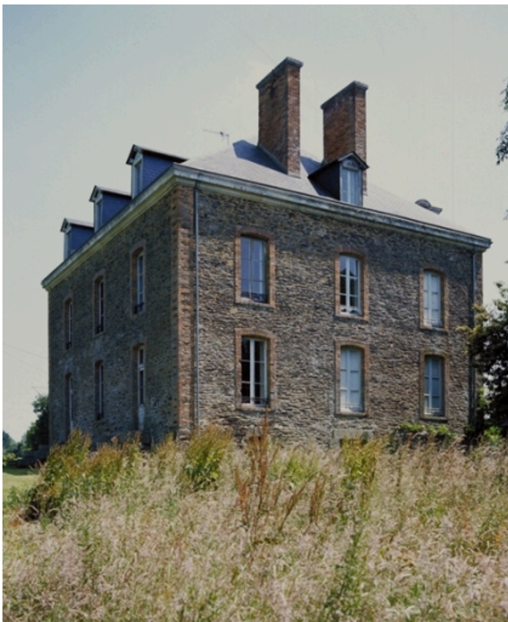
Pignon ouest : vue générale
