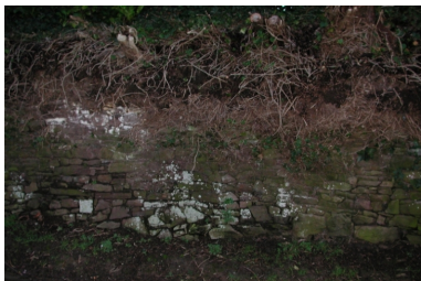
mur de soutènement Phot. Guy Prigent IVR53_20022215948NUCA
