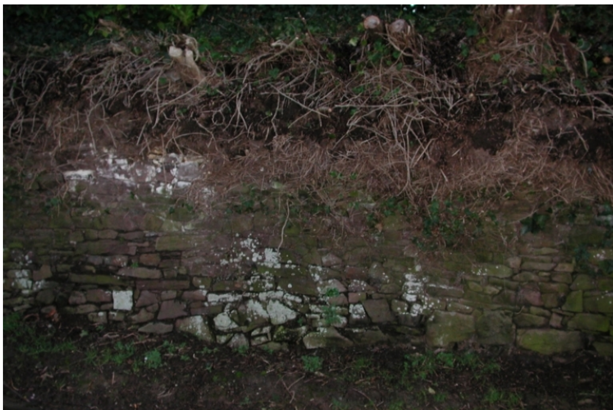
mur de soutènement
