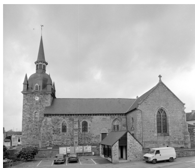
Elévation Sud : vue générale Phot. Guy Artur, Phot. Norbert Lambart IVR53_19943500695X
