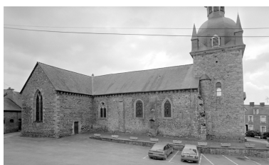
Elévation Nord : vue générale Phot. Guy Artur, Phot. Norbert Lambart IVR53_19943500693X
