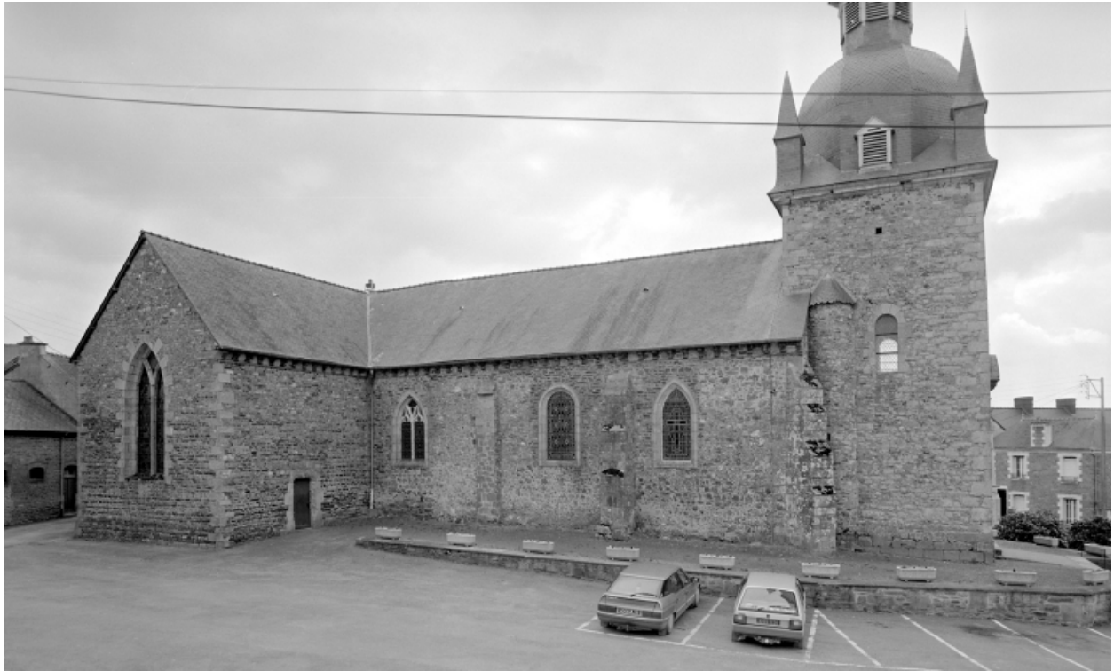
Elévation Nord : vue générale
