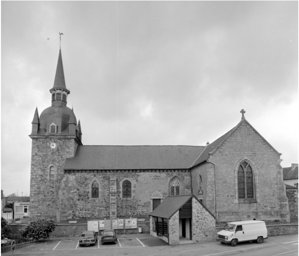
Elévation Sud : vue générale
