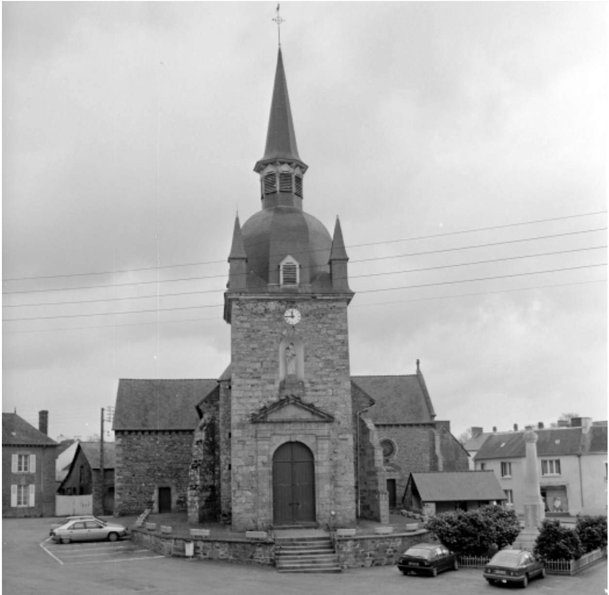
Elévation Ouest : vue générale
