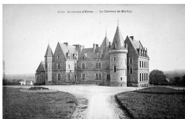
Vue générale des élévations sur cour Phot. Elise Lauranceau IVR53_20045606296NUCB
