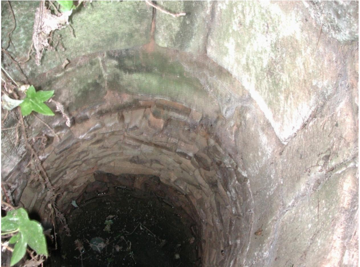
Vue de l'intérieur du puits : remarquer la maçonnerie en schiste vers le fond du puits
