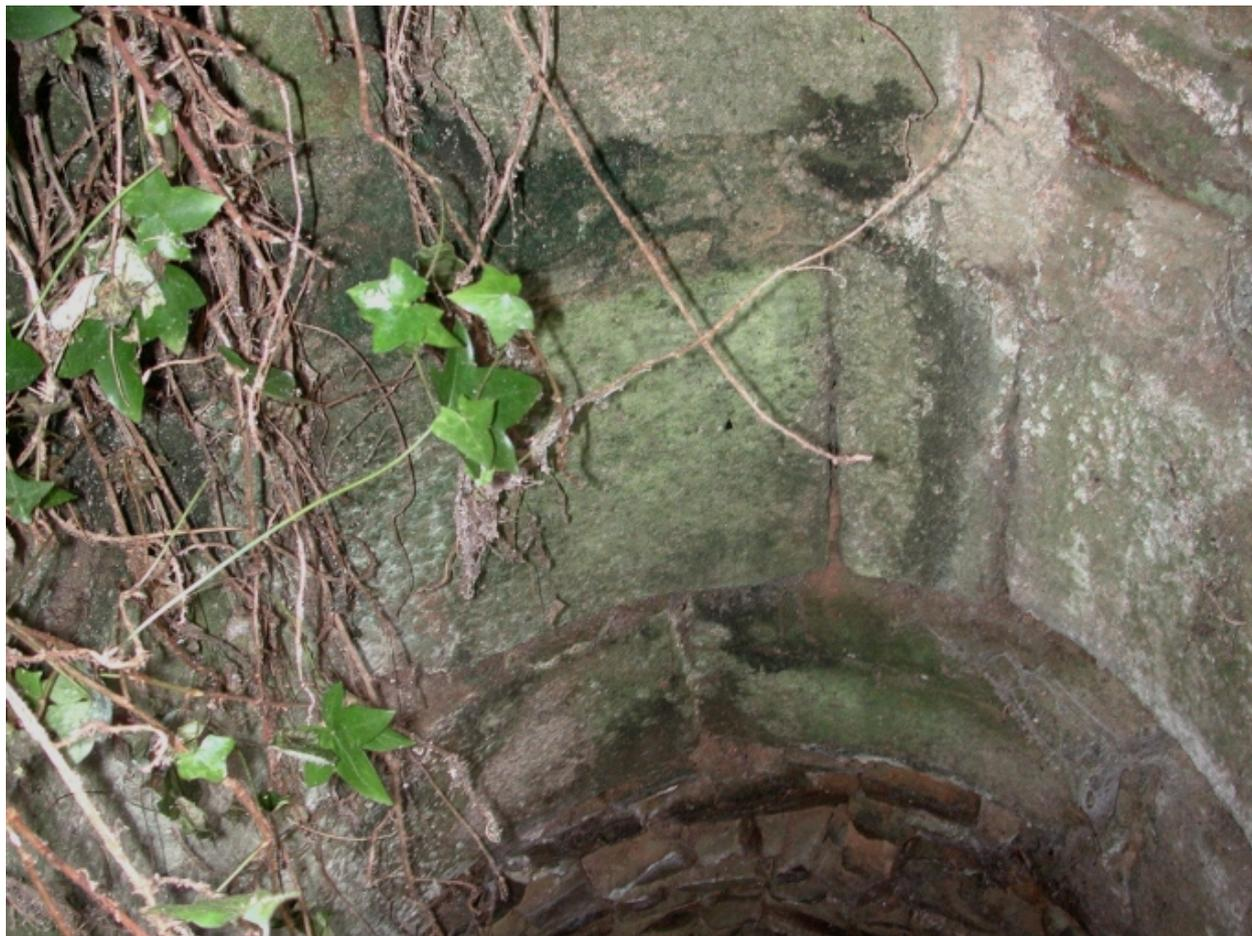
Vue de l'intérieur du puits : remarquer la maçonnerie en pierre de taille vers la surface
