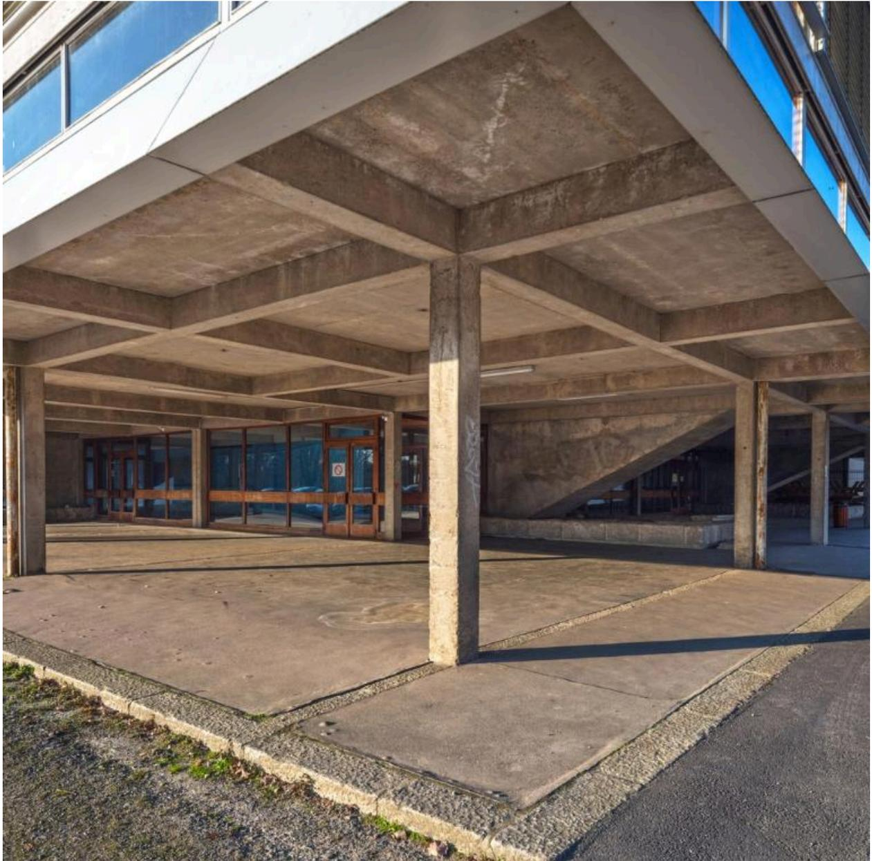
Réfectoire, rez-de-chaussée bas : préau et structure poteaux - poutres en béton.
