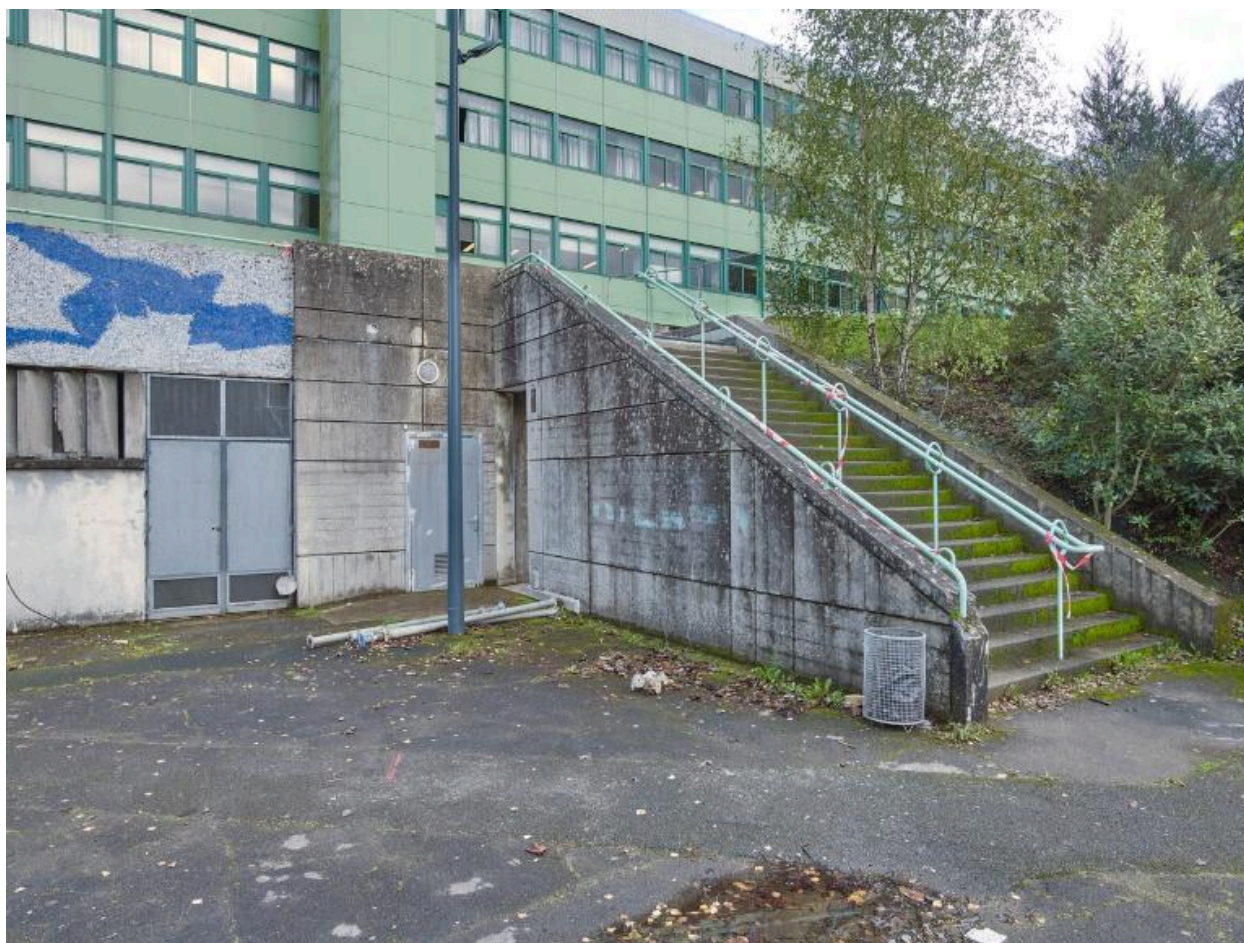
Escalier d'accès à la cours située en rez-de-chaussée haut, façade ouest du bâtiment A (externat, administration, logements). André Remondet et Patrice Simon, architectes, 1961.
