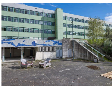
Bâtiment A (externat, administration, logements), façade ouest. André Remondet et Patrice Simon, architectes, 1961. Noter la décoration de Gustave Singier (1962).
