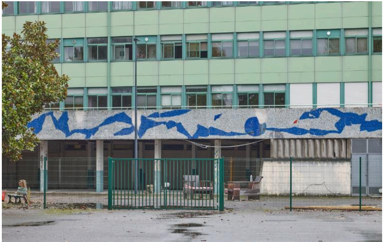
Bâtiment A (externat, administration, logements), détail de la façade ouest. André Remondet et Patrice Simon, architectes, 1961. Noter la mosaïque de Gustave Singier (1962), sur le garde-corps de la cours au rez-de-chaussée haut.
