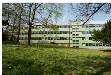
Vue partielle de la façade est du bâtiment A. Noter l'adaptation à la déclivité du terrain, avec un étage supplémentaire au nord. (André Remondet et Patrice Simon, architectes, 1961). Phot. Charlotte Barraud IVR53_20212200134NUCA
