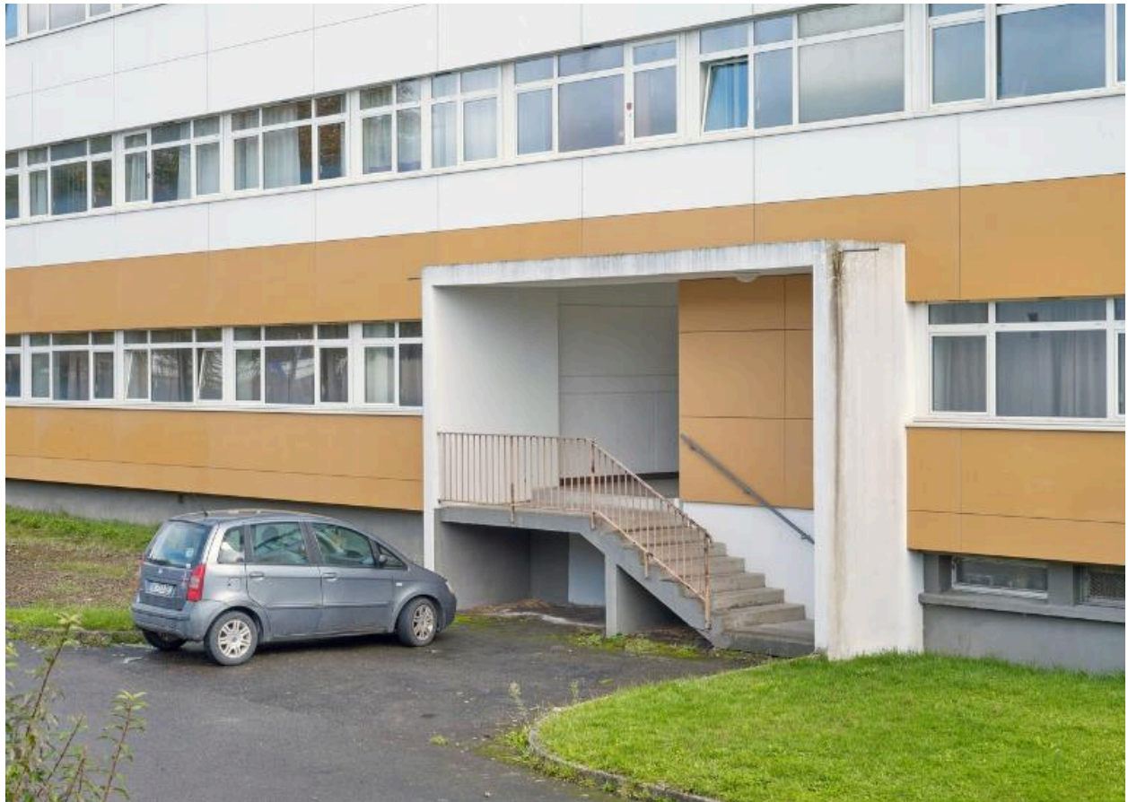
Bâtiment B (internat, logements, classes), détail sur un entrée de la façade sud. André Remondet et Patrice Simon, architectes, 1966.
