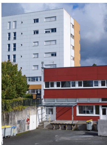
Bâtiment B (internat, logements, classes) et, au premier plan, bâtiment C (restauration, infirmerie, foyer), façades ouest, détails. André Remondet et Patrice Simon, architectes, 1966. Phot. Bernard Bègne IVR53_20202200570NUCA
