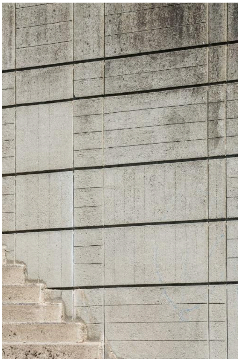
Escalier extérieur et mur de soutènement de la cour située en rez-de-chaussée haut. Noter le décor issu d'un calepinage soigné du béton. (André Remondet et Patrice Simon, architectes, 1961).
