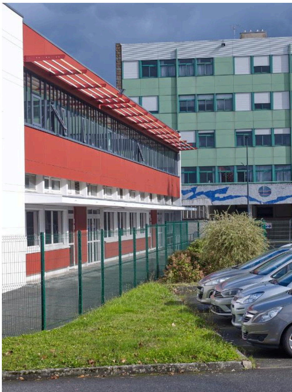
Bâtiment C (restauration, infirmerie, foyer), façade sud et Bâtiment A (externat, administration, logements), façade ouest. André Remondet et Patrice Simon, architectes, 1966 et 1961. Noter la décoration réalisée par Gustave Singier.
