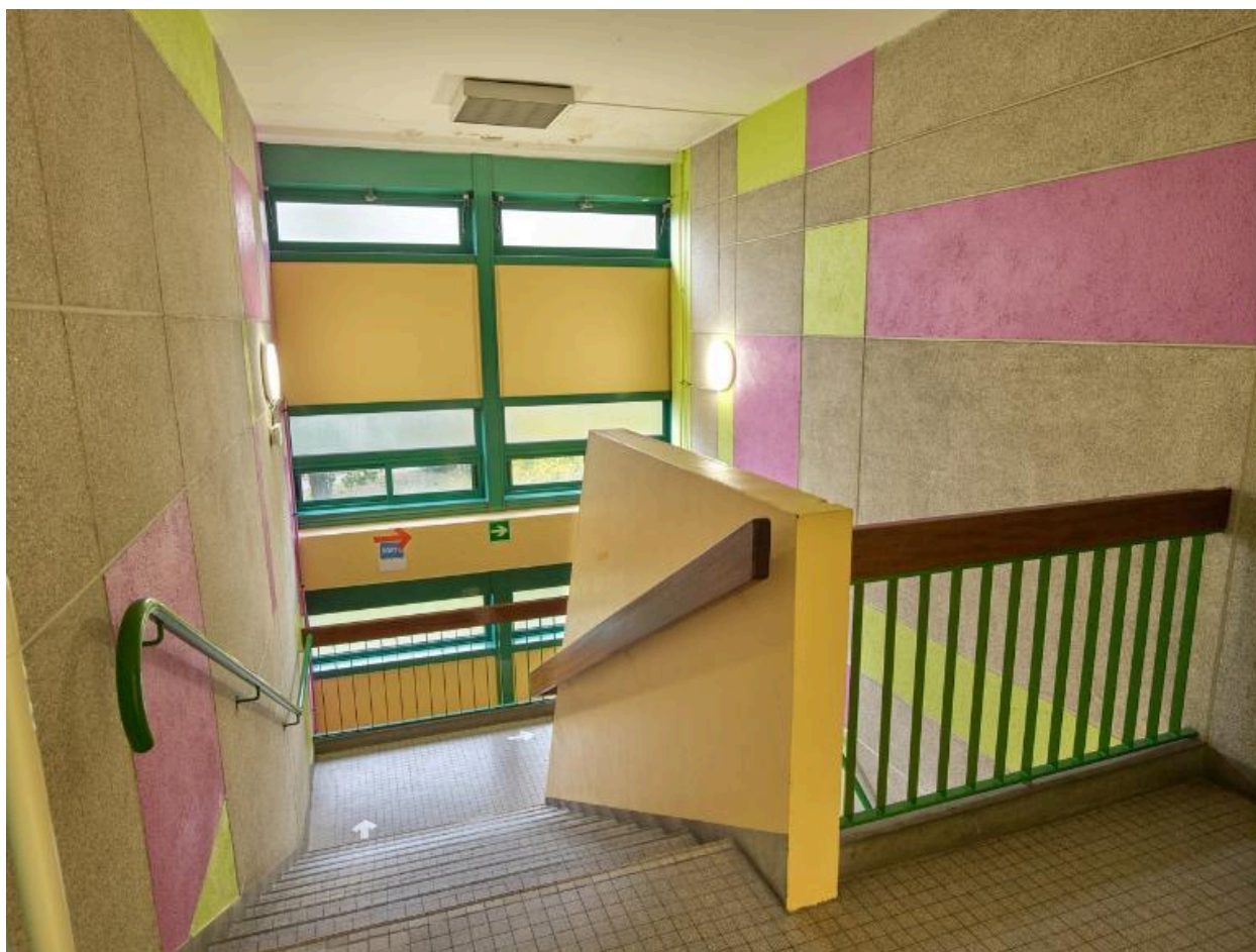
Cage d'escalier, bâtiment A. La modénature des murs, dessinée par les architectes André Remondet et Patrice Simon, a été soulignée par des aplats peints ultérieurement. Noter également la qualité des larges rampes en bois.
