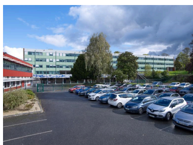
Bâtiment A (externat, administration, logements), façade ouest. André Remondet et Patrice Simon, architectes, 1961. A gauche, façade sud du bâtiment C. Noter la décoration de Gustave Singier (1962).
