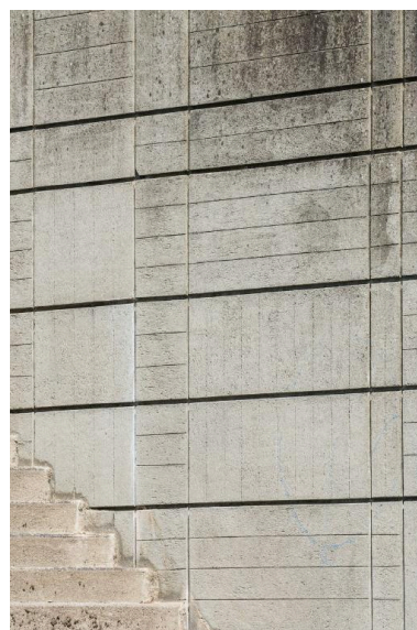
Escalier extérieur et mur de soutènement de la cour située en rez-de-chaussée haut. Noter le décor issu d'un calepinage soigné du béton. (André Remondet et Patrice Simon, architectes, 1961). Phot. Charlotte Barraud IVR53_20212200139NUCA
