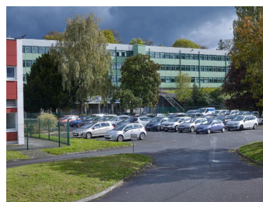
Bâtiment A (externat, administration, logements), façade ouest. André Remondet et Patrice Simon, architectes, 1961.
