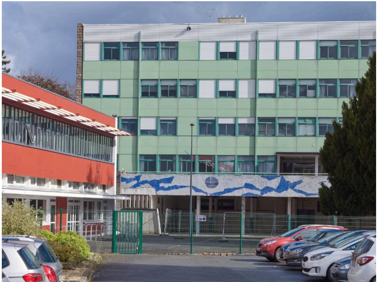
Bâtiment C (restauration, infirmerie, foyer), façade sud et Bâtiment A (externat, administration, logements), façade ouest. André Remondet et Patrice Simon, architectes, 1966 et 1961. Noter la décoration réalisée par Gustave Singier.
