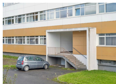
Bâtiment B (internat, logements, classes), détail sur un entrée de la façade sud. André Remondet et Patrice Simon, architectes, 1966. Phot. Bernard Bègne IVR53_20202200574NUCA
