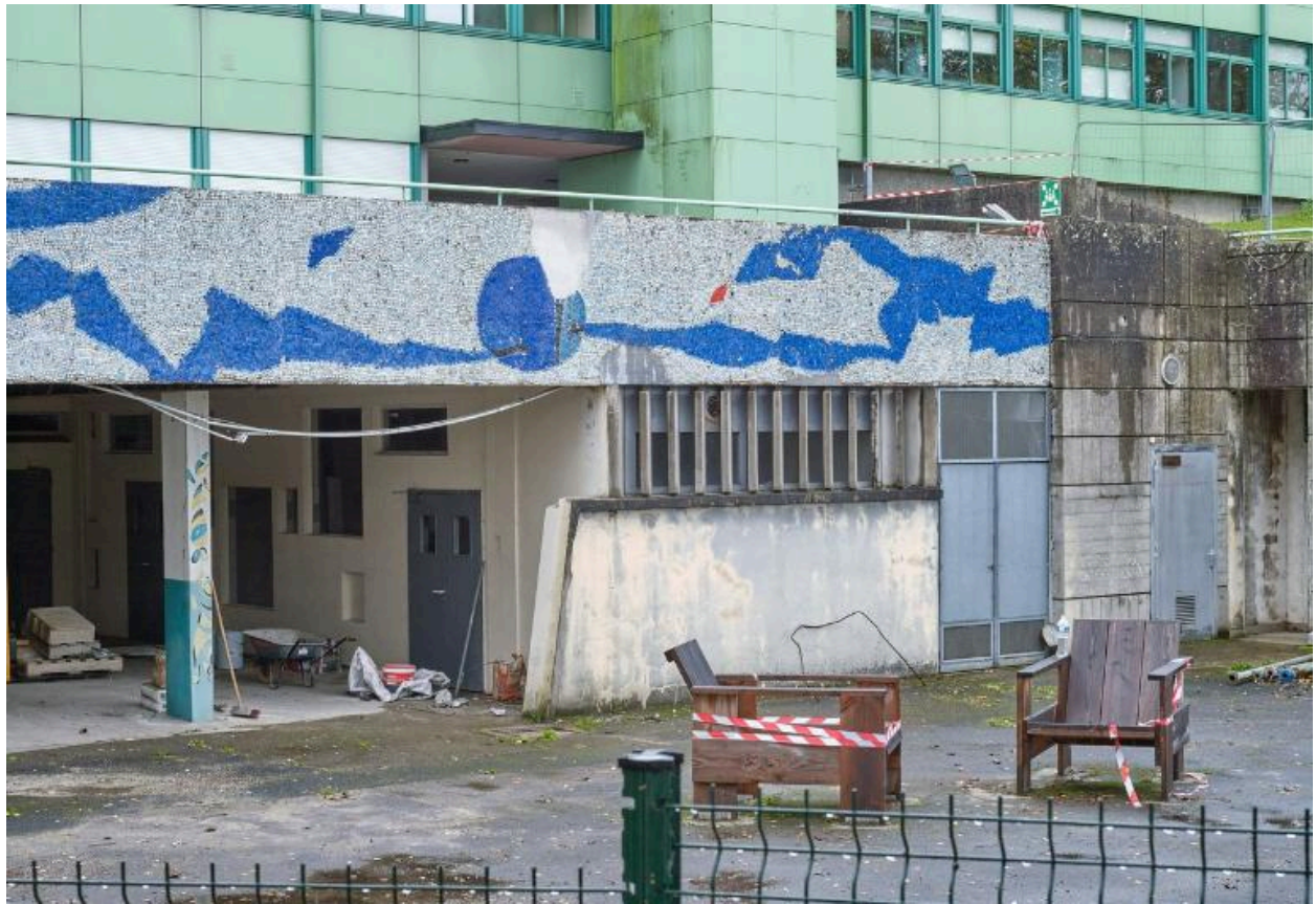
Bâtiment A (externat, administration, logements), détail de la façade ouest. André Remondet et Patrice Simon, architectes, 1961. Noter la mosaïque de Gustave Singier (1962), sur le garde-corps de la cours au rez-de-chaussée haut.
