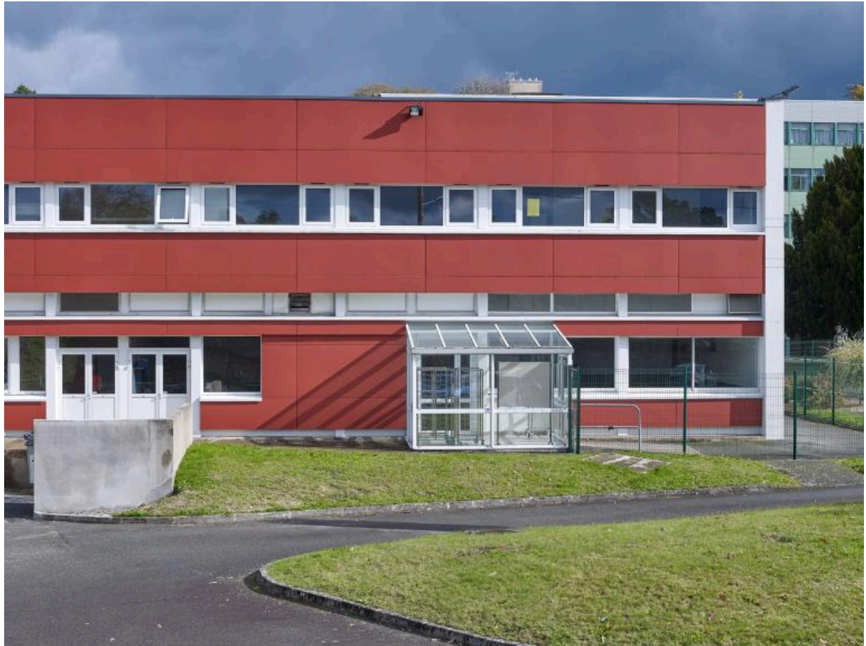
Bâtiment C (restauration, infirmerie, foyer), façade ouest. André Remondet et Patrice Simon, architectes, 1966.
