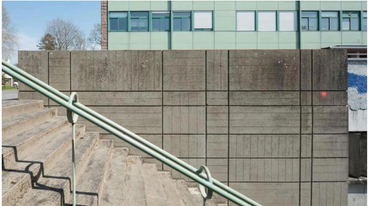
Escalier extérieur et mur de soutènement de la cour située en rez-de-chaussée haut. Noter le décor issu d'un calepinage soigné du béton. (André Remondet et Patrice Simon, architectes, 1961).
