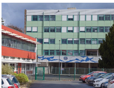
Bâtiment C (restauration, infirmerie, foyer), façade sud et Bâtiment A (externat, administration, logements), façade ouest. André Remondet et Patrice Simon, architectes, 1966 et 1961. Noter la décoration réalisée par Gustave Singier.
