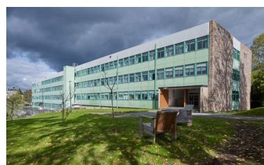
Bâtiment A (externat, administration, logements), façade ouest et pignon sud. André Remondet et Patrice Simon, architectes, 1961. Vue prise du sud-ouest, au niveau du rez-de-chaussée haut.
