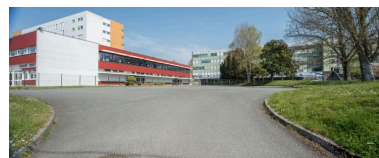
Vue d'ensemble prise du sud-ouest. Au premier plan, Bâtiment C (restauration, infirmerie, foyer) ; derrière celui-ci, bâtiment B (internat, logements, classes) ; et, à droite, bâtiment A (externat, administration et logements). André Remondet et Patrice Simon, architectes, 1963-1966. Phot. Charlotte Barraud IVR53_20212200142NUCA
