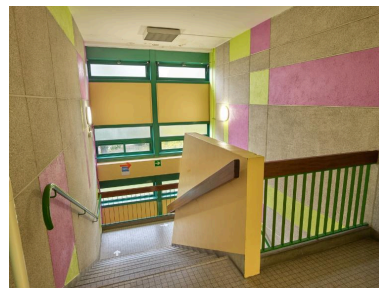
Cage d'escalier, bâtiment A. La modénature des murs, dessinée par les architectes André Remondet et Patrice Simon, a été soulignée par des aplats peints ultérieurement. Noter également la qualité des larges rampes en bois. Phot. Bernard Bègne IVR53_20202200609NUCA
