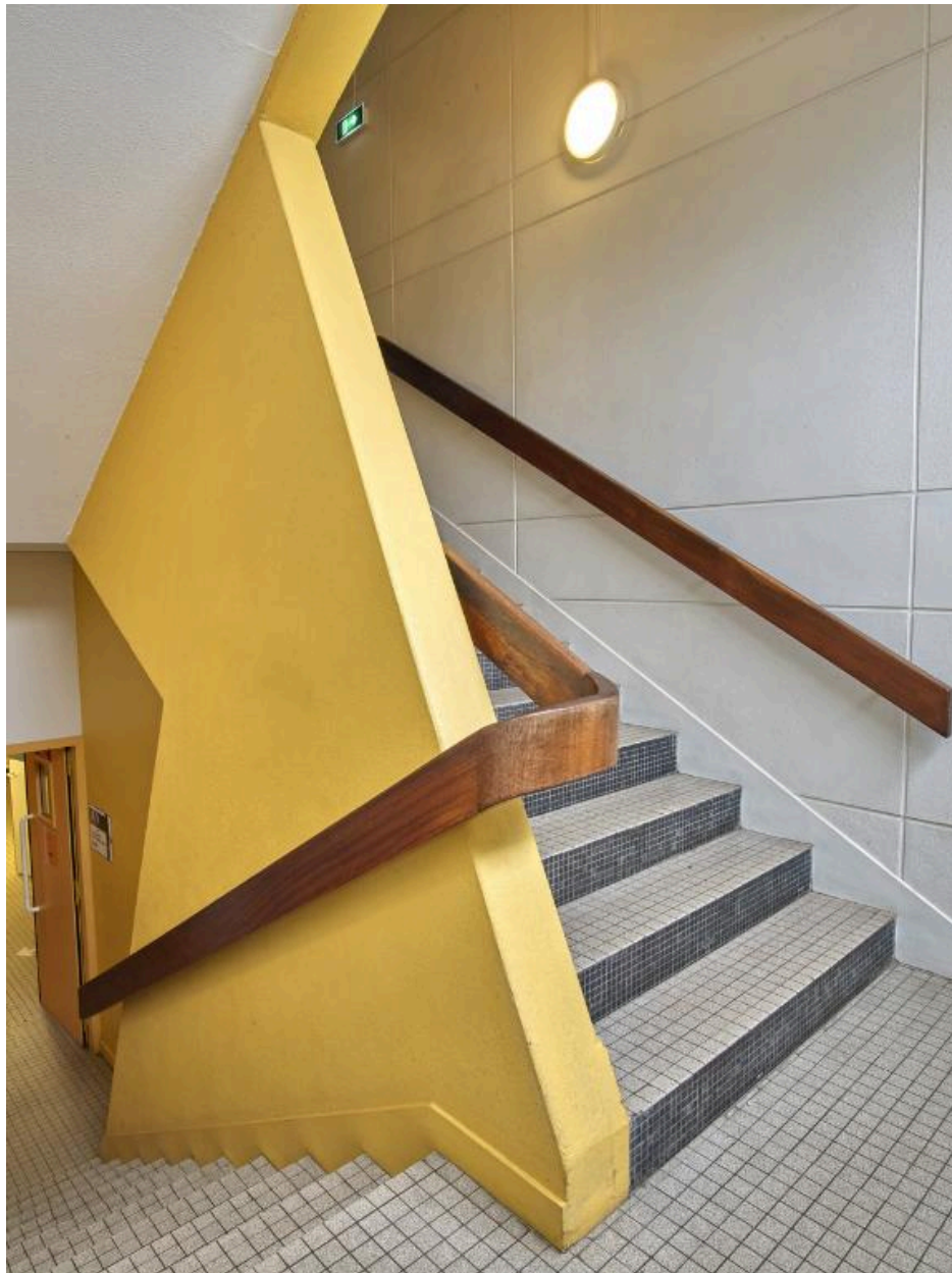
Cage d'escalier, bâtiment B. André Remondet et Patrice Simon, architectes, 1966. Noter le profil du mur d'échiffre, le retour "en ruban" de la rampe d'escalier, le sol en grès cérame et les contremarches en mosaïque.
