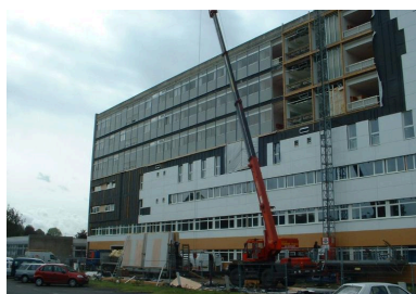
Façade est de l'internat en cours de restructuration. On aperçoit la structure après dépose des éléments de la façade rideau d'origine. Phot. Philippe Fauquert IVR53_20232205009NUC1
