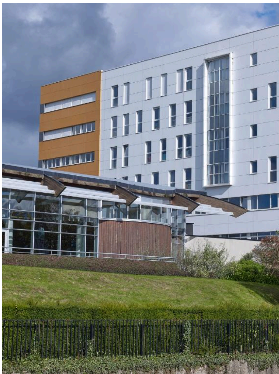
Bâtiment B (internat, logements, classes), façades ouest, détail. André Remondet et Patrice Simon, architectes, 1966. Au premier plan, piscine municipale, agrandie en 2002 (Jean-Yves Philippe et Jacky Grimault, architectes).
