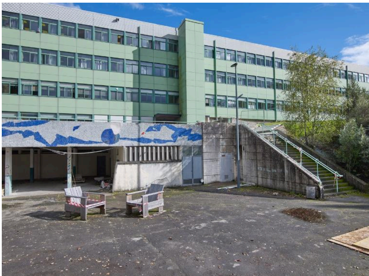
Bâtiment A (externat, administration, logements), façade ouest. André Remondet et Patrice Simon, architectes, 1961. Noter la décoration de Gustave Singier (1962).
