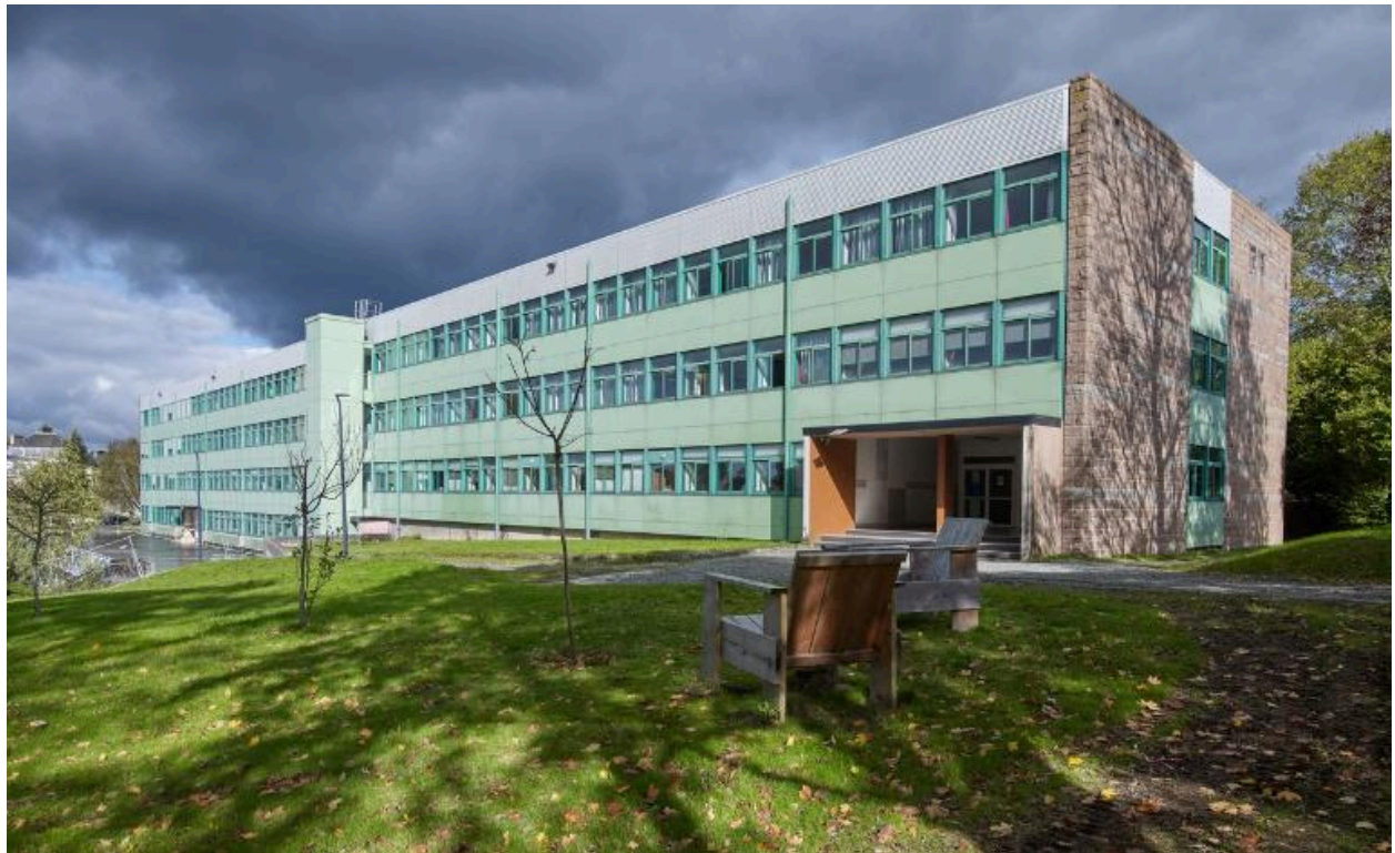
Bâtiment A (externat, administration, logements), façade ouest et pignon sud. André Remondet et Patrice Simon, architectes, 1961. Vue prise du sud-ouest, au niveau du rez-de-chaussée haut.
