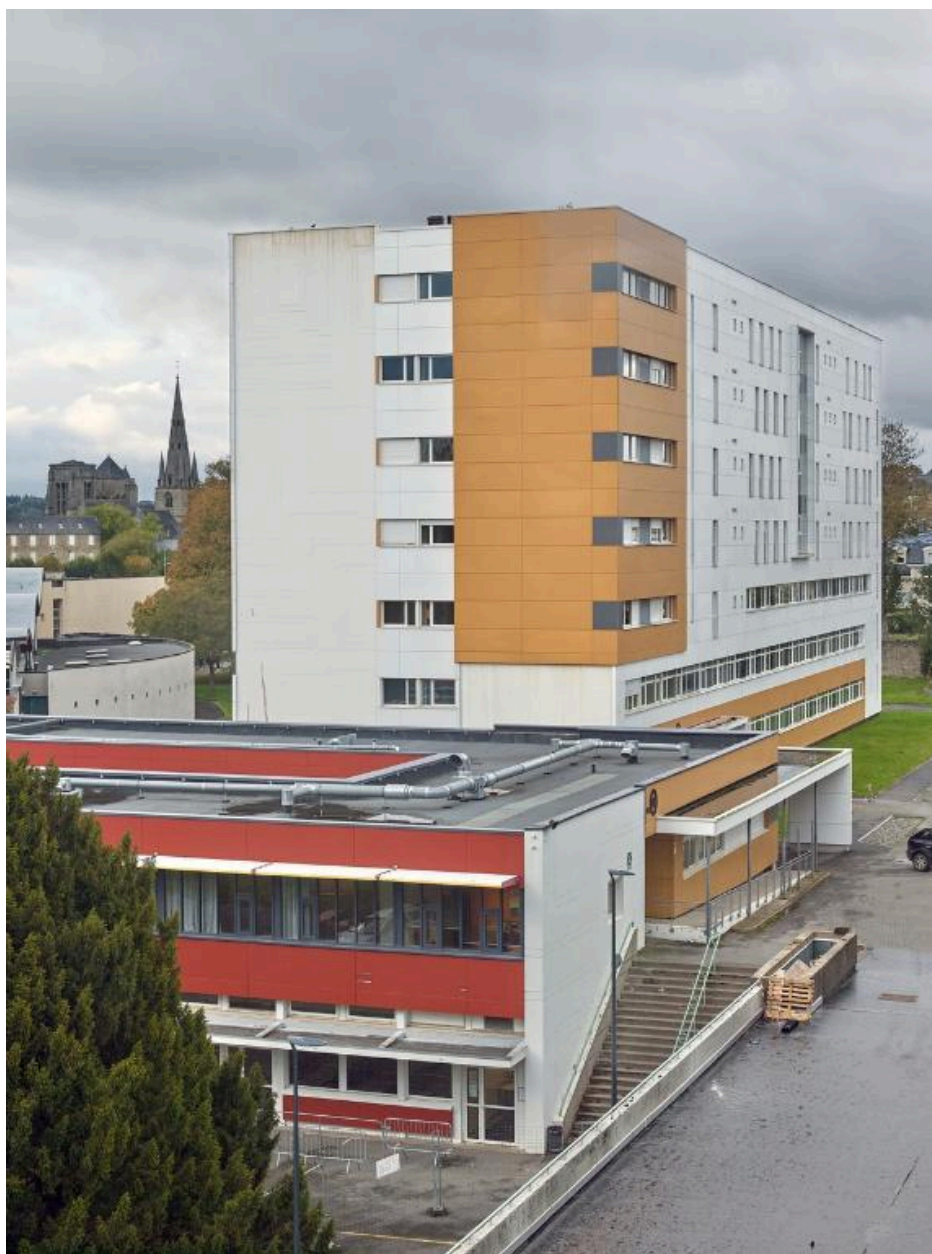
Bâtiment B (internat, logements, classes) et, au premier plan, bâtiment C (restauration, infirmerie, foyer), angles sud-est. André Remondet et Patrice Simon, architectes, 1966.
