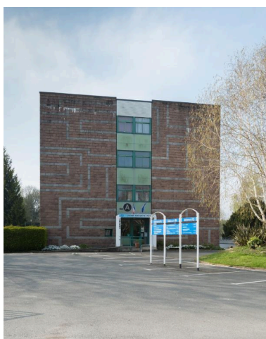
Pignon sud du bâtiment A (externat, administration, logements) : noter le soin apporté au calepinage et l'alternance de couleur du granite. (André Remondet et Patrice Simon, architectes) Phot. Charlotte Barraud IVR53_20212200124NUCA
