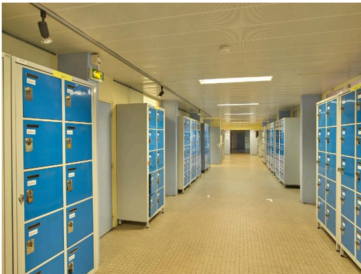
Dégagement central et casiers des élèves. Rez-de-chaussée du bâtiment A.
