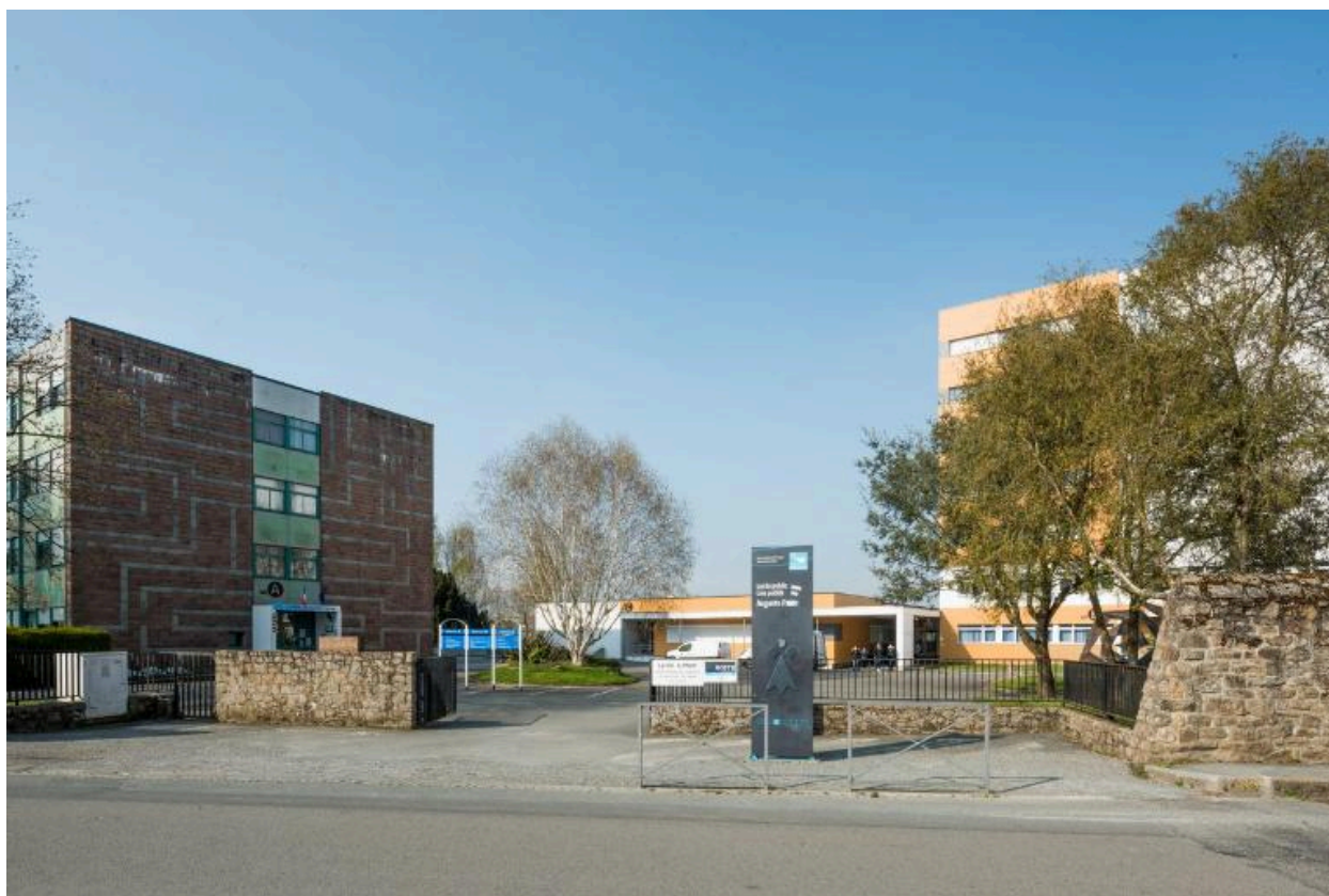
Vue d'ensemble prise devant l'entrée, depuis le nord-est. De gauche à droite, bâtiments A, C et B. (André Remondet et Patrice Simon, architectes, 1961-1966).
