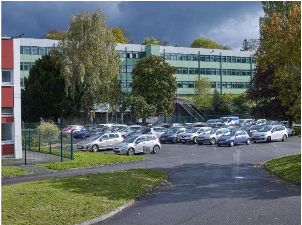
Bâtiment A (externat, administration, logements), façade ouest. André Remondet et Patrice Simon, architectes, 1961.
