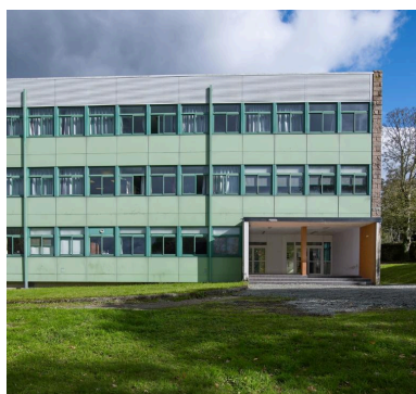
Bâtiment A (externat, administration, logements), extrémité sud de la façade ouest. André Remondet et Patrice Simon, architectes, 1961.
