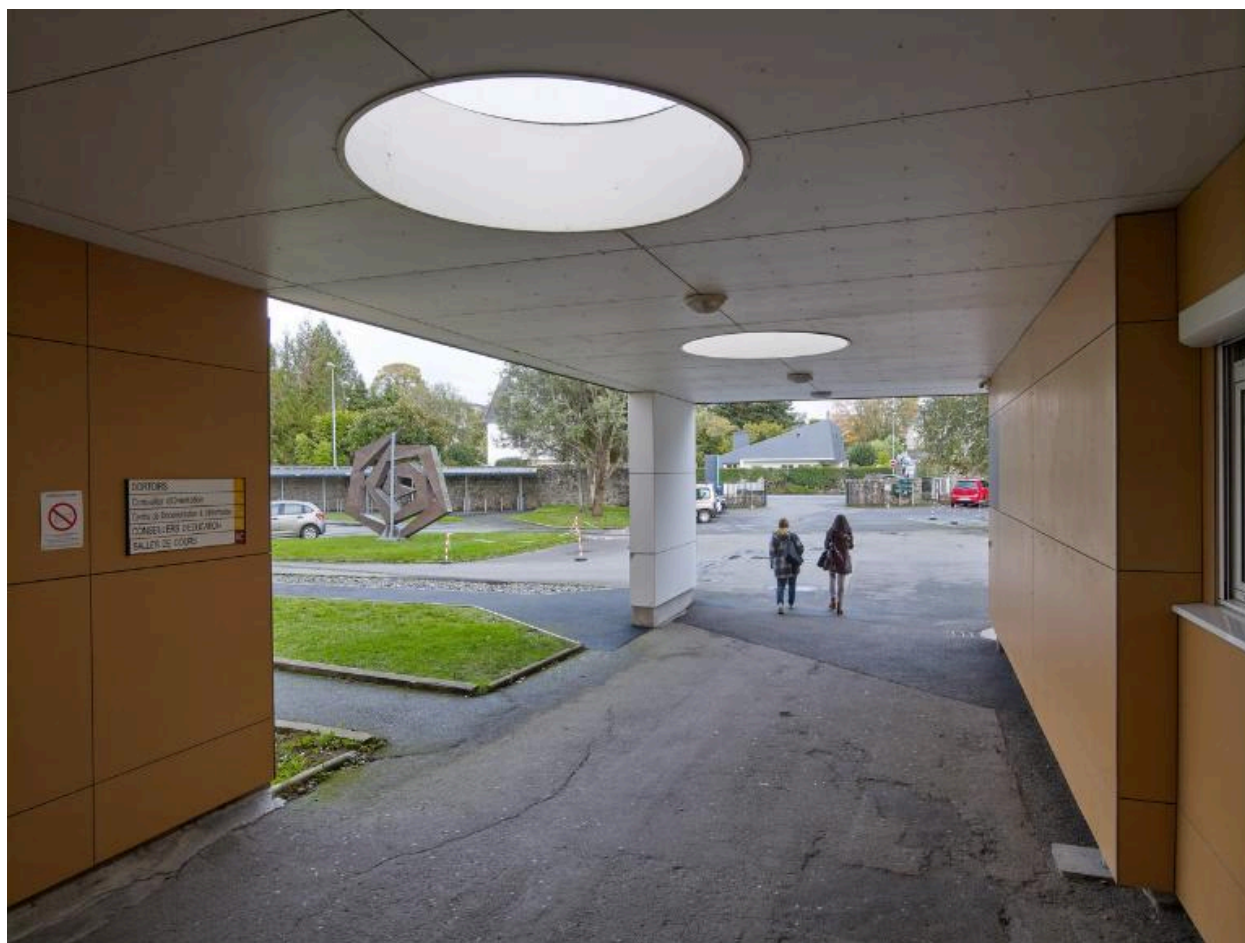
Auvent ajouté devant l'élément de liaison entre les bâtiment B et C, vue prise de l'ouest vers l'est.
