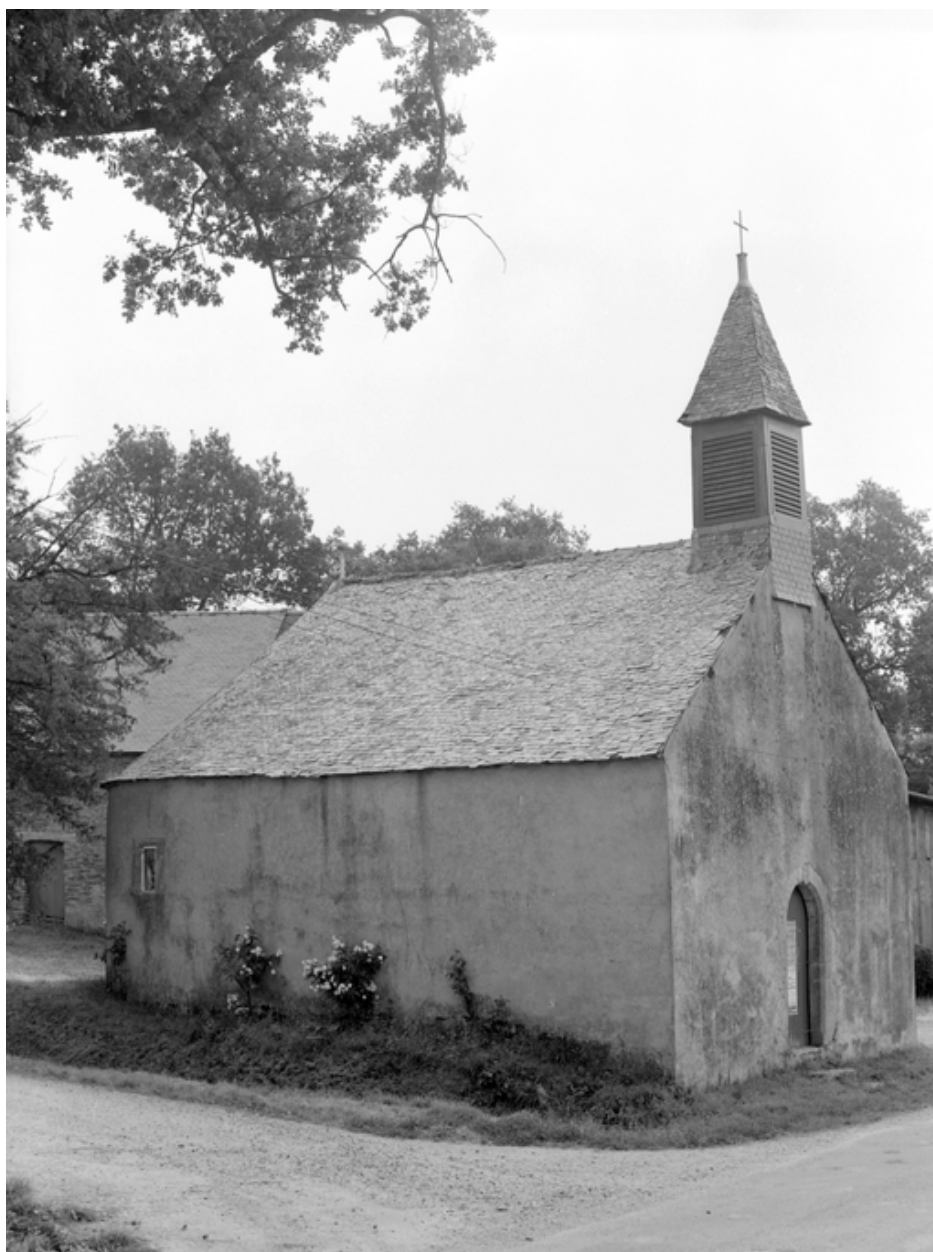
Chapelle vue nord-ouest (état en 1984)
