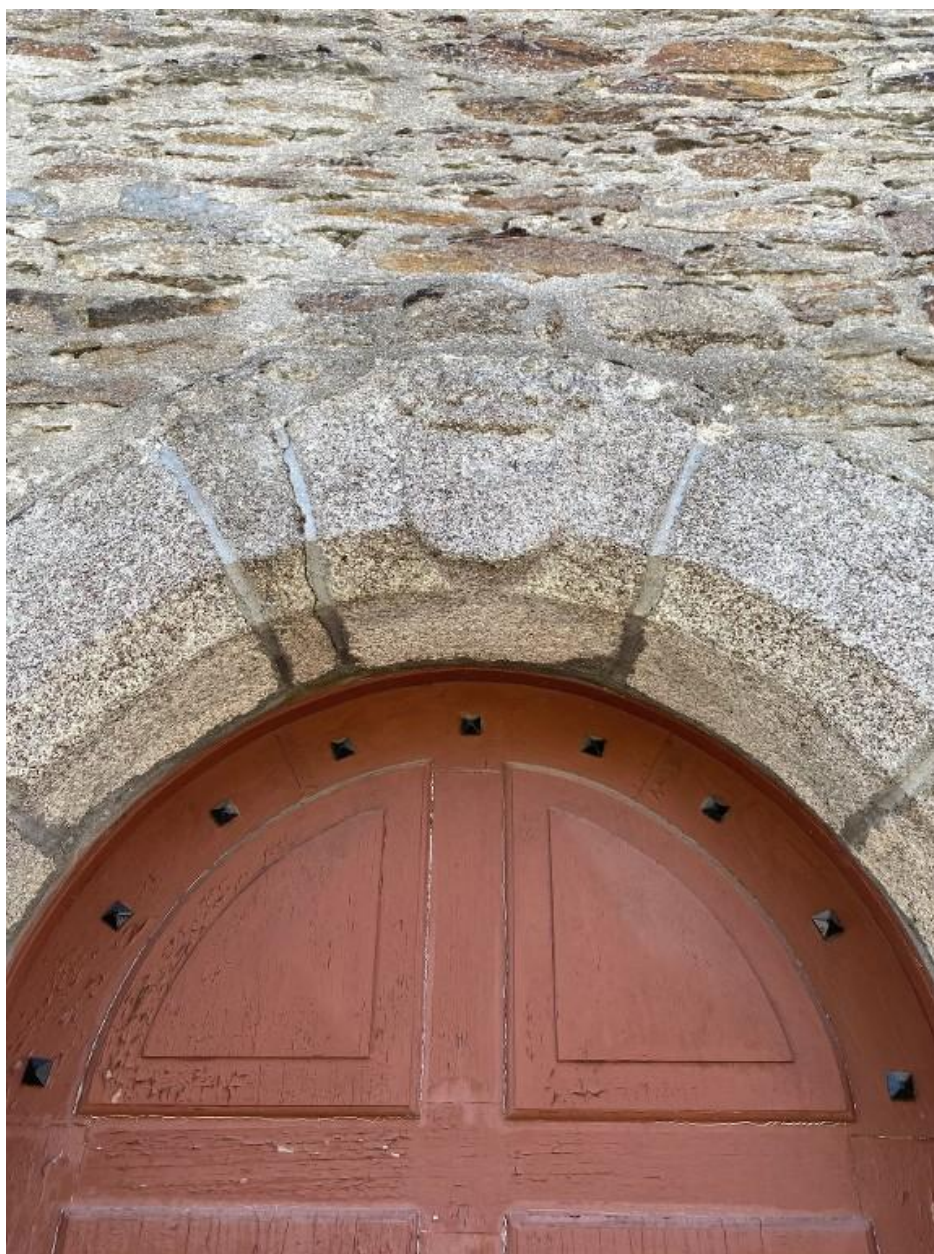
Blason sur la porte, façade ouest.
