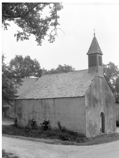
Chapelle vue nord-ouest (état en 1984) Phot. Norbert Lambart IVR53_19845601669X
