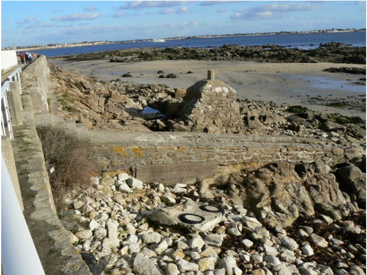
Vue latérale de la rampe et de la borne géodésique du fort de Locqueltas
