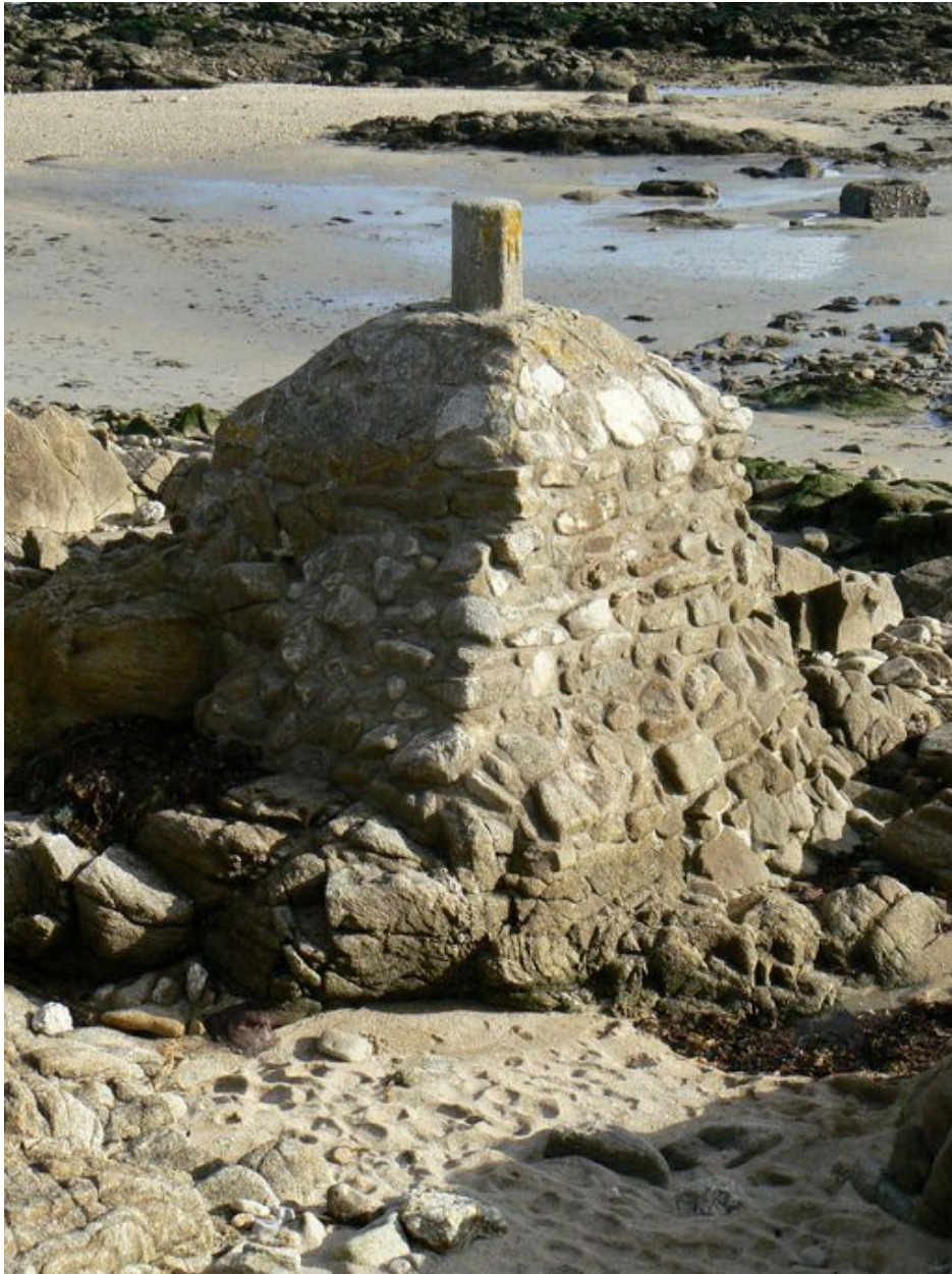
Vue générale de la borne géodésique du fort de Locqueltas
